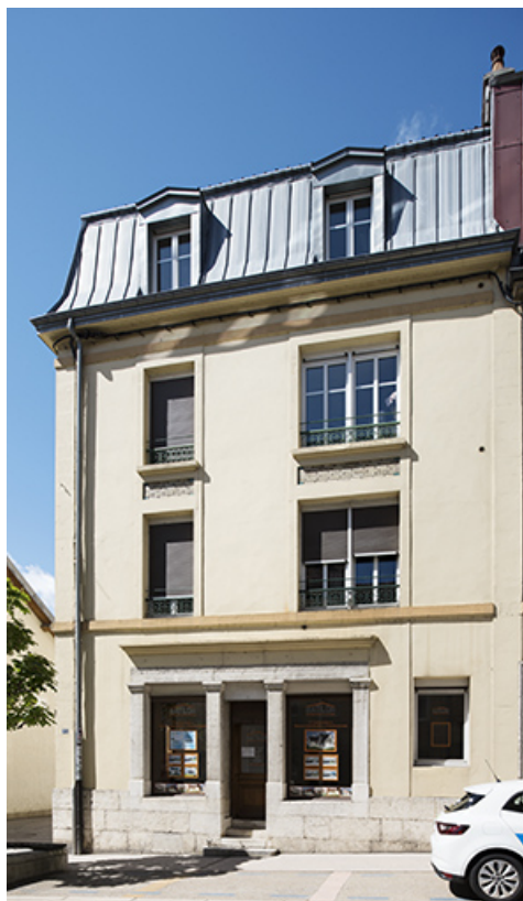
Partie gauche (5 bis) de la façade antérieure. 25, Morteau, 5 bis et 7 Grande Rue
