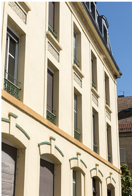
Façade latérale gauche : détail des baies.
