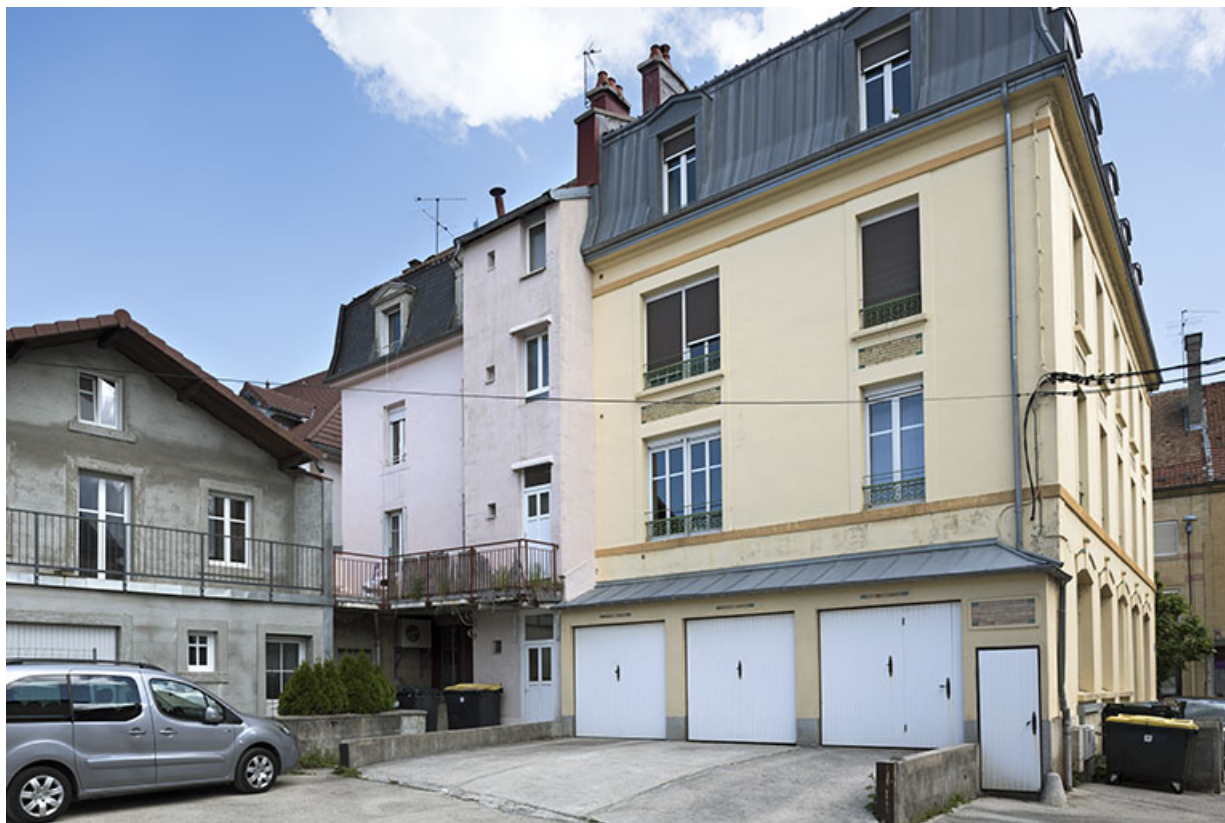
Façade postérieure, de trois quarts droite. 25, Morteau, 5 bis et 7 Grande Rue
