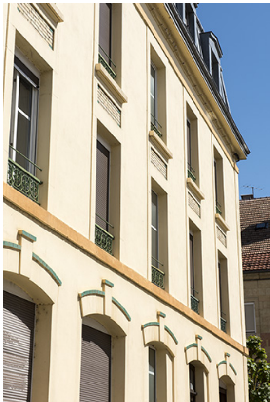
Façade latérale gauche : détail des baies.
