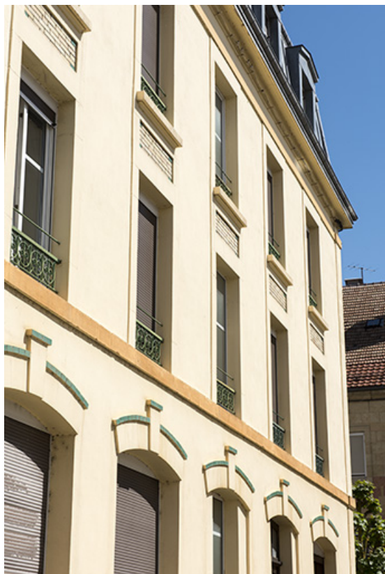
Façade latérale gauche : détail des baies.
