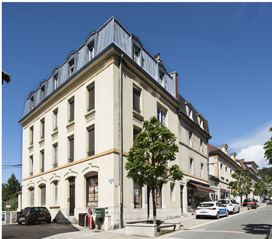
Immeuble et maison, ateliers d'horlogerie Dornier, et Aeschlimann et Monbaron, 5 bis et 7 Grande Rue. 25, Morteau
