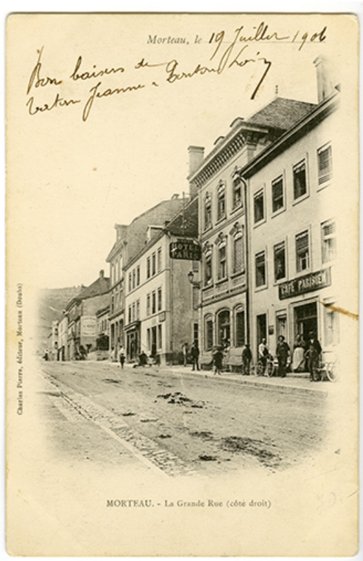
Morteau. - La Grande Rue (côté droit), 4e quart 19e siècle. Le bâtiment ne compte que deux étages. 25, Morteau, 14 et 14 bis Grande Rue
