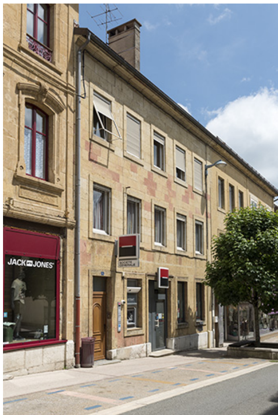
Façade antérieure, de trois quarts gauche. 25, Morteau
