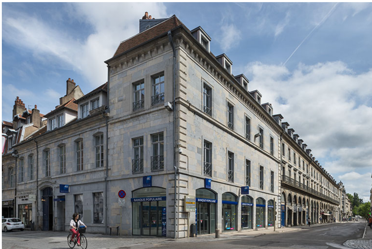
Vue d'ensemble depuis l'intersection des rues des Granges et de la République.
