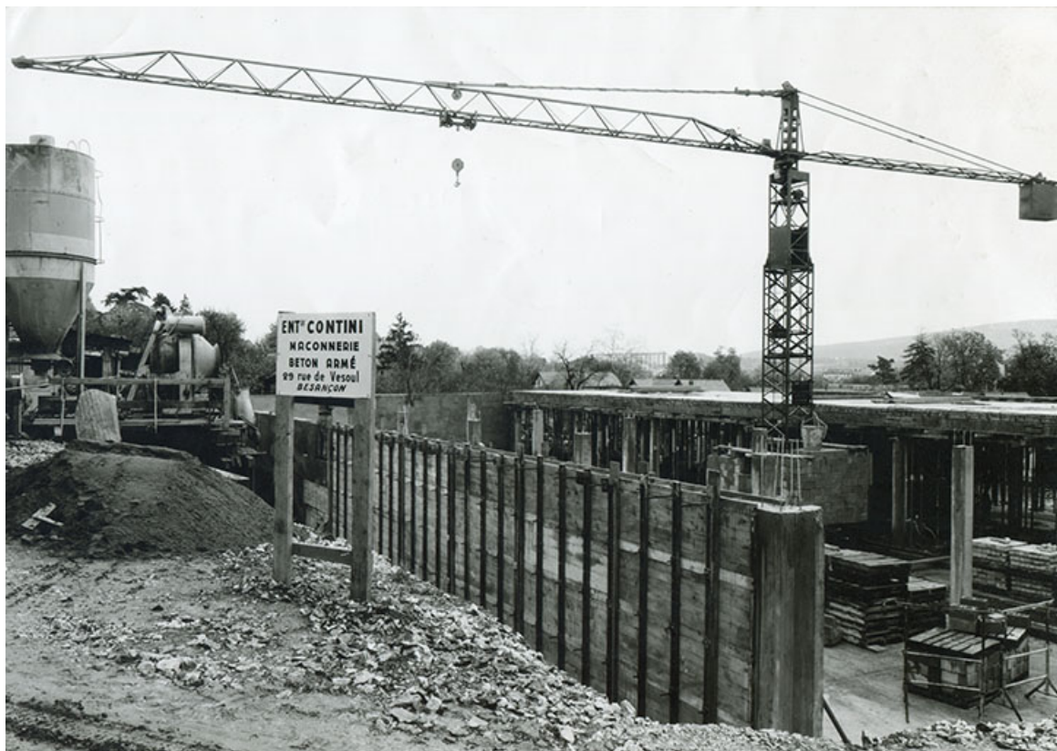
Chantier de construction de l'usine B, fotogr., 1961.
