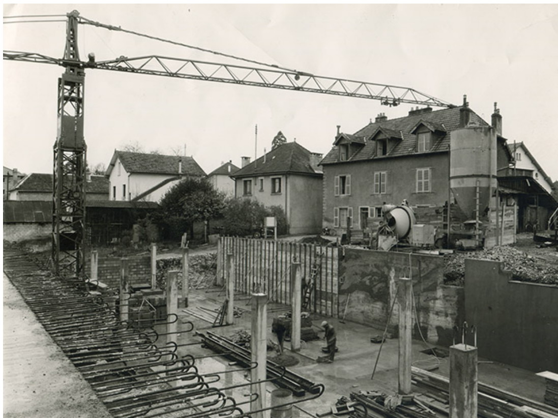
Chantier de construction de l'usine B, fotogr., 1961.
