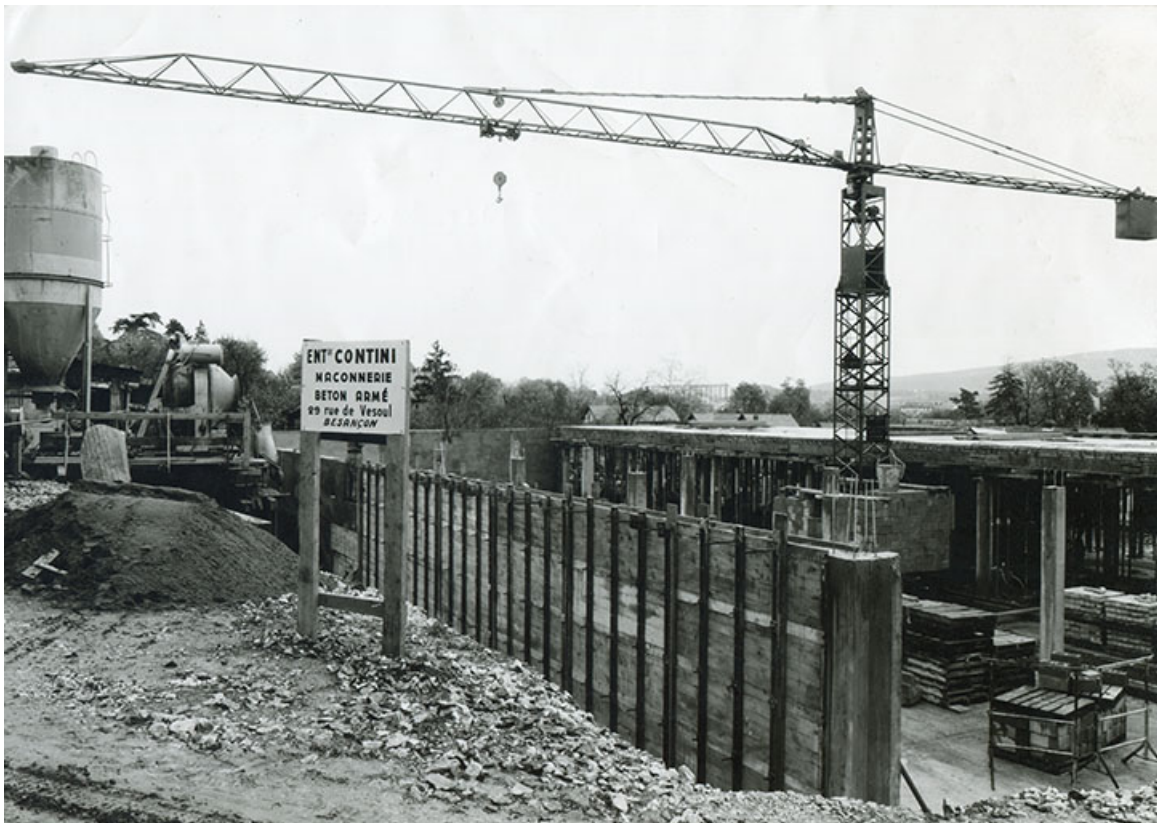
Chantier de construction de l'usine B, fotogr., 1961.
