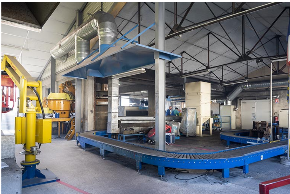
Intérieur de l'atelier au rez-de-chaussée : le convoyeur dans la zone de coulée. 25, Les Fins, 4 route de Morteau
