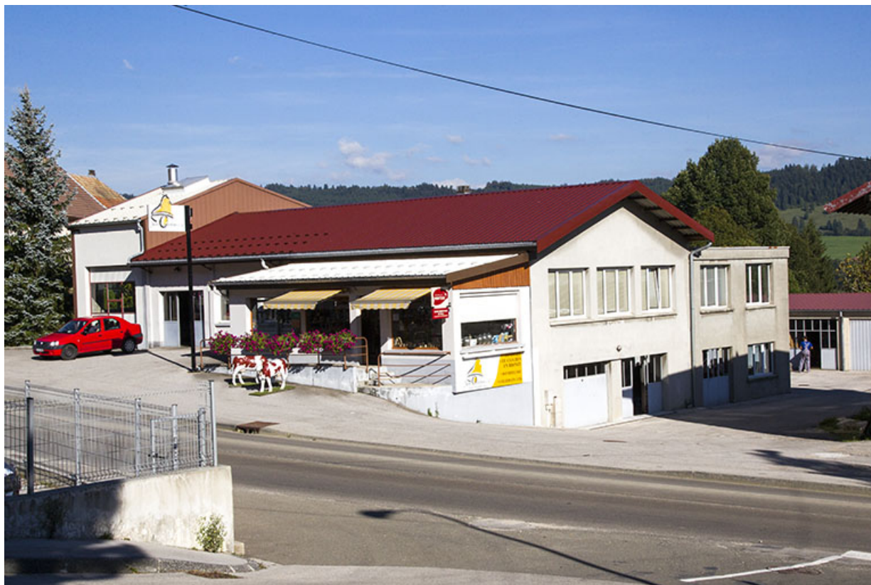
Nouveau site : vue d'ensemble de trois quarts droite en 2013.
