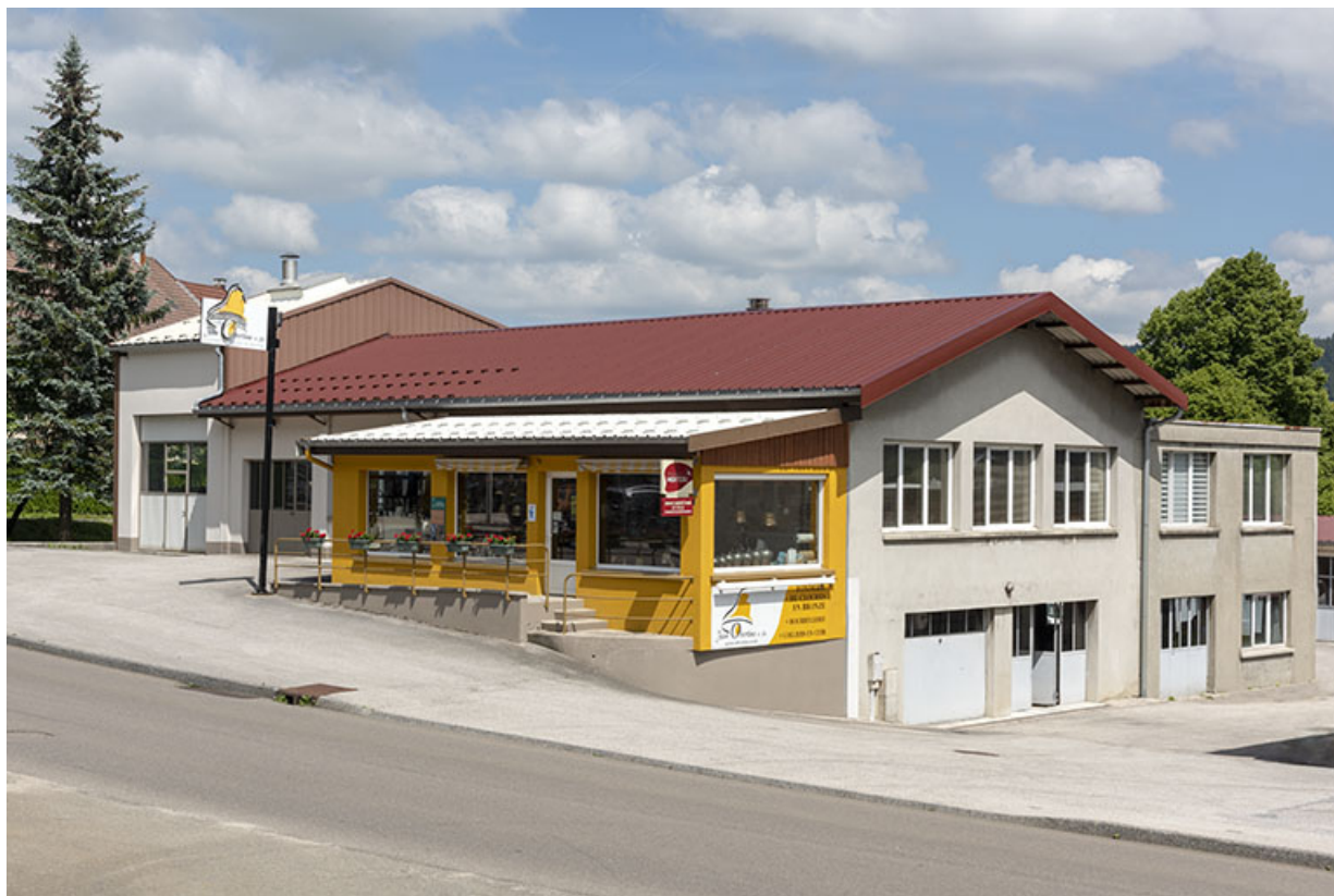
Nouveau site : vue d'ensemble de trois quarts droite.
