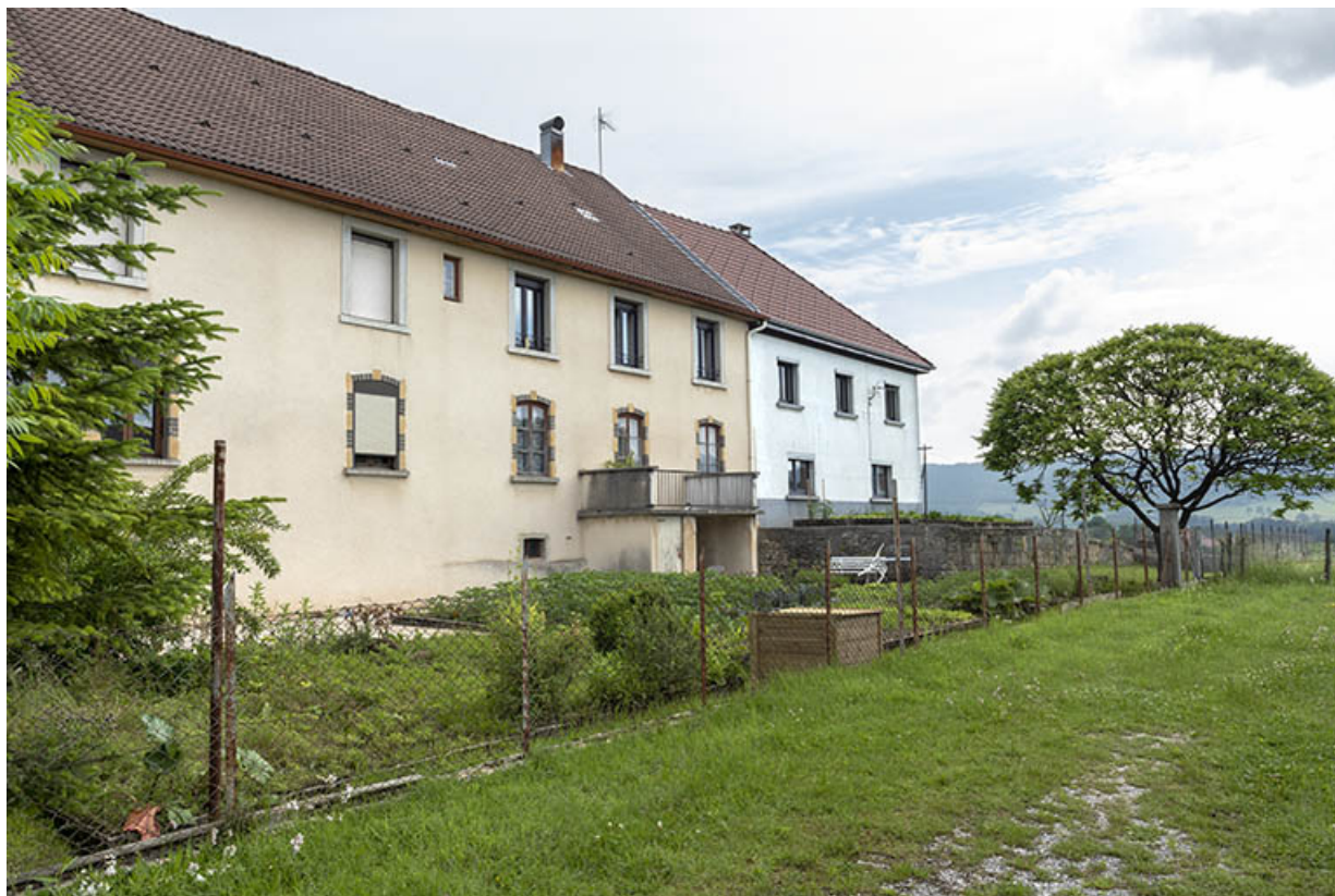
Ancien site : façade postérieure, de trois quarts gauche. 25, Les Fins, 4 route de Morteau
