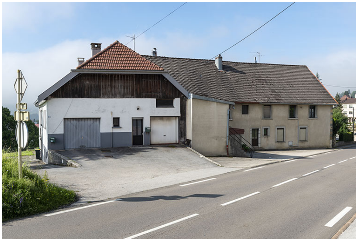
Ancien site : vue d'ensemble, depuis le nord.
