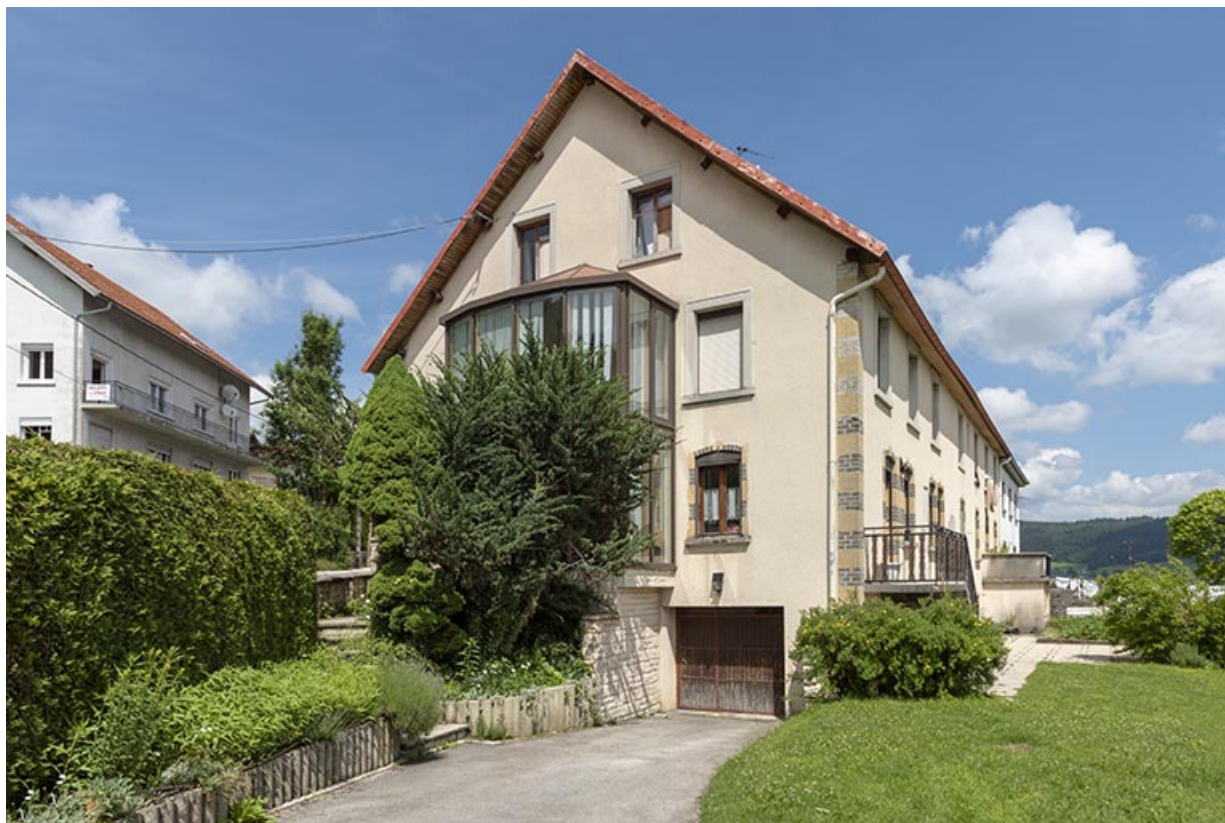
Ancien site : façades latérale droite et postérieure.
