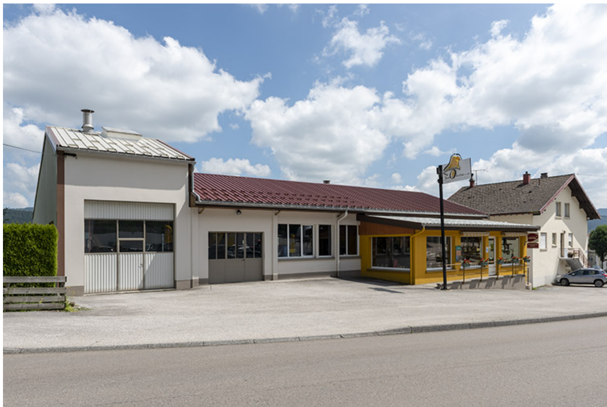
Nouveau site : vue d'ensemble de trois quarts gauche.
