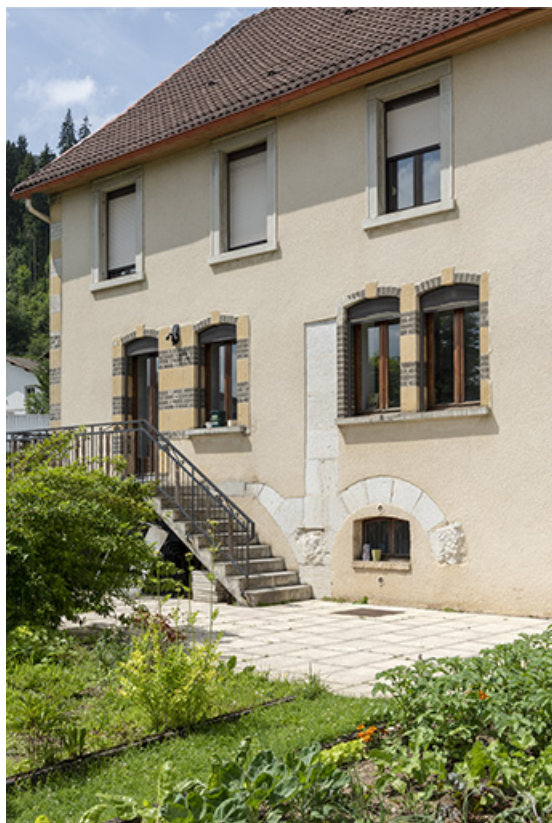
Ancien site : partie gauche de la façade postérieure. 25, Les Fins, 4 route de Morteau
