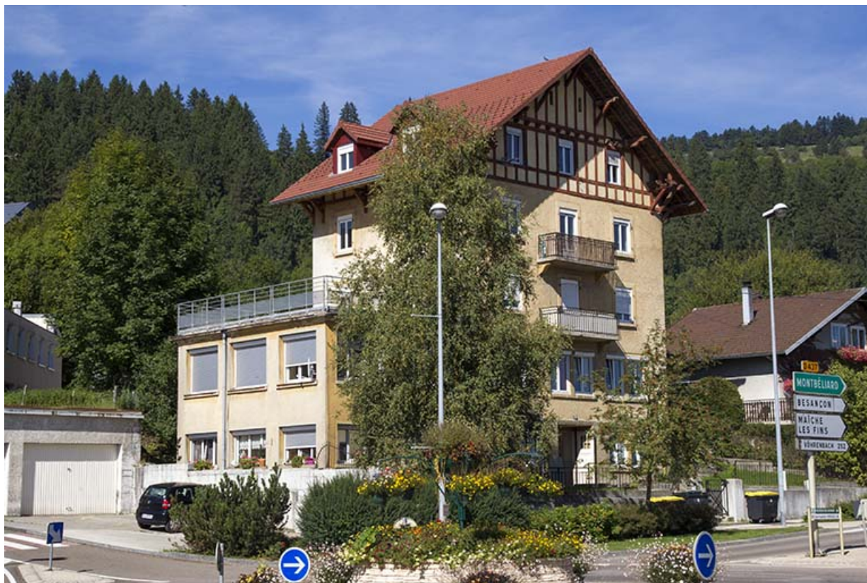
Façades antérieure et latérale gauche.
