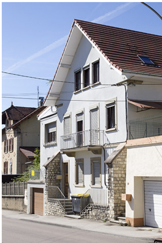
Façade antérieure, vue en enfilade de trois quarts droite.
