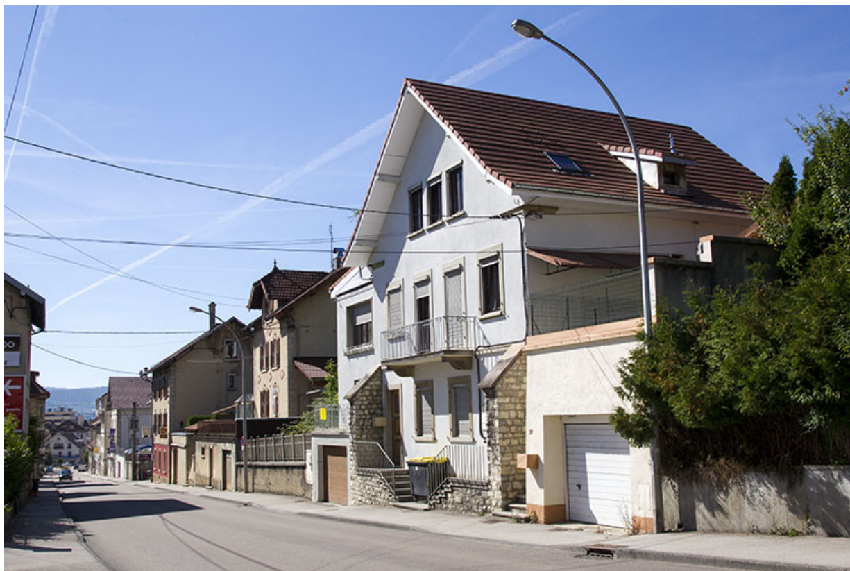
Vue d'ensemble, depuis le nord-est. 25, Morteau, 25-27 rue de la Louhière
