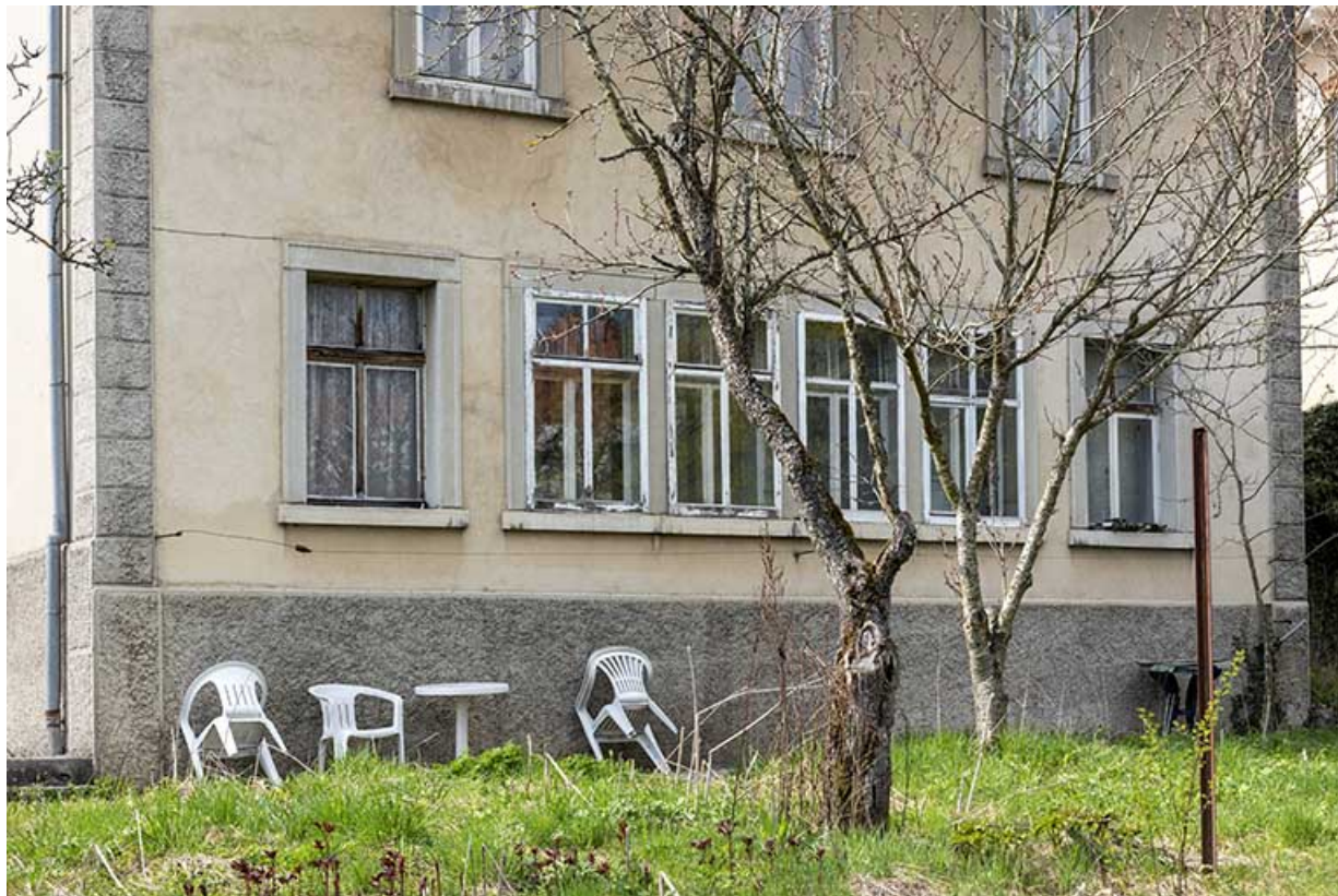
Façade postérieure : fenêtres multiples de l'atelier.
