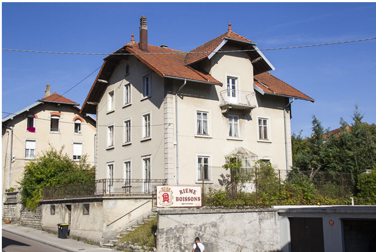
Façades antérieure et latérale droite.
