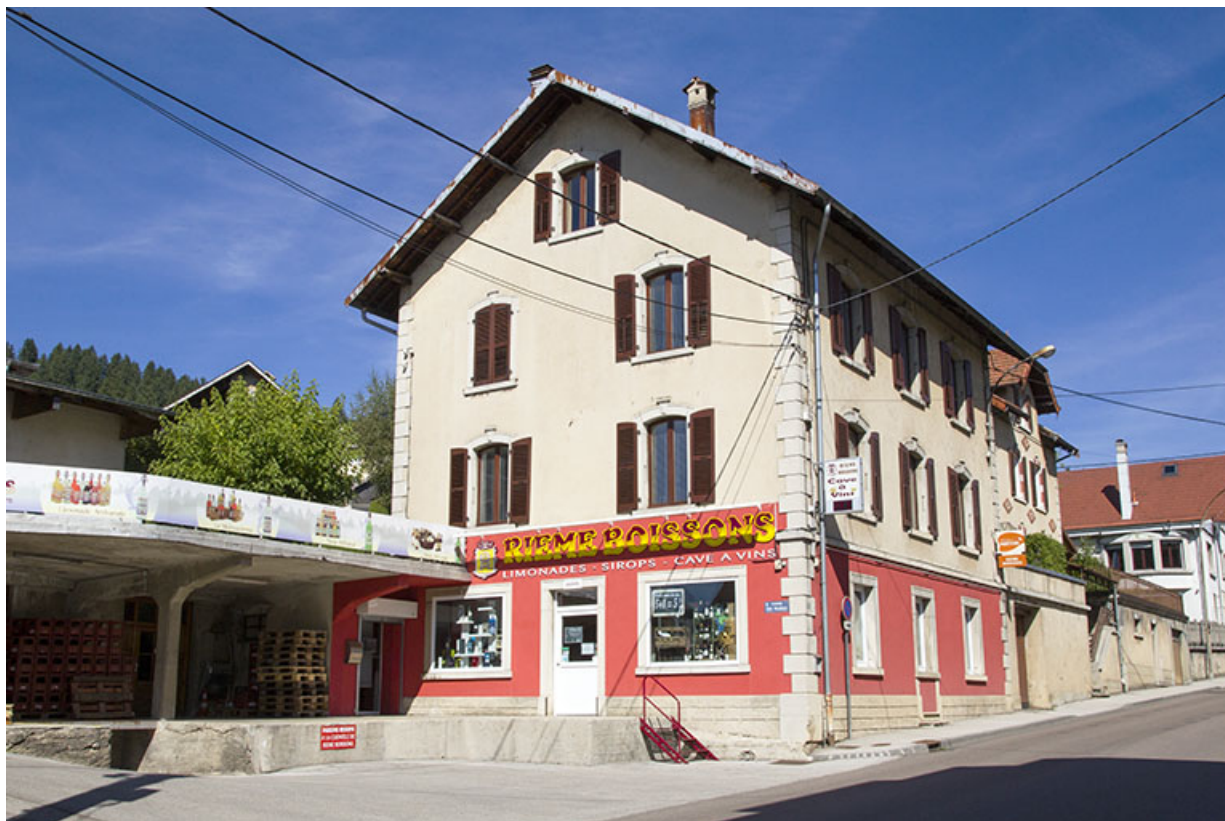
Maison (façades antérieure et latérale gauche) et quais de chargement.
