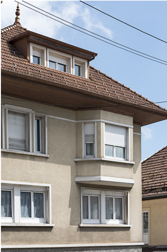
Façade antérieure : baies des étages et oriel. 25, Morteau, 20 rue de la Louhière
