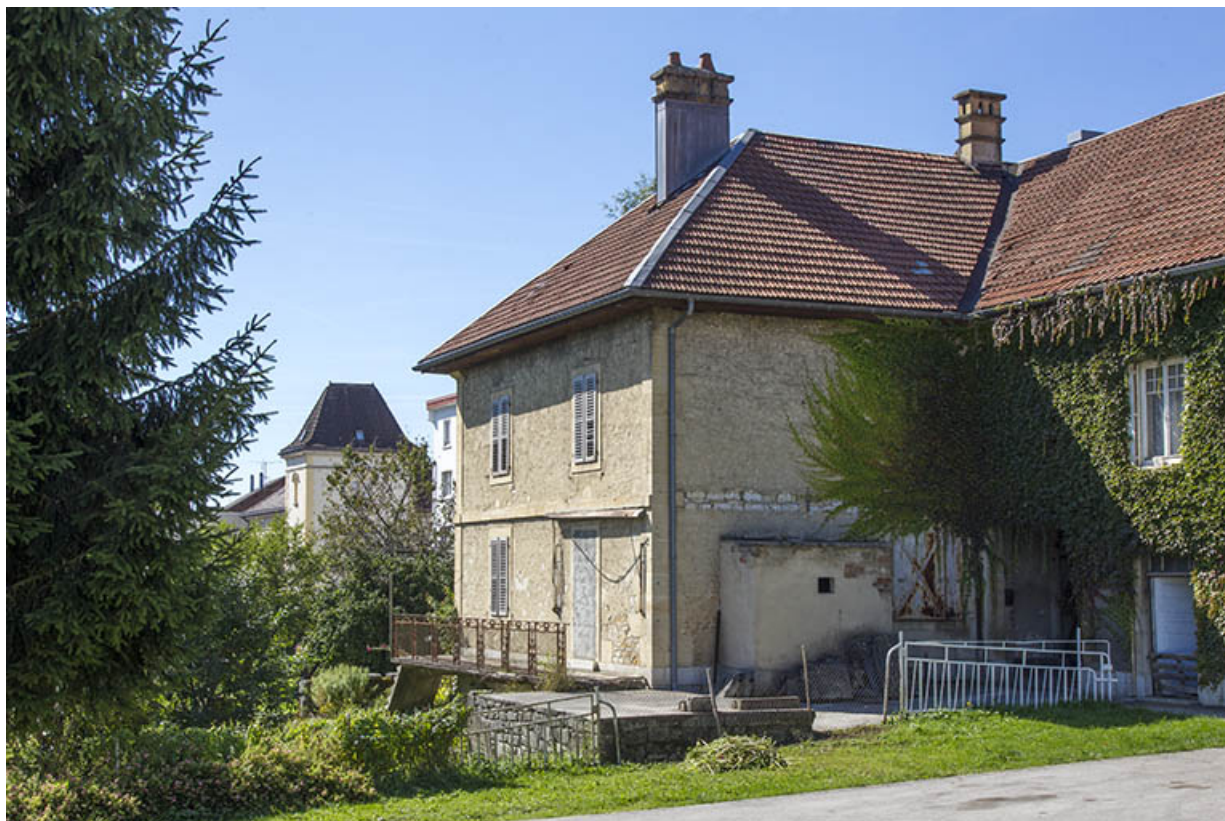
Corps sud : façades postérieure et latérale gauche.
