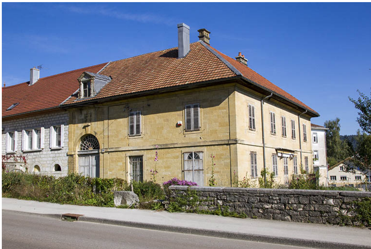
Corps sud : vue d'ensemble, depuis le sud-ouest.
