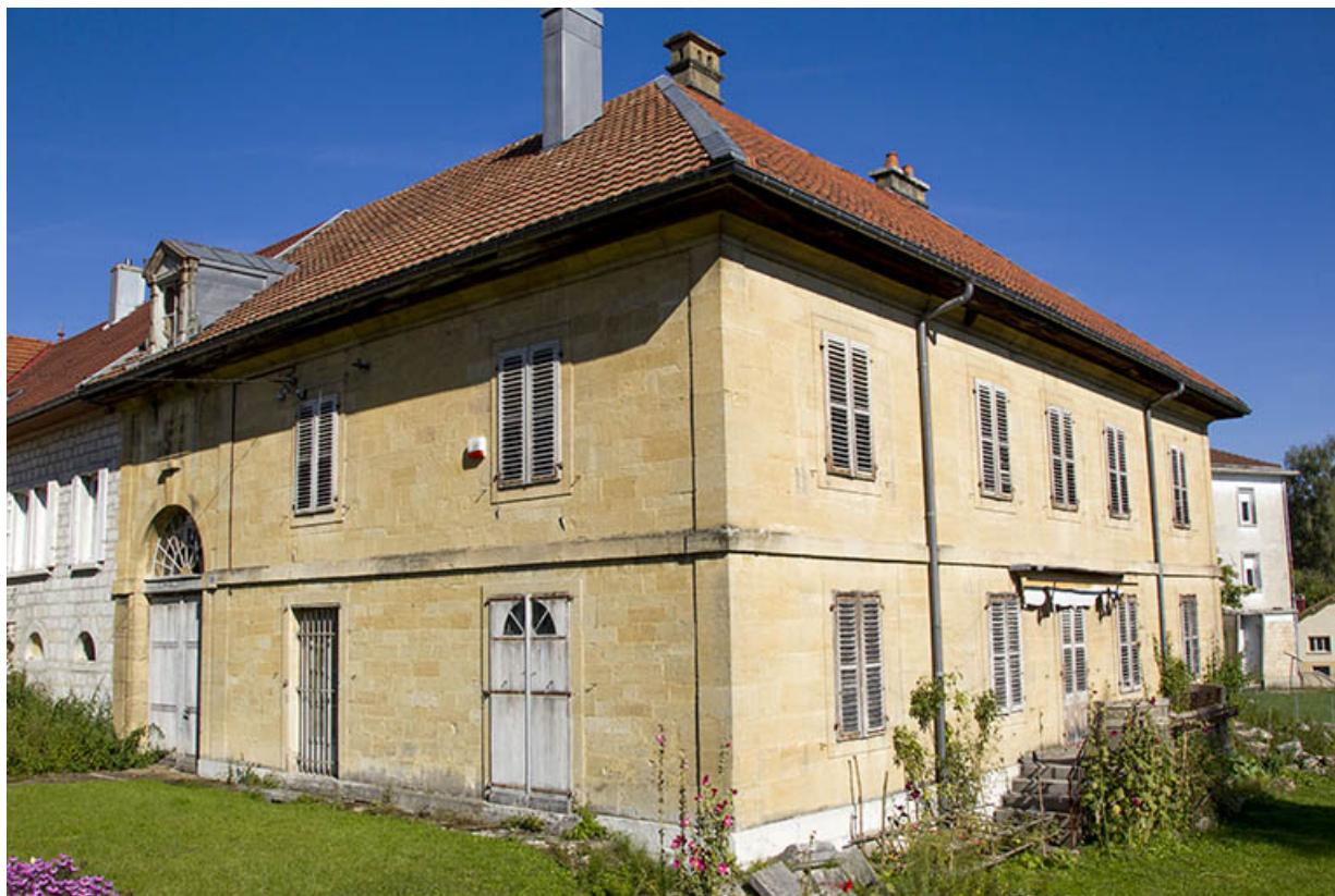
Corps sud : façades antérieure et latérale droite.
