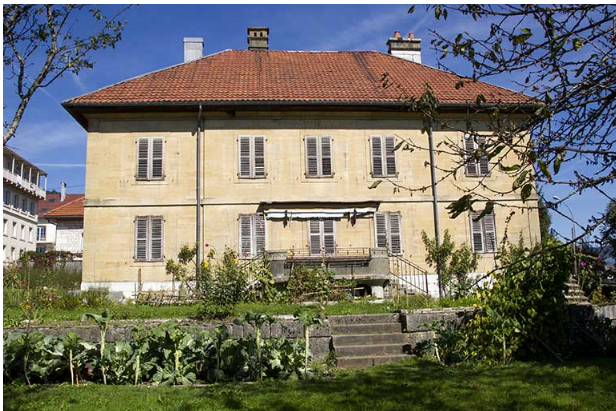
Corps sud : façade latérale droite.
