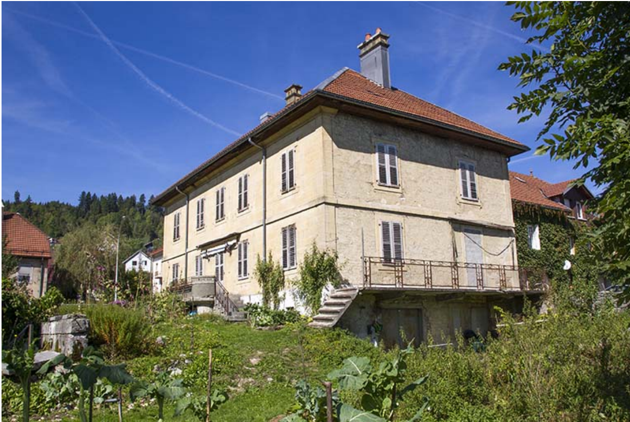
Corps sud : façades postérieure et latérale droite.
