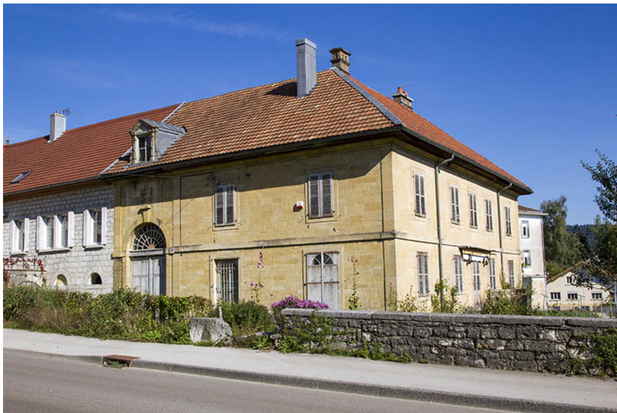
Corps sud : vue d'ensemble, depuis le sud-ouest.
