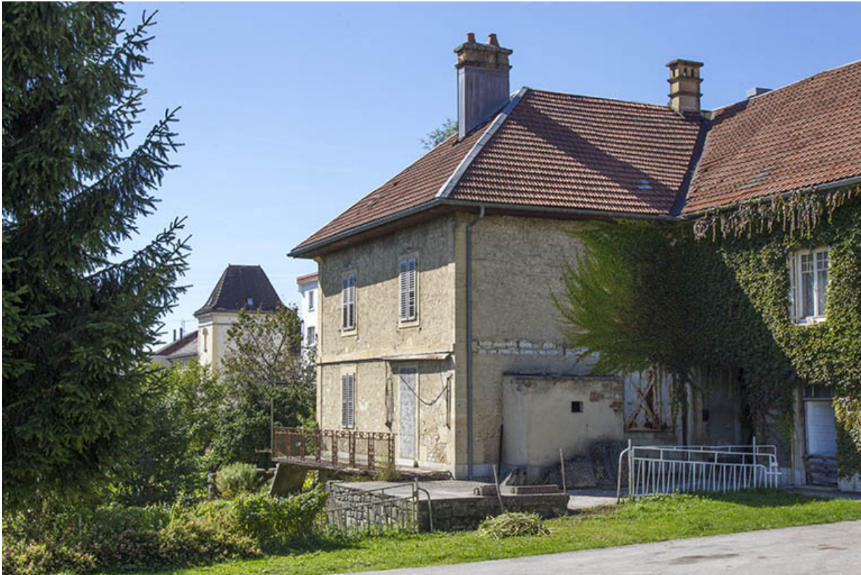
Corps sud : façades postérieure et latérale gauche.
