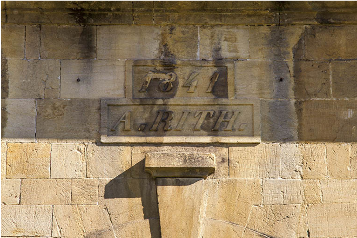
Corps sud, façade antérieure : date et inscription au-dessus de l'entrée de la grange. 25, Morteau, 8-10 rue de la Louhière
