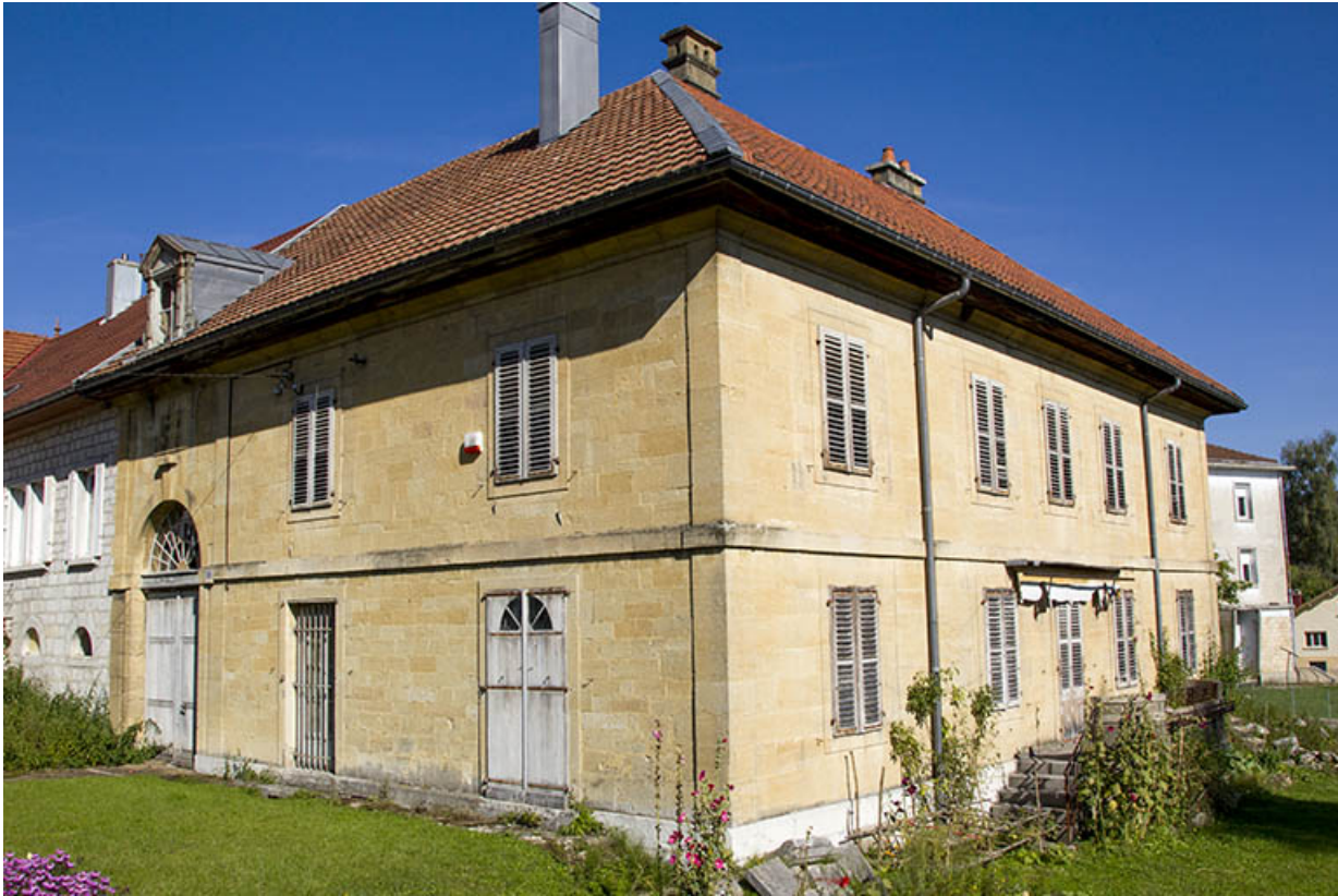
Corps sud : façades antérieure et latérale droite.
