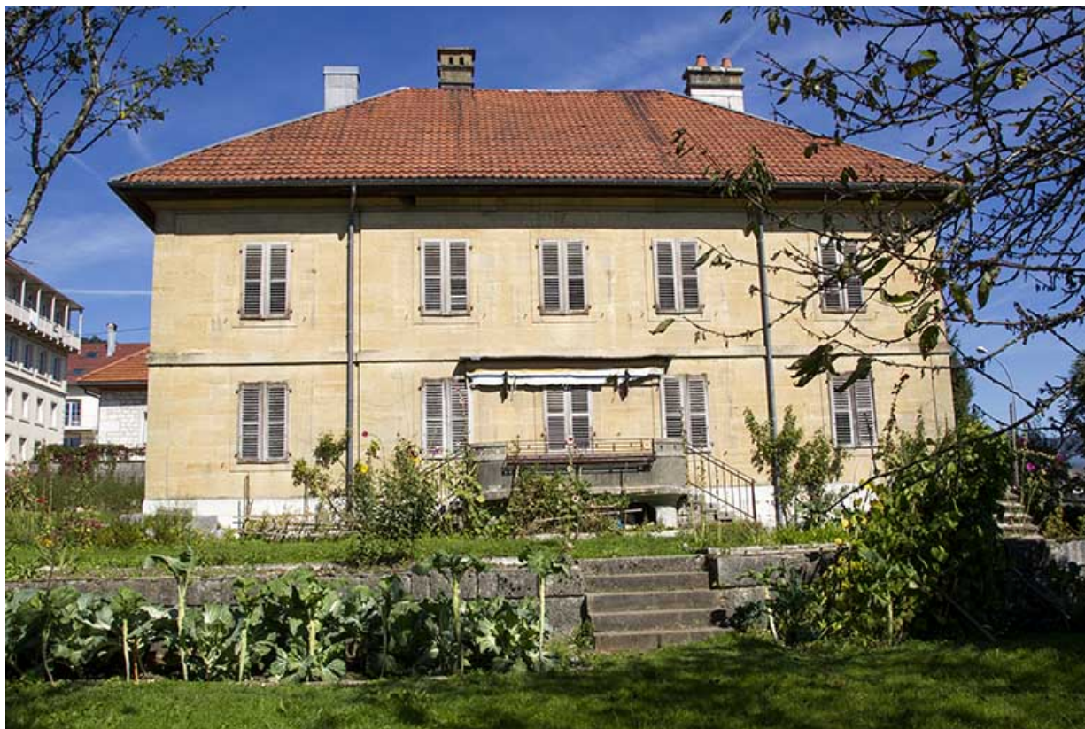
Corps sud : façade latérale droite.
