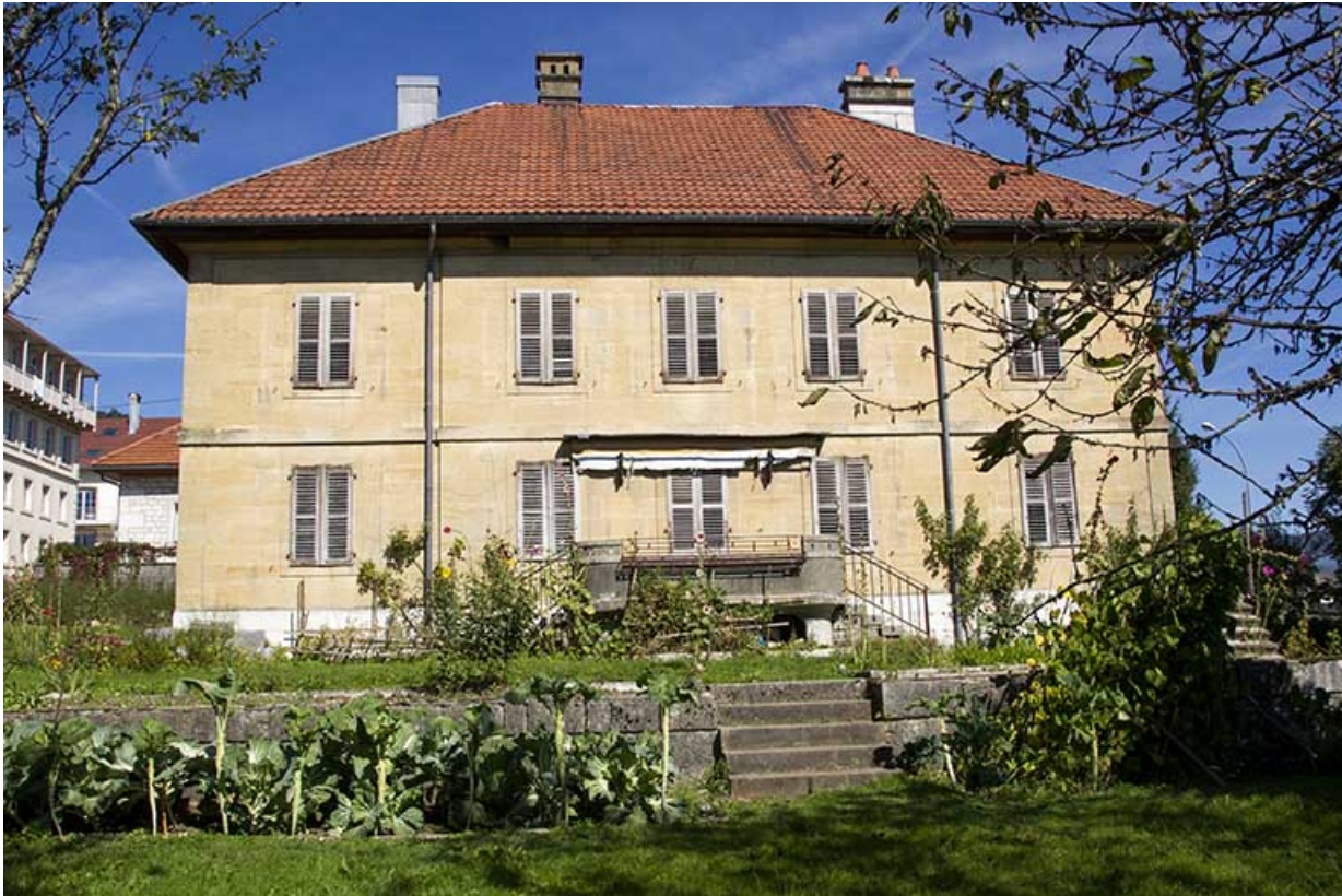
Corps sud : façade latérale droite.
