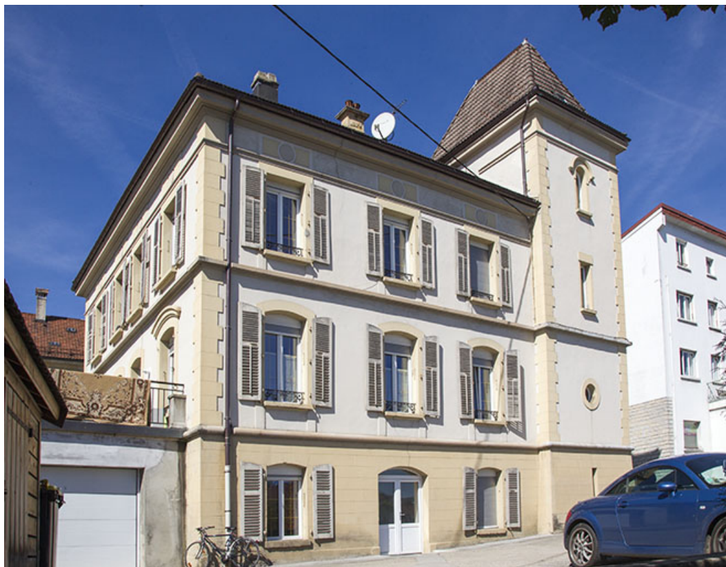
Façades postérieure et latérale droite.
