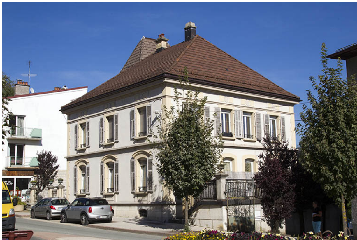
Façades antérieure et latérale droite.
