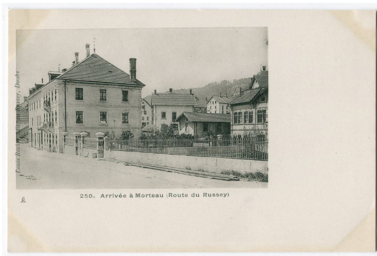
250. Arrivée à Morteau (route du Russey), 4e quart 19e siècle. L'usine Friez est partiellement visible à droite. 25, Morteau, 3-5 chemin des Lilas
