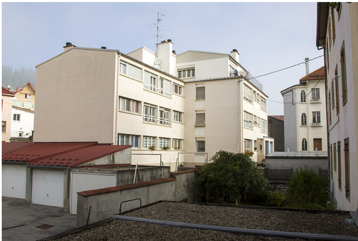
Bâtiment sud : vue d'ensemble, depuis le sud.
