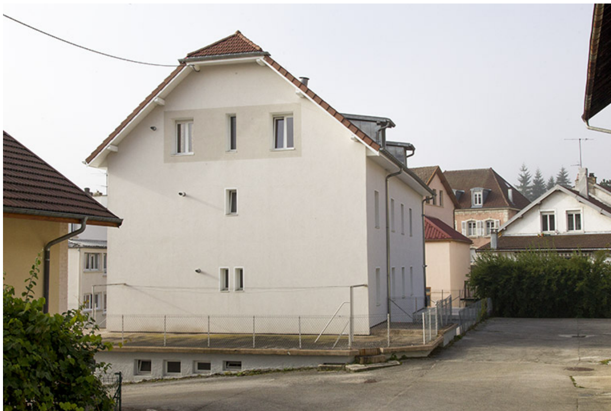
Bâtiment nord : façades latérale droite et postérieure.
