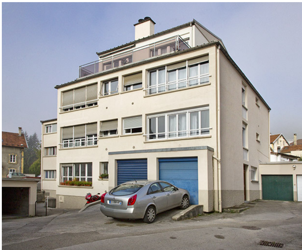
Bâtiment sud : façades antérieure et latérale droite.
