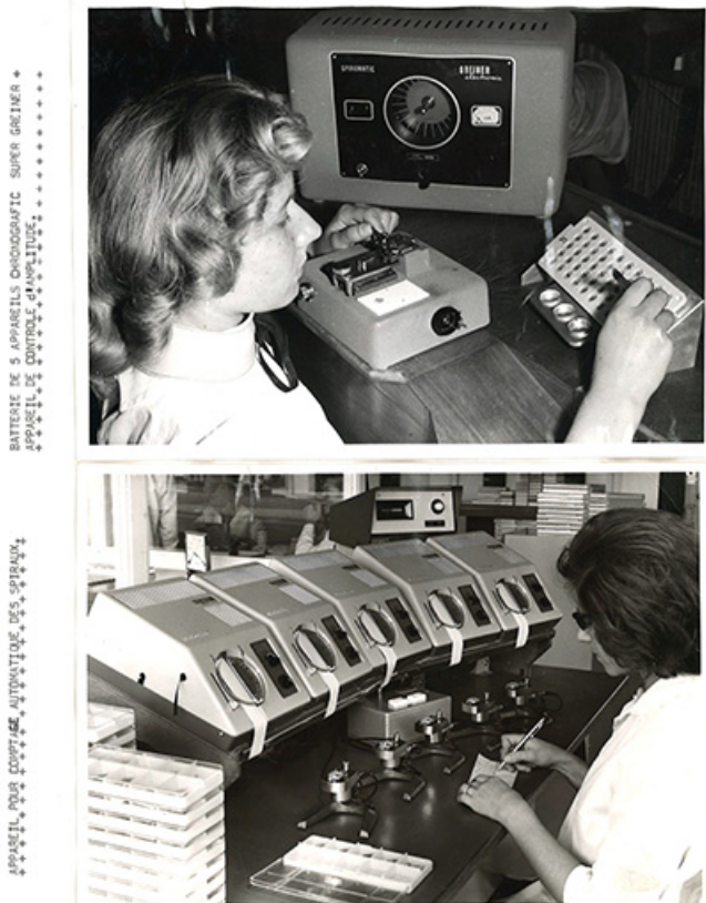
Société Yema : appareils de contrôle d'amplitude et de comptage automatique des spiraux, fotogr., s.d. [vers 1970]. 25, Besançon, 67 rue des Cras
