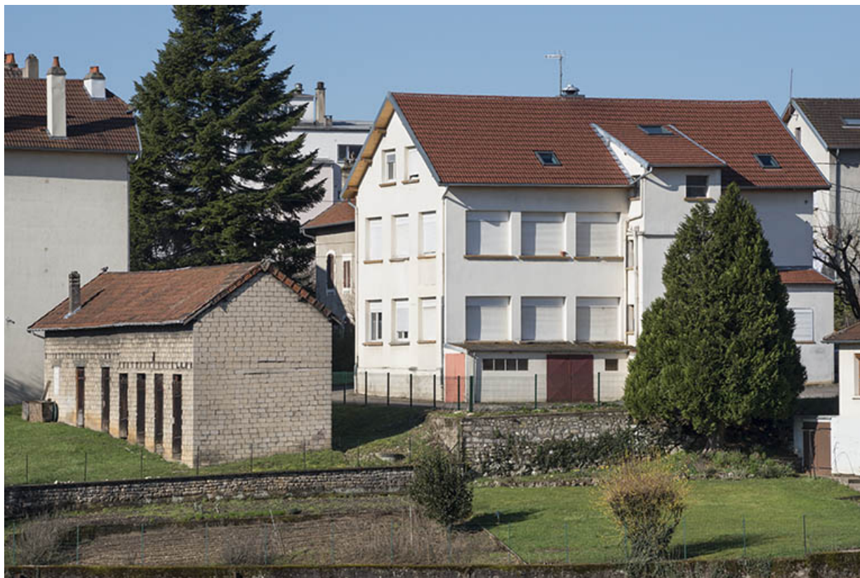
Façade postérieure depuis l'est.
