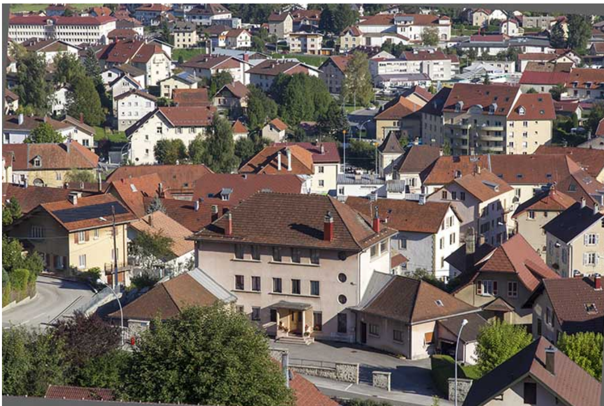
Vue d'ensemble plongeante, depuis le nord-ouest.
