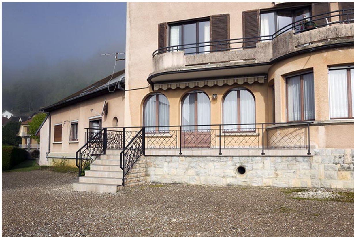
Baies du rez-de-chaussée de la façade postérieure et terrasse.
