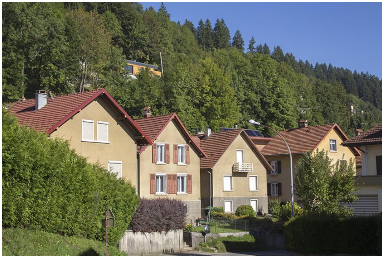
Vue d'ensemble, depuis le sud. La maison, dont on voit la façade postérieure, a des volets en bois. 25, Morteau
