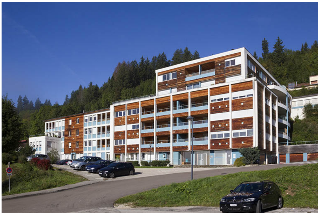
Vue d'ensemble rapprochée, depuis le sud-est. 25, Morteau
