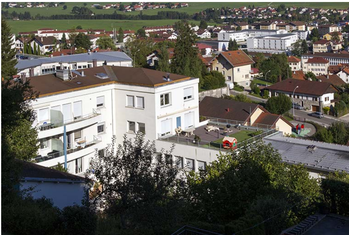
Façades postérieure et latérale gauche (vue plongeante).
