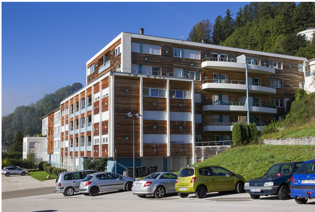
Façades antérieure et latérale droite.
