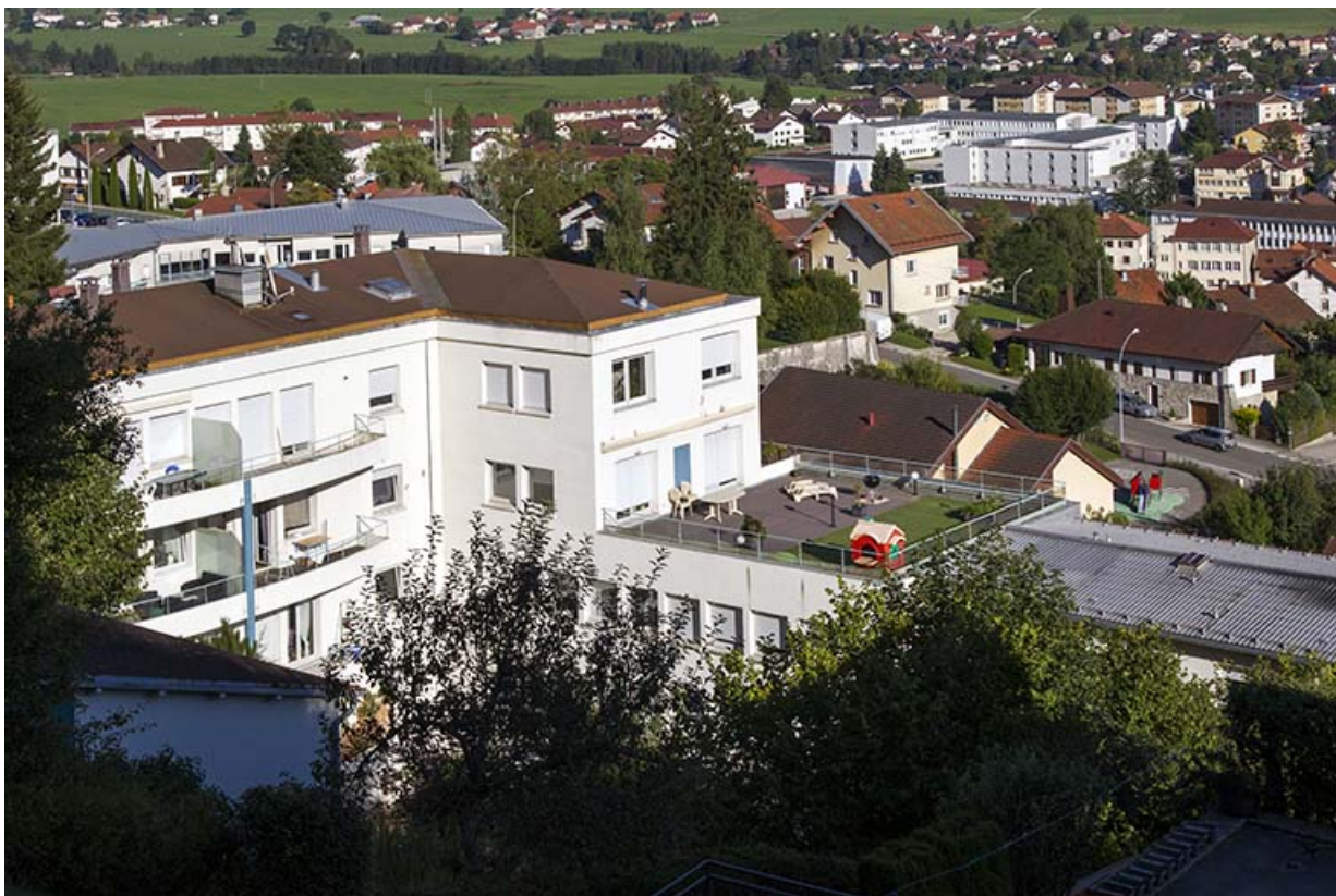
Façades postérieure et latérale gauche (vue plongeante).
