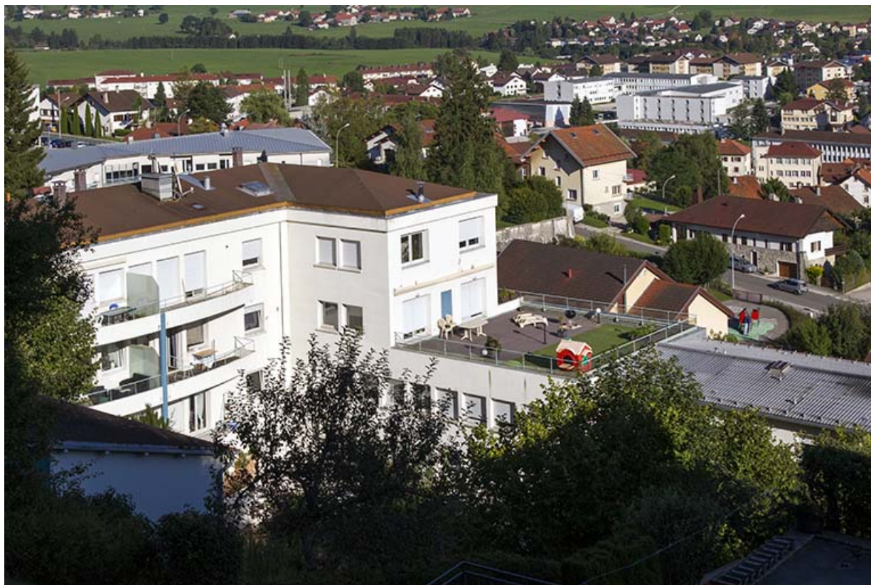
Façades postérieure et latérale gauche (vue plongeante).
