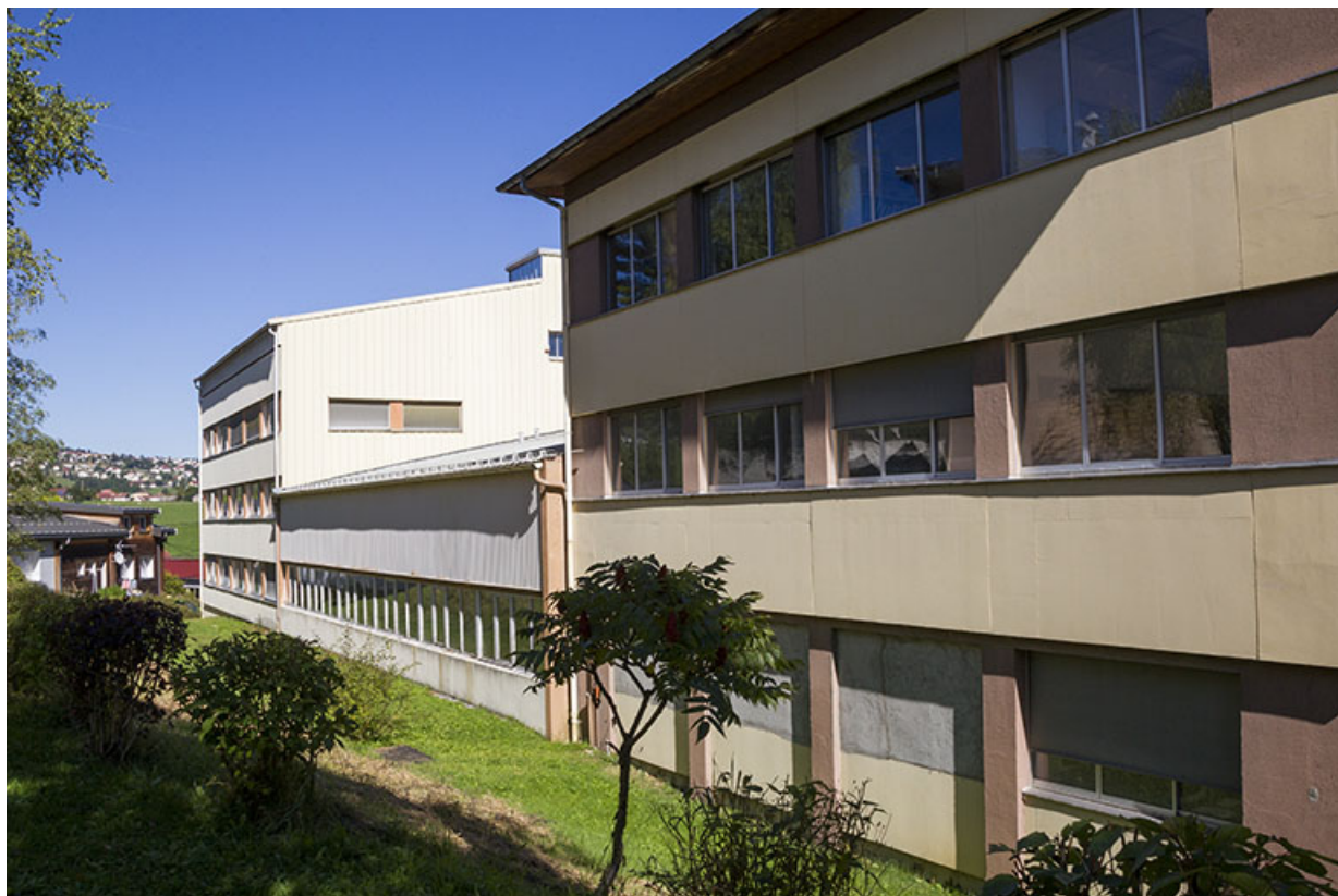
Corps sud et corps central : façade postérieure vue en enfilade.
