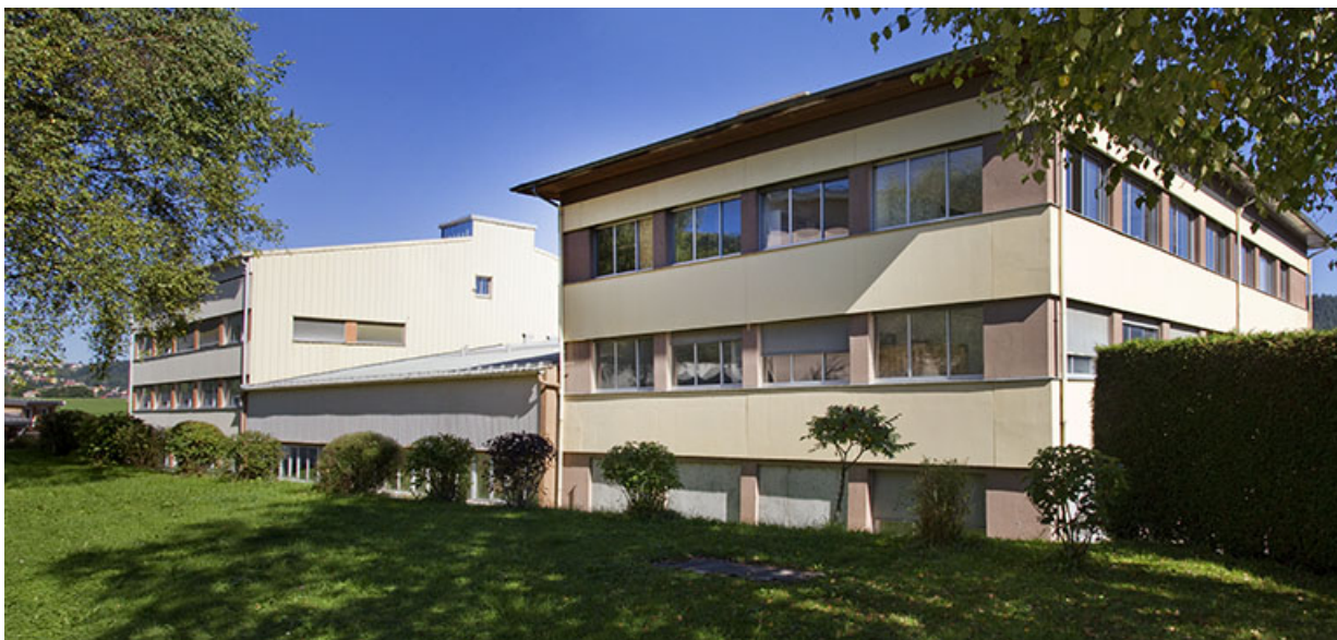
Vue d'ensemble, depuis le sud-ouest (façade postérieure).
