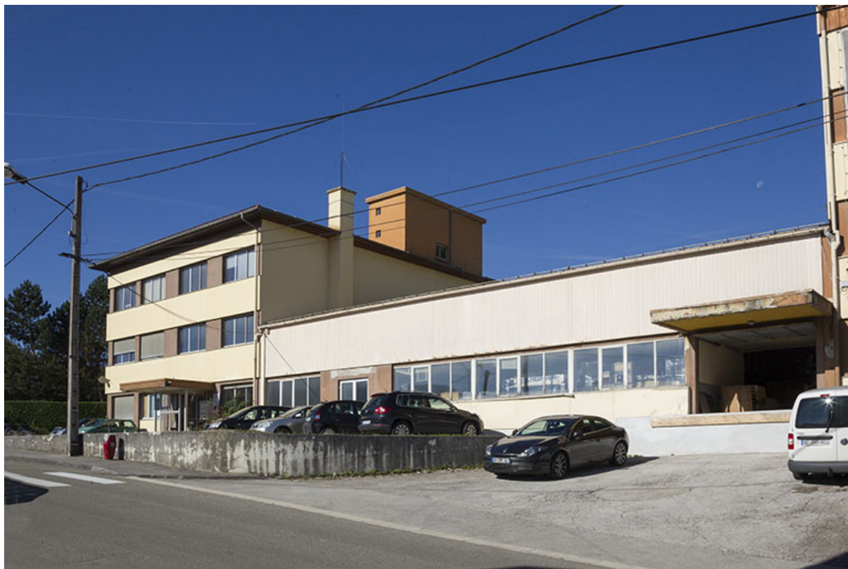
Corps sud et corps central : façade antérieure, de trois quarts droite.
