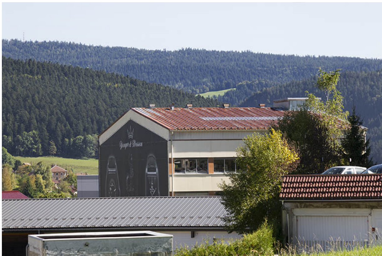
Corps nord : façades postérieure et latérale droite.
