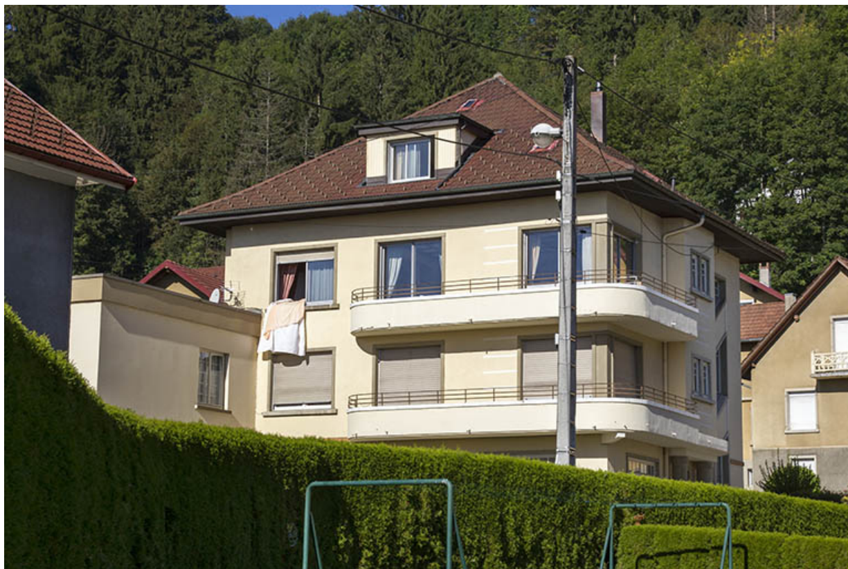
Façades postérieure et latérale gauche.
