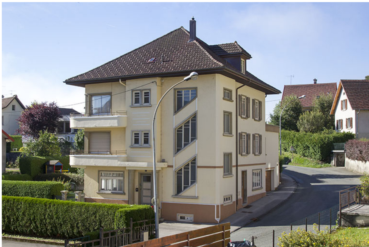
Vue d'ensemble, depuis le nord (façades antérieure et latérale gauche). 25, Morteau, 41 rue Neuve
