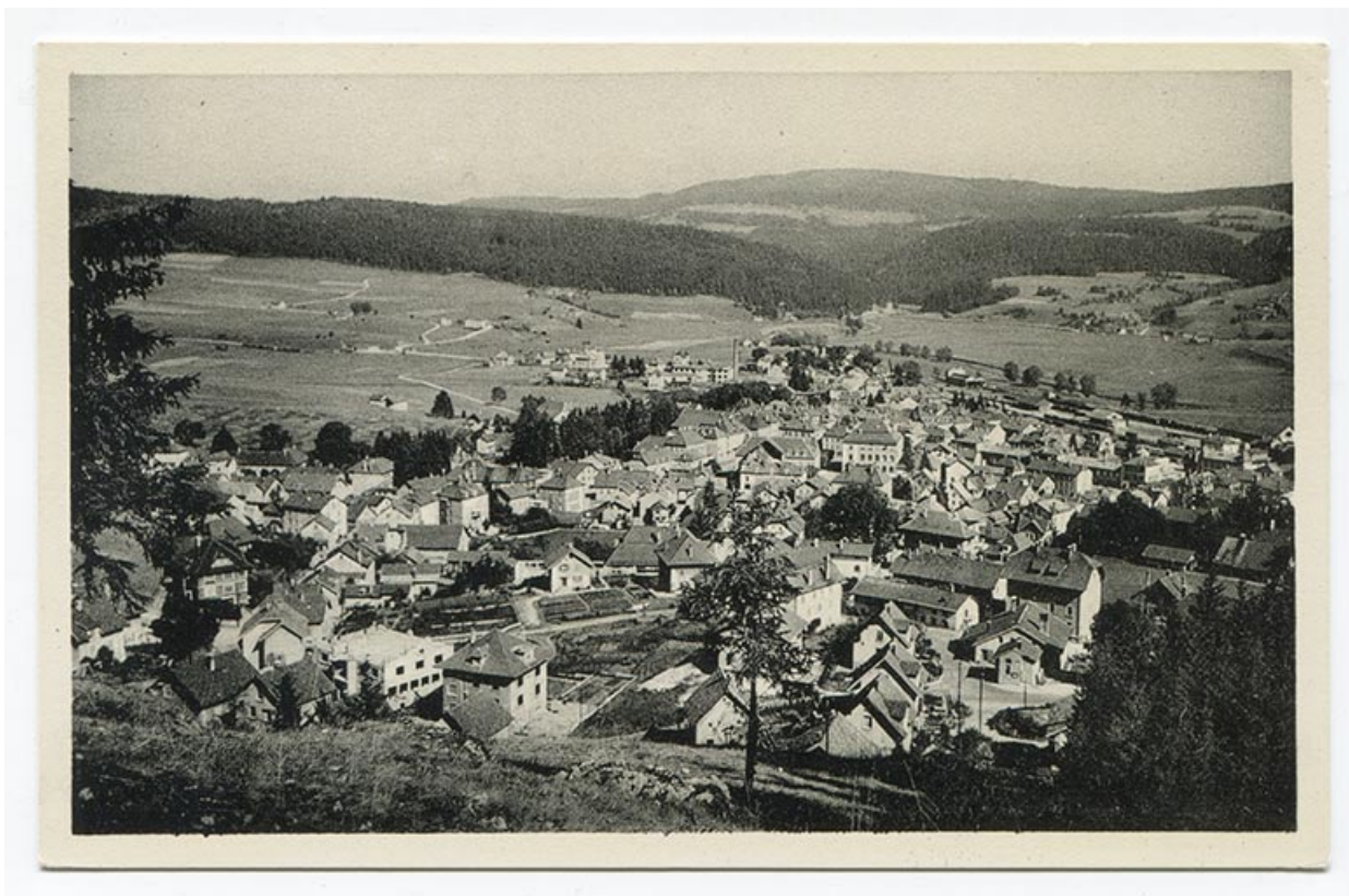
58 Morteau - Vue générale [sur le quartier de la rue Neuve], 1950-1951. La maison est en construction. 25, Morteau, 39 rue Neuve
