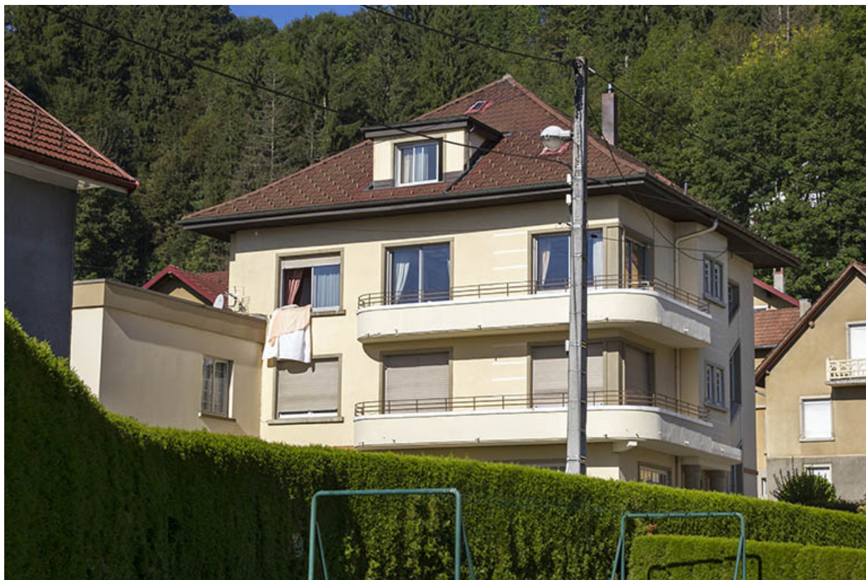
Façades postérieure et latérale gauche.
