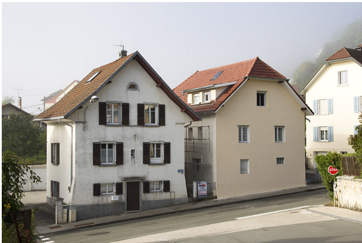
Vue d'ensemble, depuis le nord-est (la maison de gauche est au n° 33 de la rue Neuve). 25, Morteau, 35 rue Neuve
