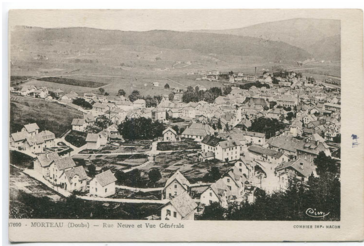
87699 - Morteau (Doubs) - Rue neuve et vue générale, 2e quart 20e siècle [après 1932]. 25, Morteau
