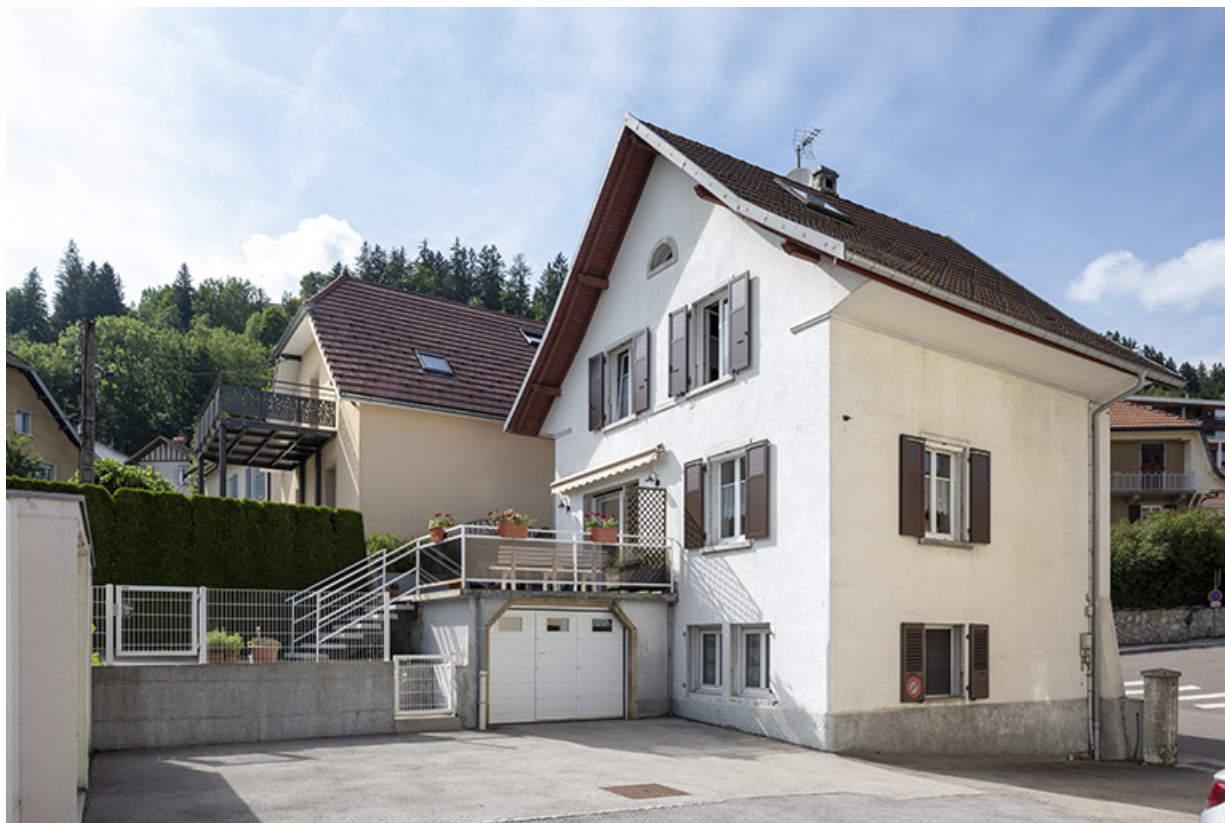
Façades postérieure et latérale gauche.
