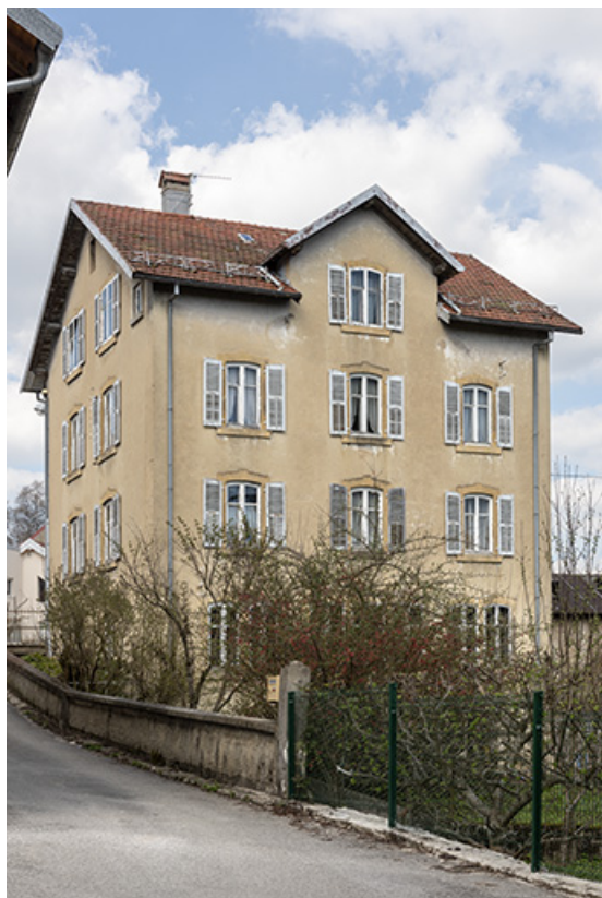
Façade postérieure, de trois quarts gauche. 25, Morteau, 13 rue Neuve
