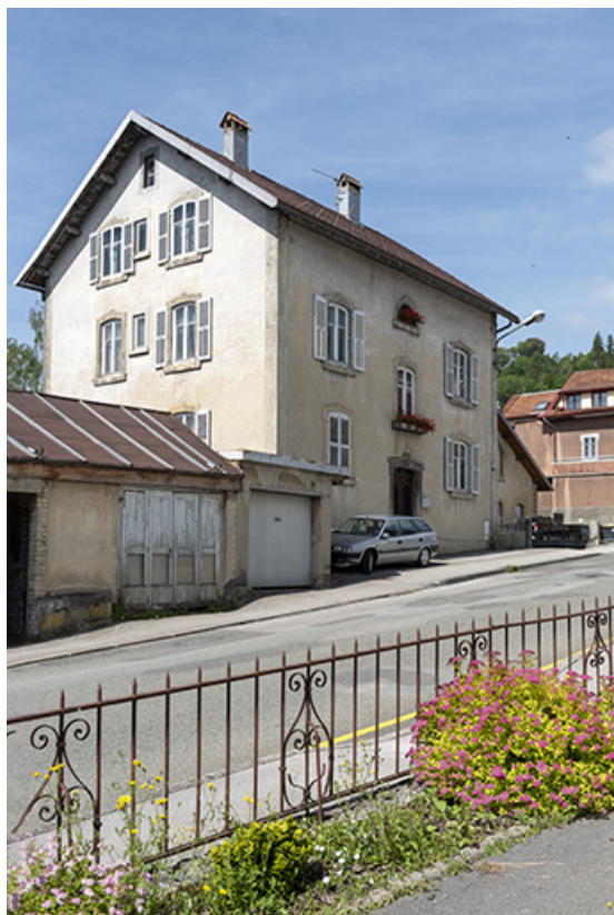
Façades latérale gauche et antérieure.
