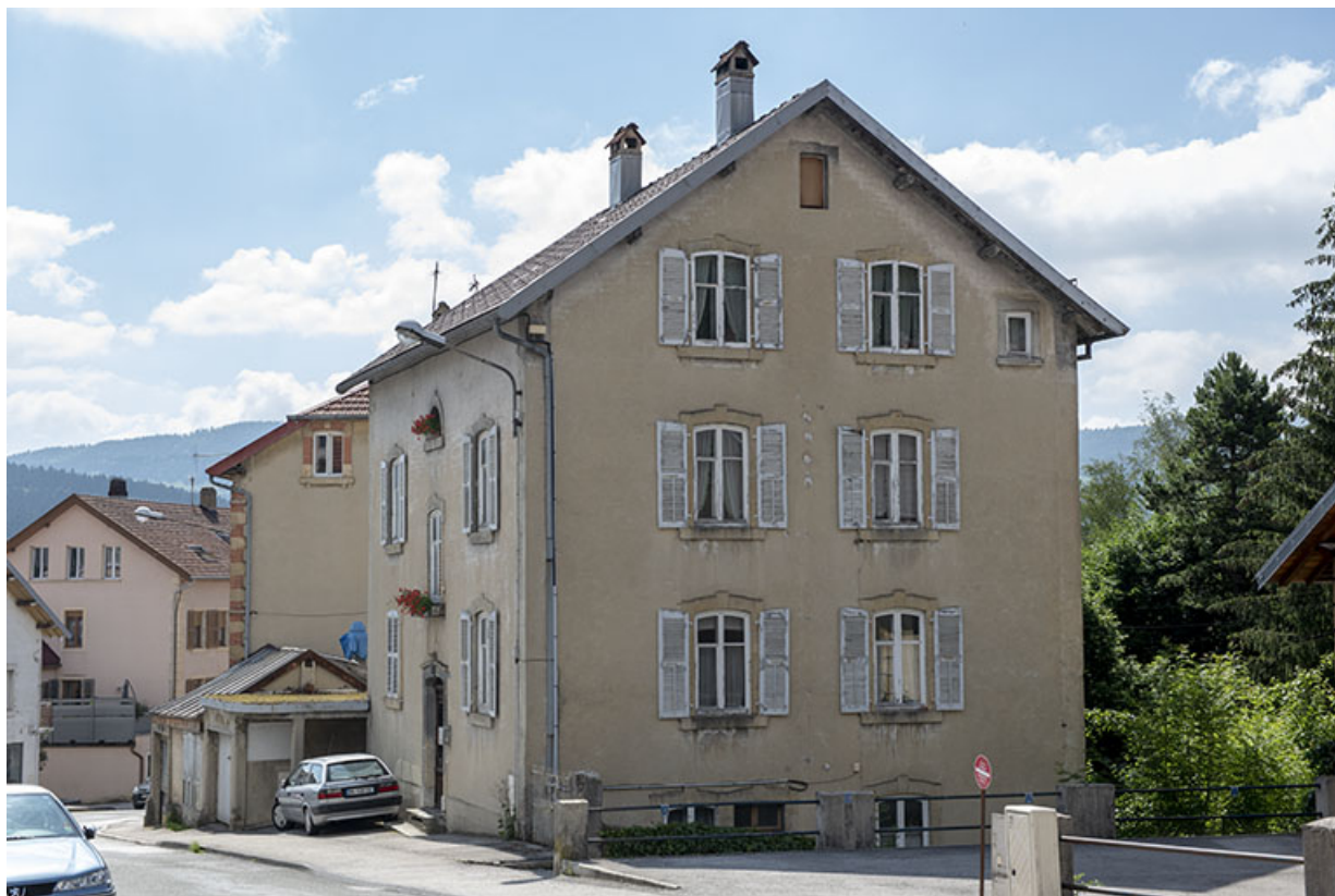
Façades latérale droite et antérieure.
