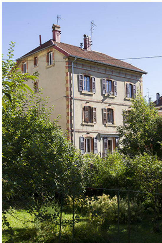
Façade postérieure, de trois quarts gauche. 25, Morteau, 9 rue Neuve
