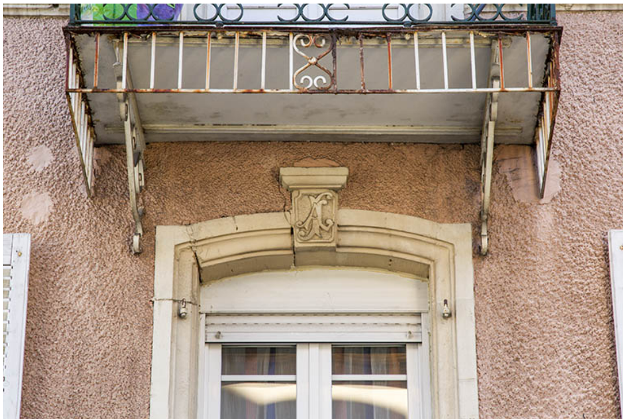
Façade antérieure : initiales AJ sur une clé. 25, Morteau, 7 rue Neuve
