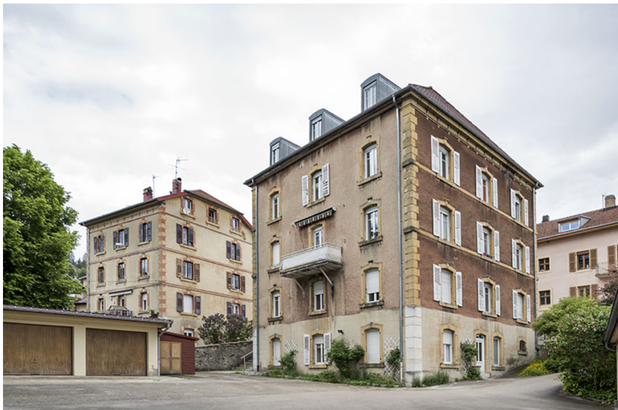
Façades postérieure et latérale gauche.
