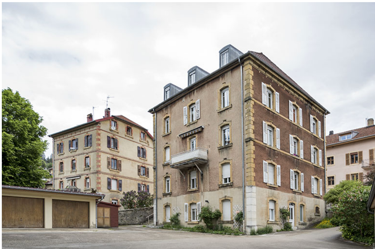
Façades postérieure et latérale gauche.
