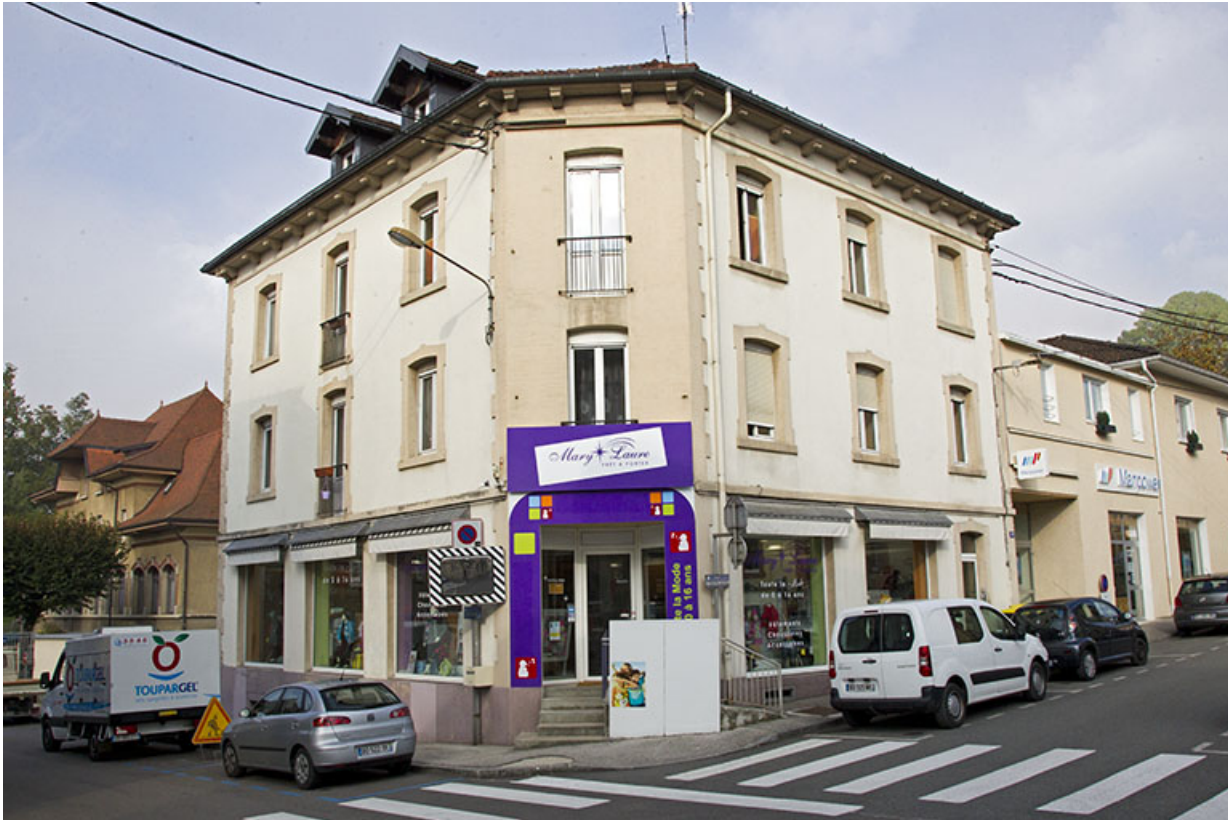
Bâtiment à l'angle des rues Pasteur et Pertusier, en 2013 : façades antérieure et latérale droite. 25, Morteau, 20 rue Pasteur
