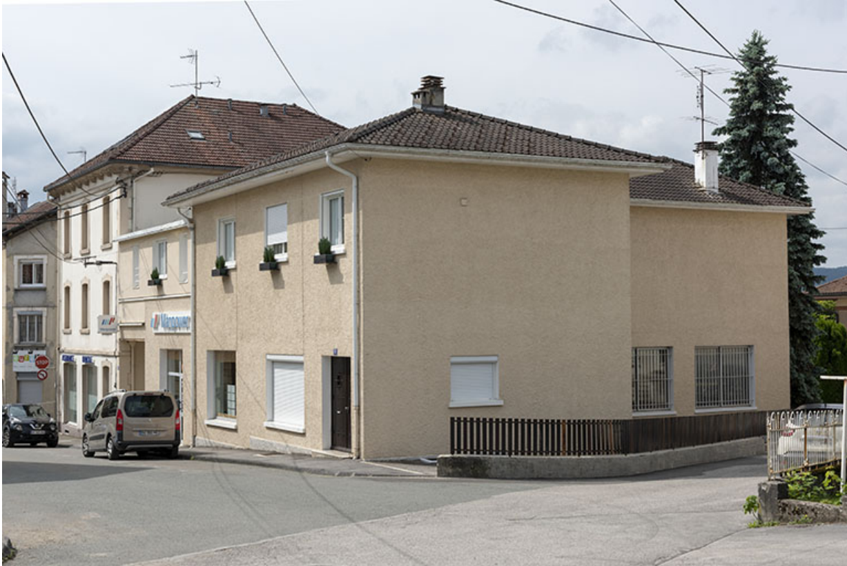
Vue d'ensemble depuis le nord (sur la rue Pertusier).
