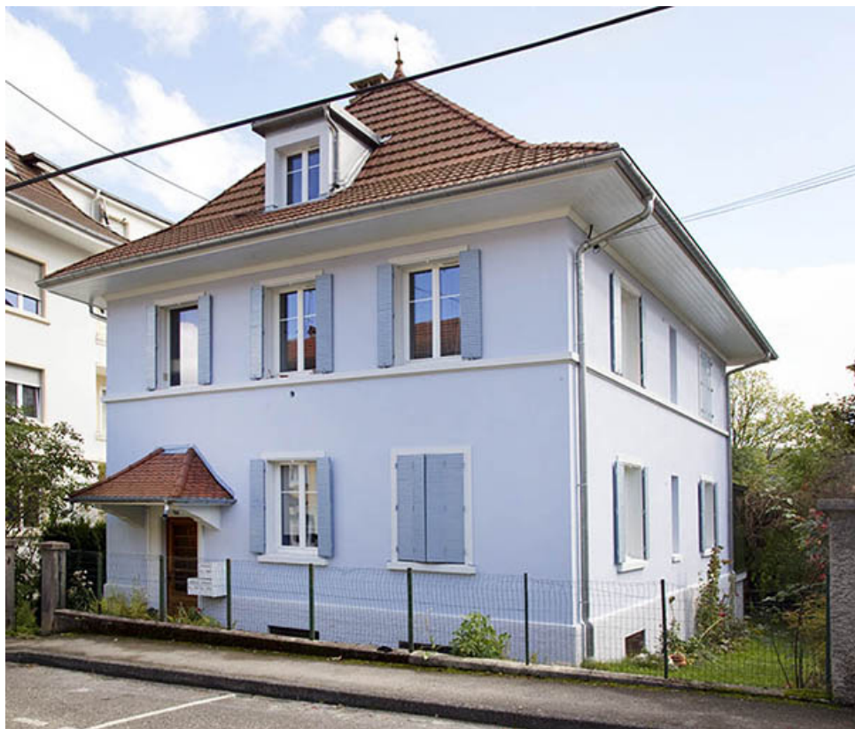
Façades antérieure et latérale droite.
