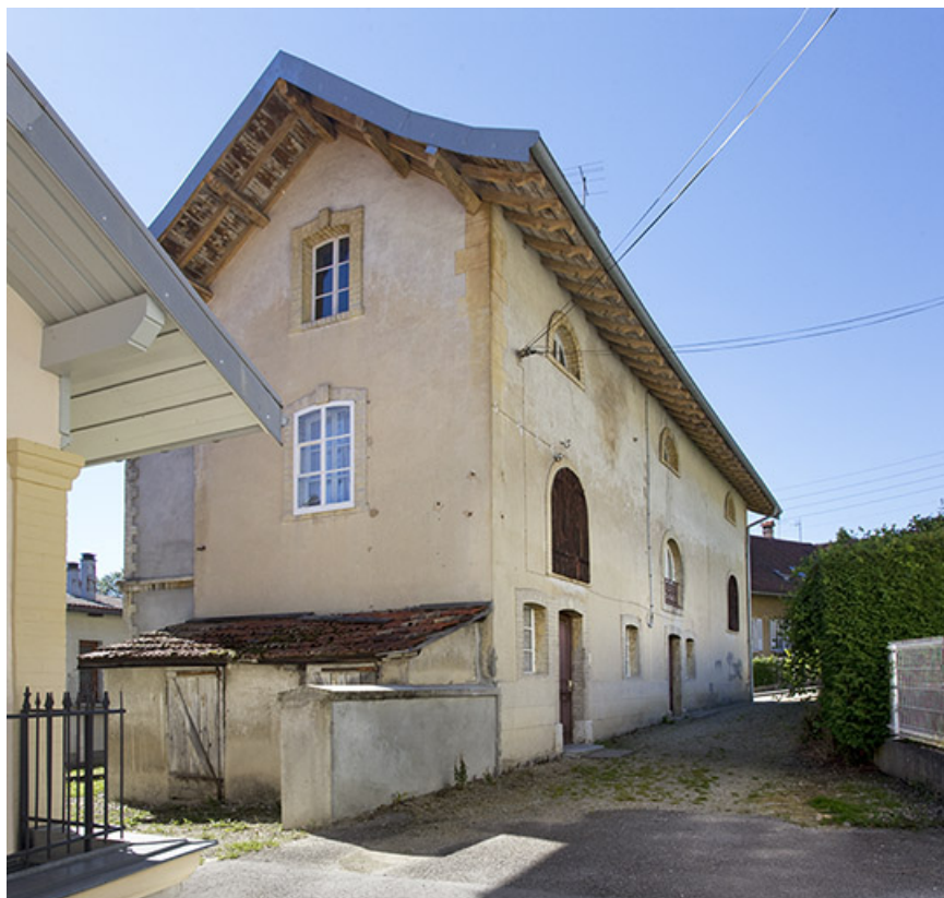
Façades postérieure et latérale droite.
