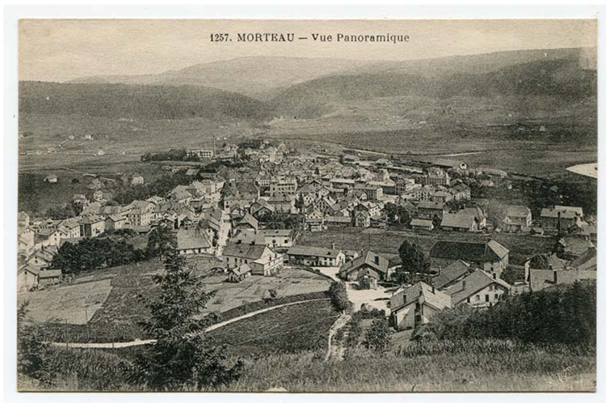
1257. Morteau - Vue panoramique, 1er quart 20e siècle. Le bâtiment a été rehaussé et allongé. 25, Morteau, 16 rue Charles Brügger
