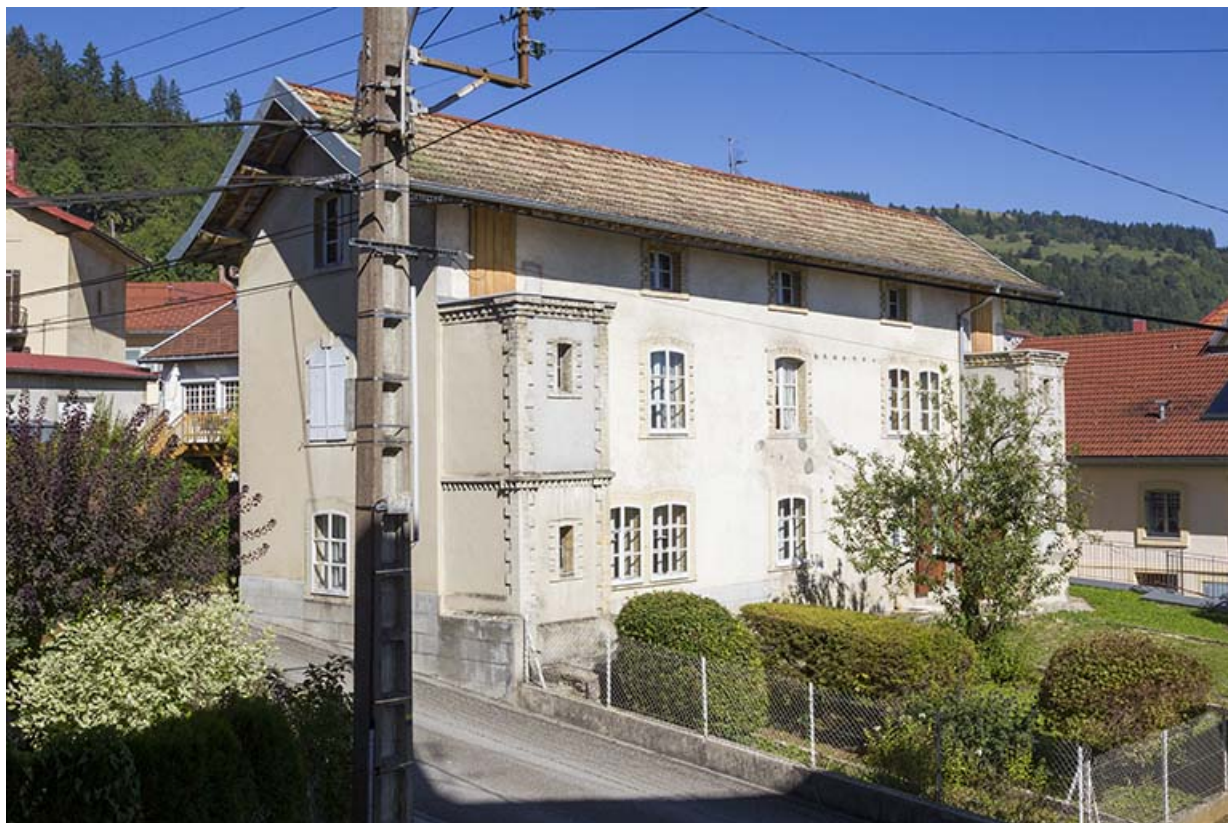
Façades antérieure et latérale gauche.
