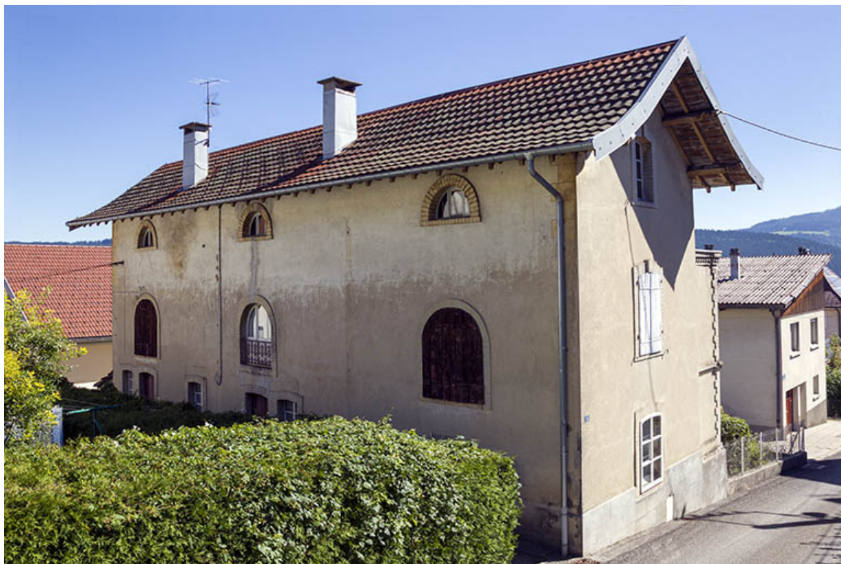
Façades postérieure et latérale gauche.
