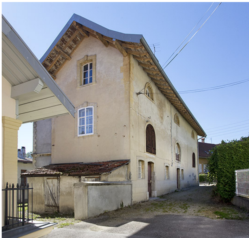
Façades postérieure et latérale droite.
