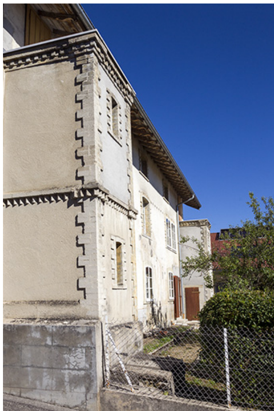
Façade antérieure, vue en enfilade.
