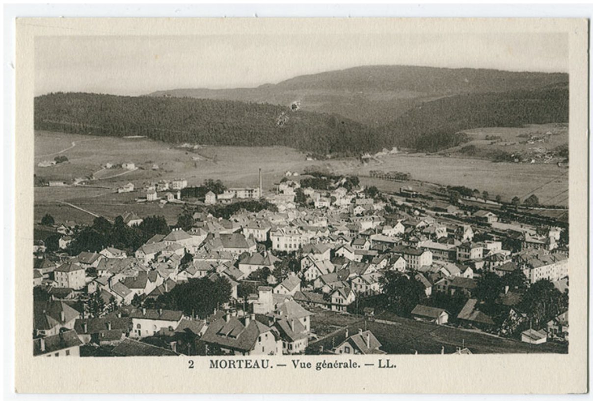
2 Morteau. - Vue générale [depuis le nord], 2e quart 20e siècle. Le bâtiment est visible en bas à gauche. 25, Morteau, 16 rue Charles Brügger
