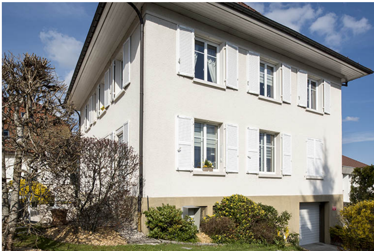
Maison-usine : élévation sud-ouest.
