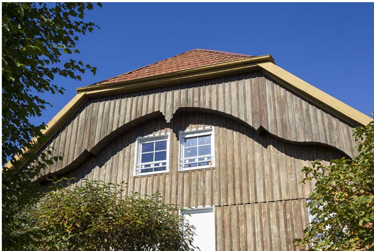
Ferme, façade latérale gauche : lambrichure et rang-pendu. 25, Morteau, 8 rue Charles Brügger
