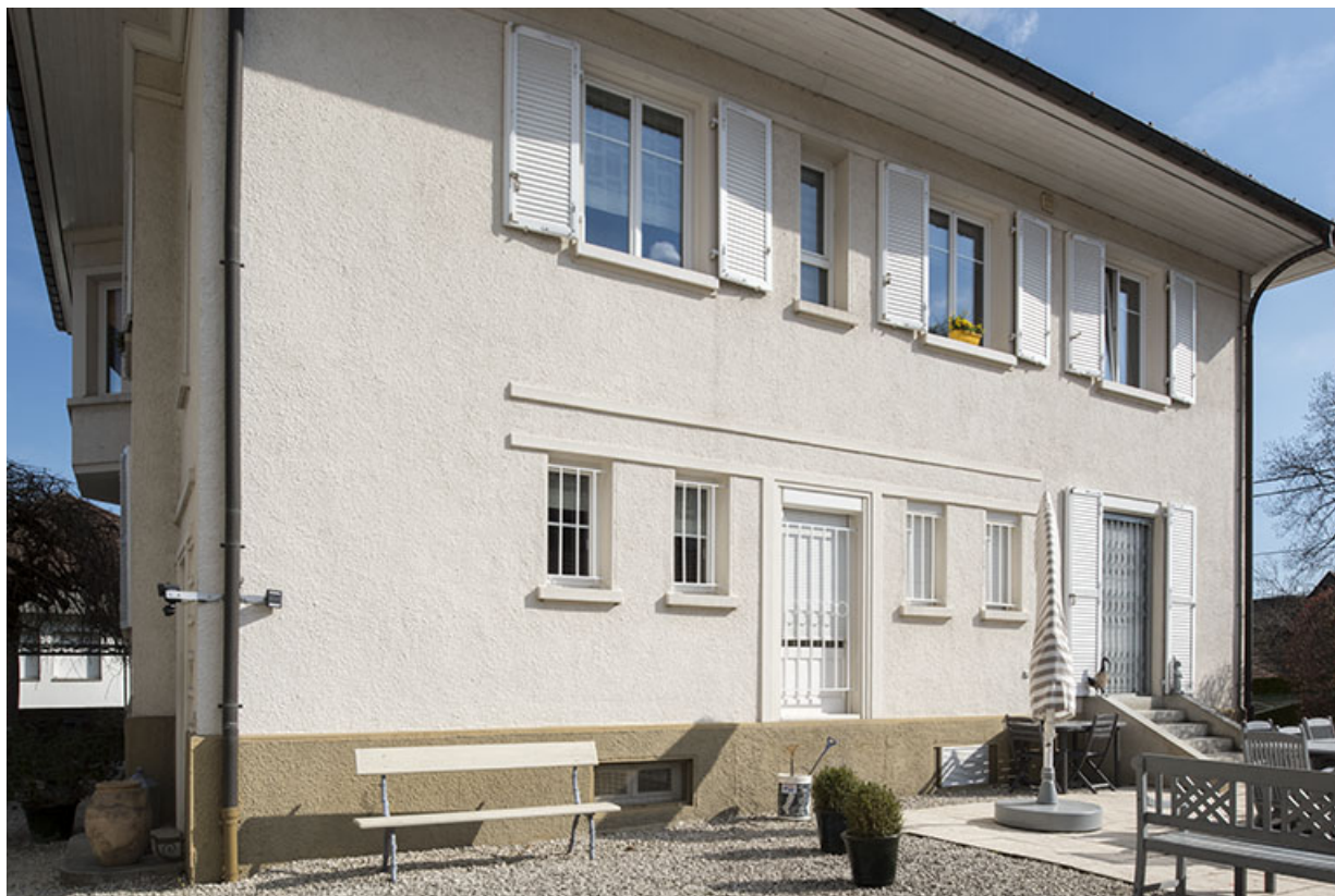
Maison-usine : élévation nord-ouest.
