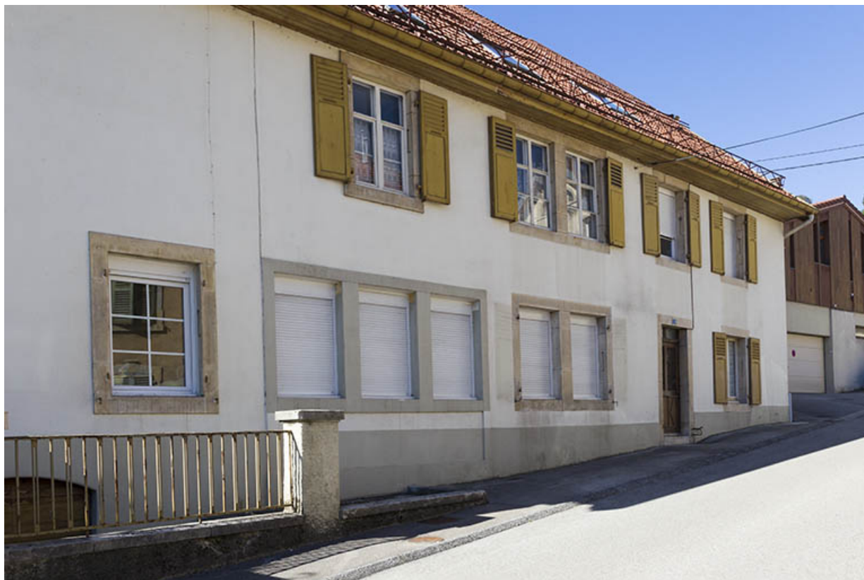
Ferme : façade antérieure, de trois quarts gauche.
