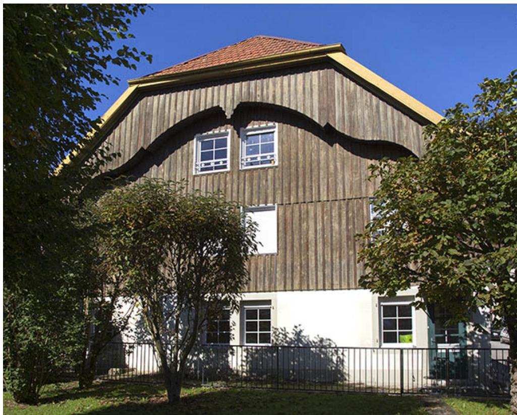
Ferme : façade latérale gauche. 25, Morteau, 8 rue Charles Brügger
