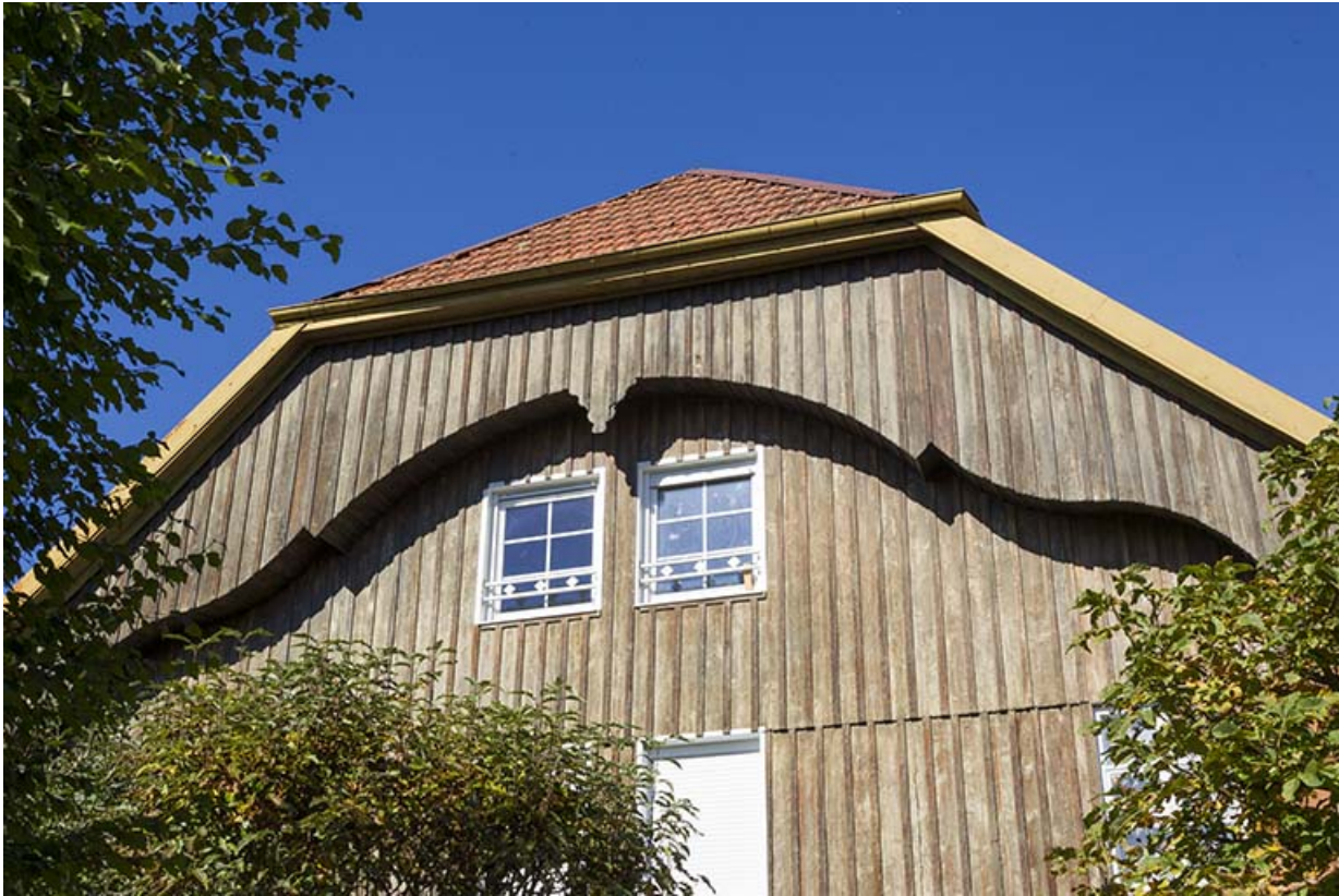
Ferme, façade latérale gauche : lambrichure et rang-pendu.
