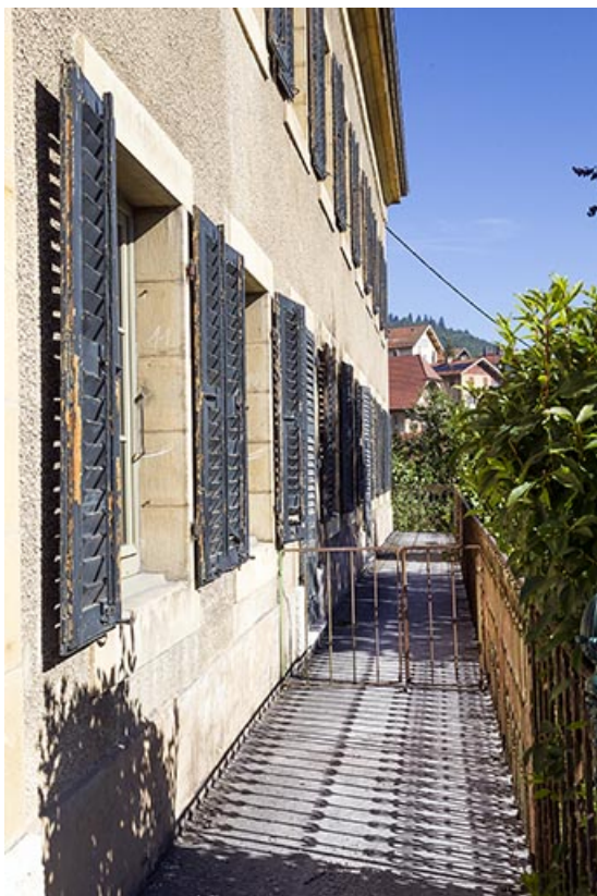
Maison : façade latérale droite, vue en enfilade. 25, Morteau, 22-24 rue Fauche
