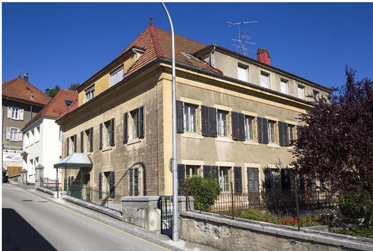
Vue d'ensemble, depuis l'est. 25, Morteau, 22-24 rue Fauche
