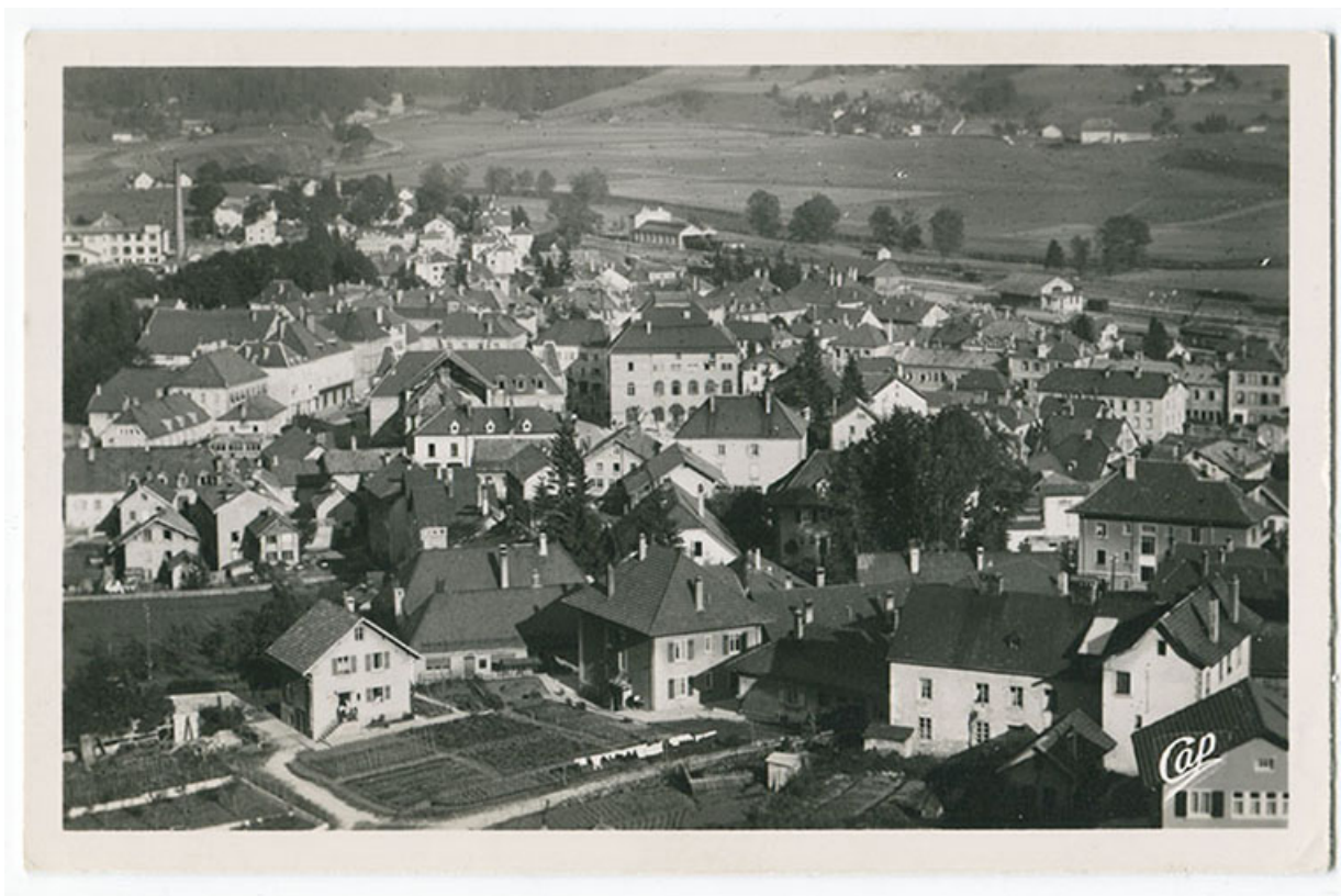
6 Morteau - Vue générale [depuis le nord], 3e quart 20e siècle [entre 1949 et 1953].
