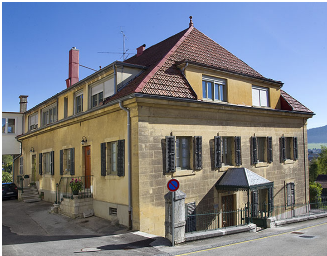
Maison : façades antérieure et latérale gauche.
