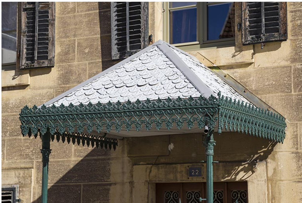
Maison : couverture de l'auvent sur la façade antérieure.
