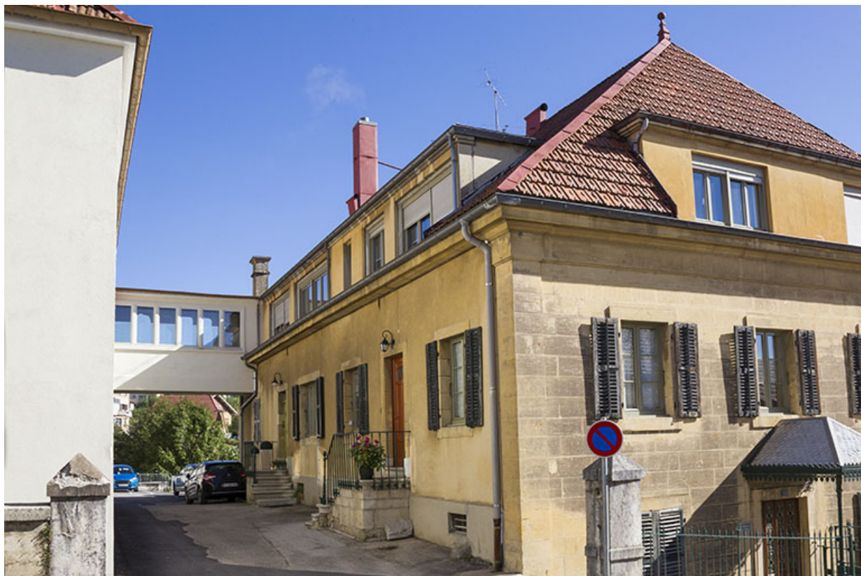
Maison : façade latérale gauche et passerelle. 25, Morteau, 22-24 rue Fauche
