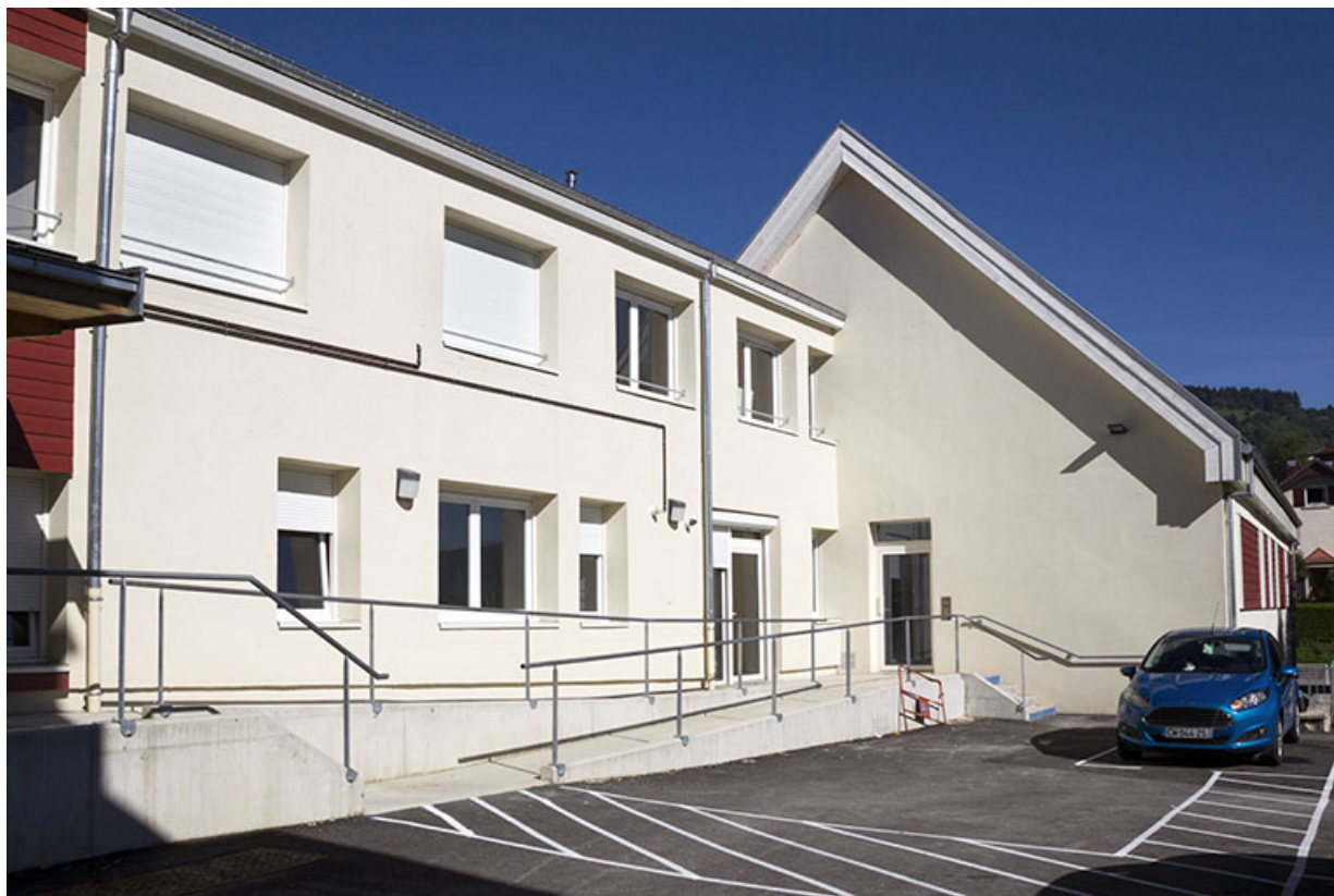
Usine : deuxième et troisième corps de bâtiment. 25, Morteau, 22-24 rue Fauche
