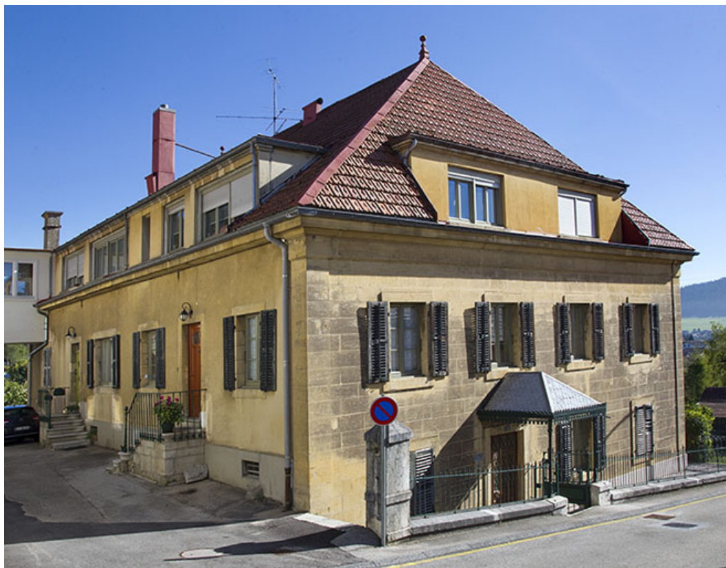
Maison : façades antérieure et latérale gauche.
