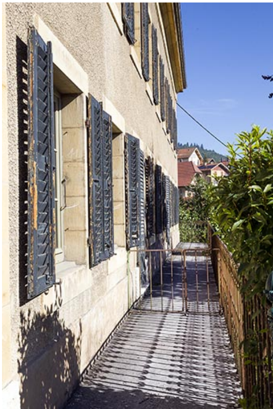
Maison : façade latérale droite, vue en enfilade.
