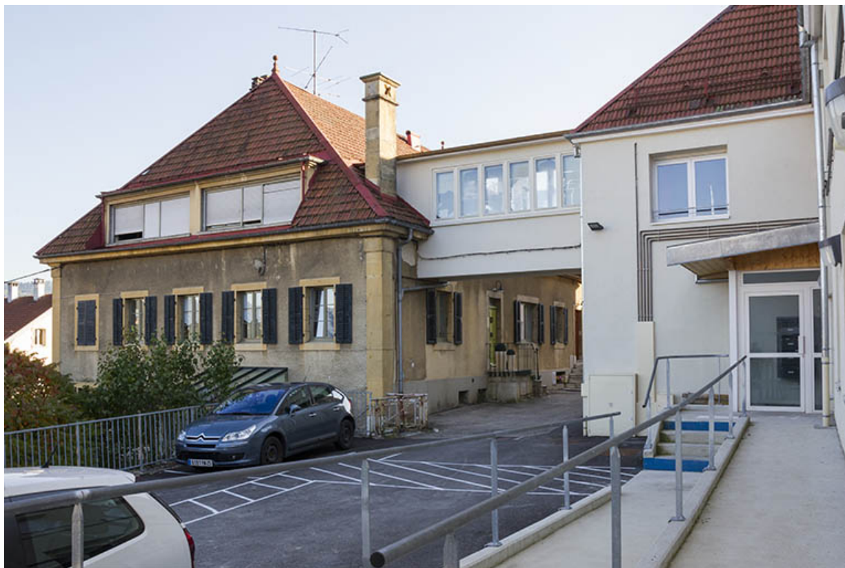
Usine : façade postérieure du premier corps de bâtiment, avec la passerelle d'accès à la maison. 25, Morteau, 22-24 rue Fauche
