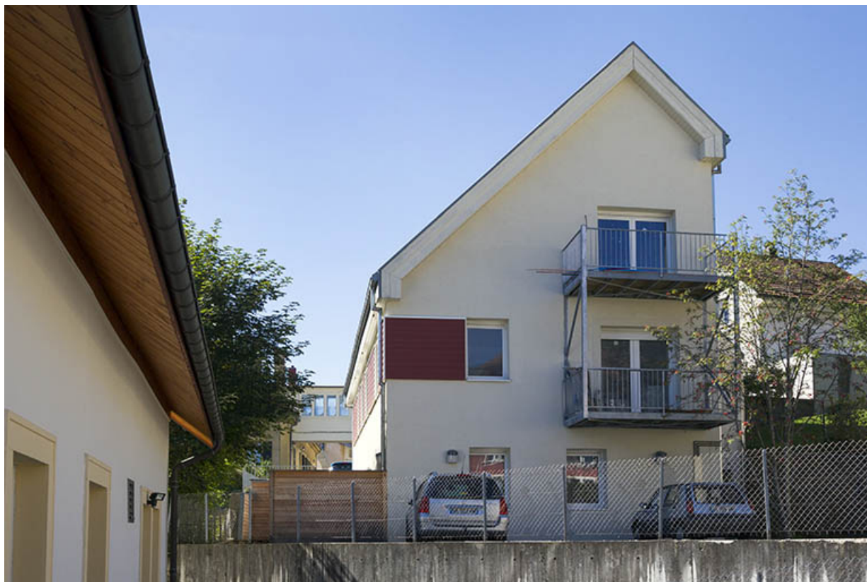
Façade nord du troisième corps de bâtiment. 25, Morteau, 22-24 rue Fauche
