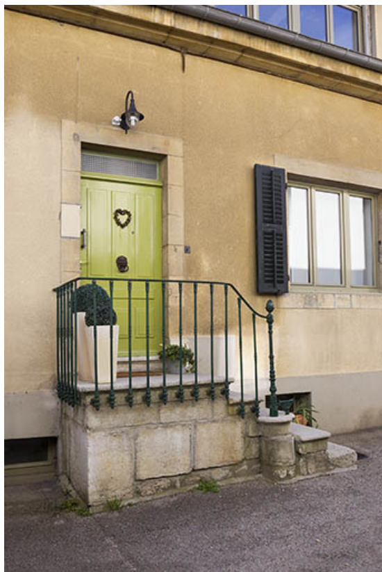
Maison : escalier extérieur sur la façade latérale gauche.
