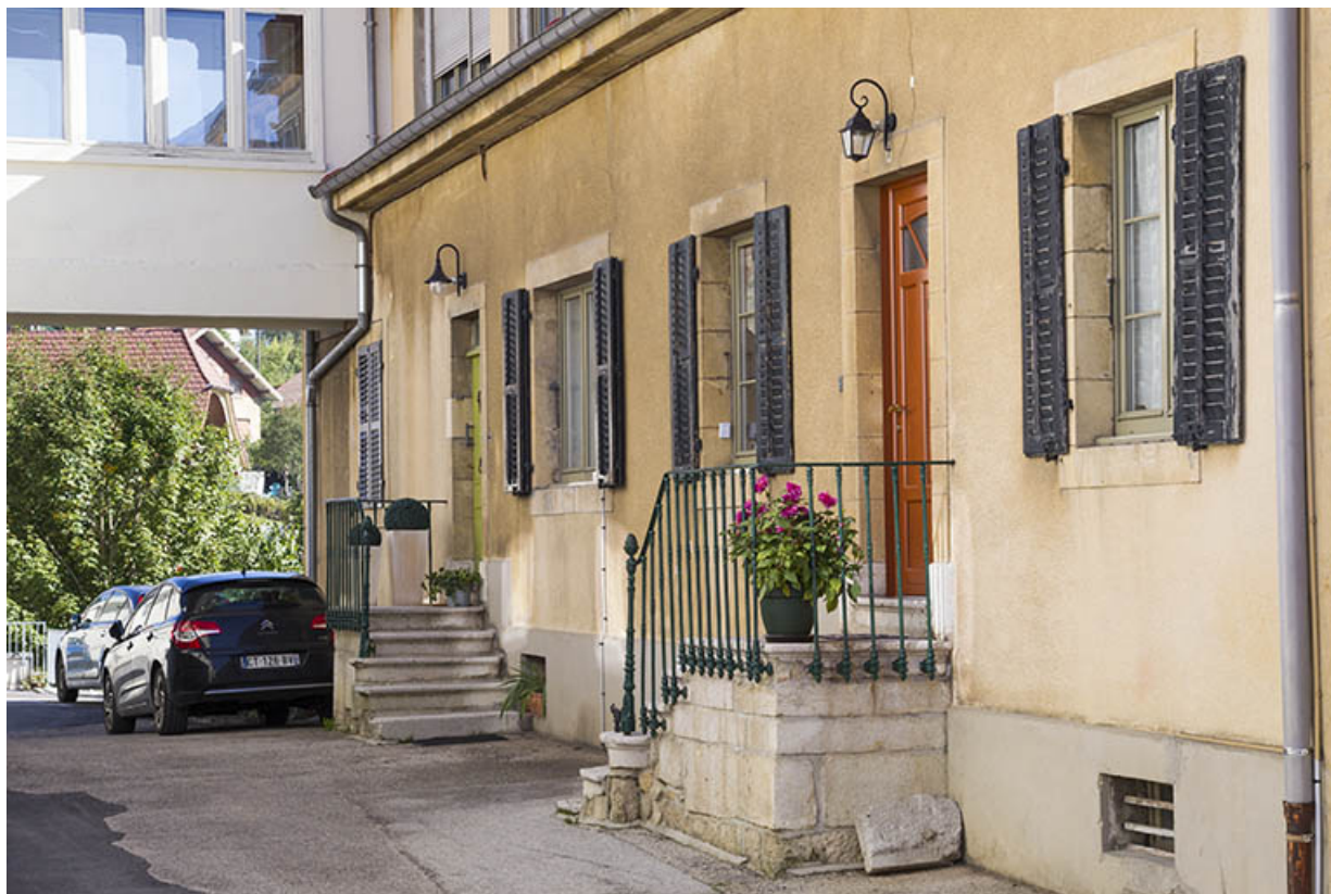
Maison : façade latérale gauche, vue en enfilade. 25, Morteau, 22-24 rue Fauche
