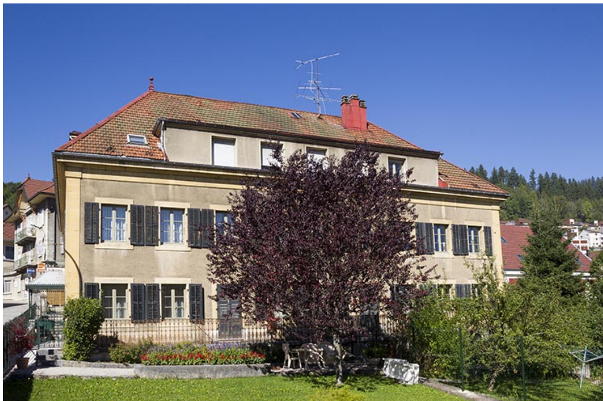
Maison : façade latérale droite.
