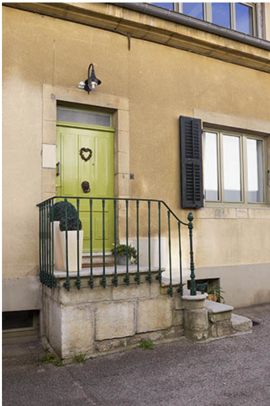
Maison : escalier extérieur sur la façade latérale gauche. 25, Morteau, 22-24 rue Fauche
