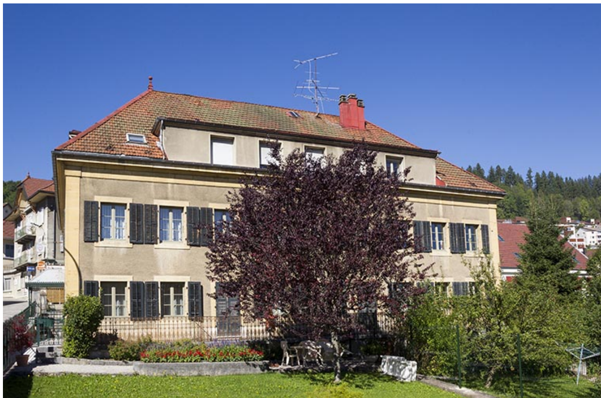
Maison : façade latérale droite.
