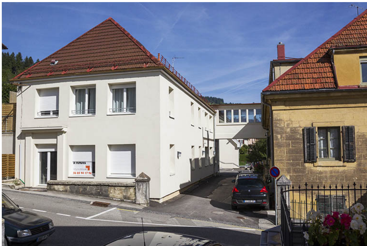
Usine : façades antérieure et latérale droite du premier corps de bâtiment, avec la passerelle. 25, Morteau
