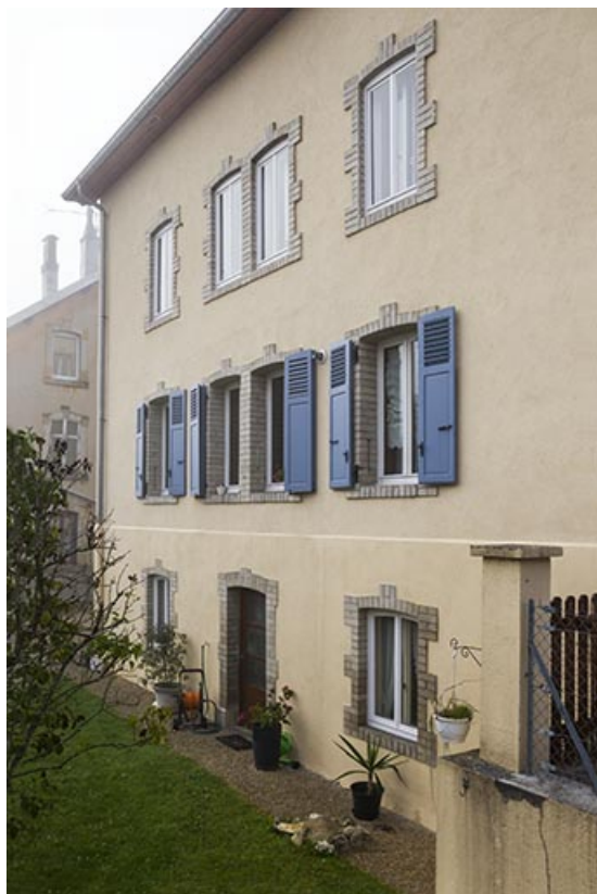
Façade postérieure, vue en enfilade.
