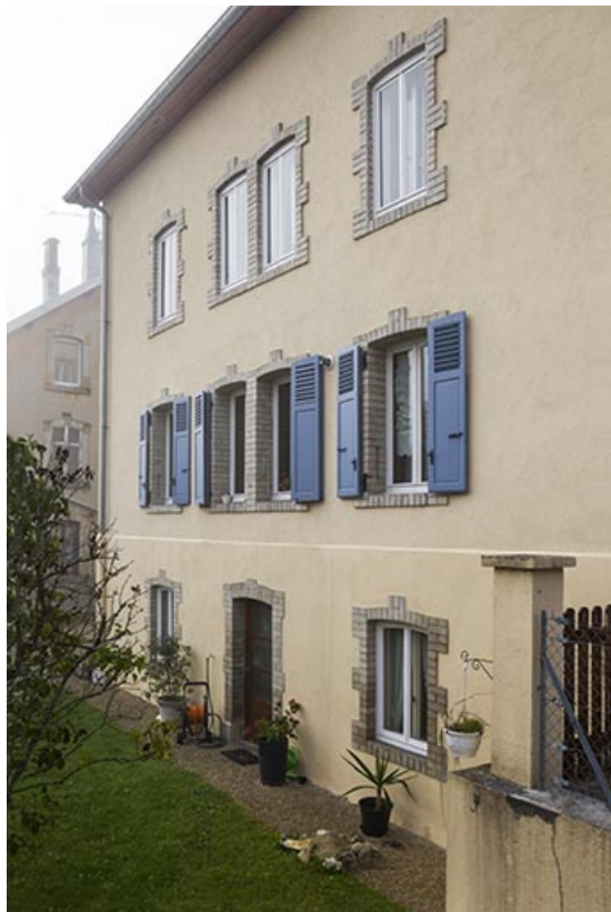
Façade postérieure, vue en enfilade.
