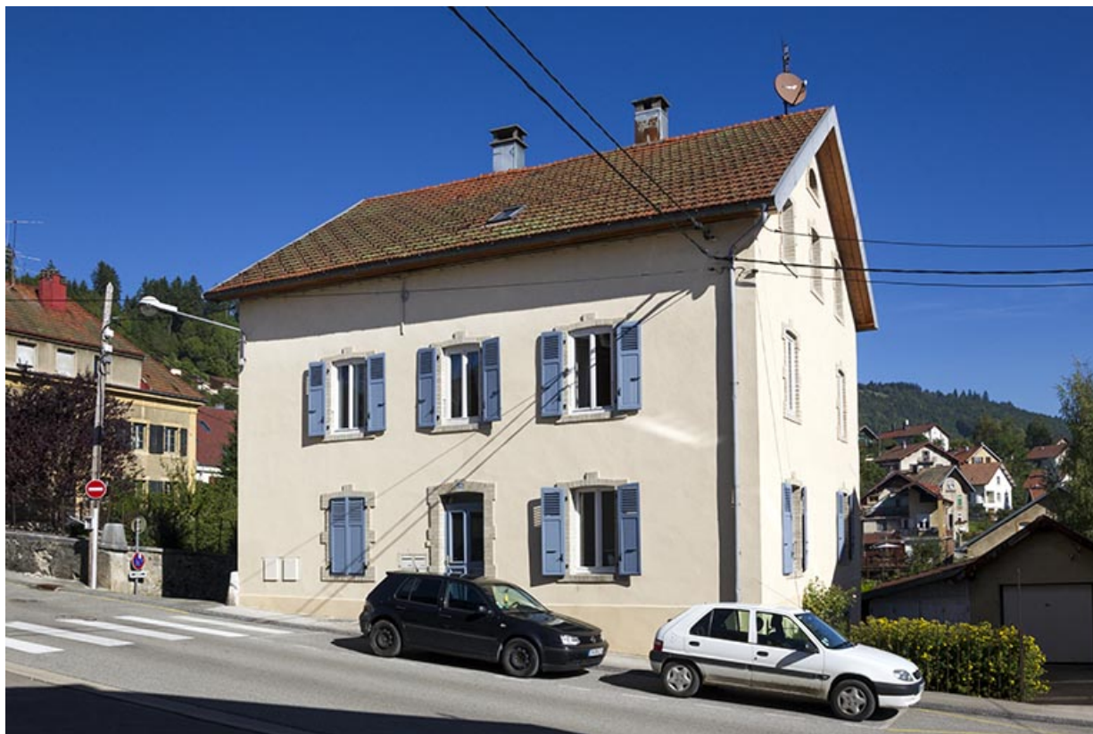
Façade antérieure, de trois quarts droite. 25, Morteau, 16 rue Fauche
