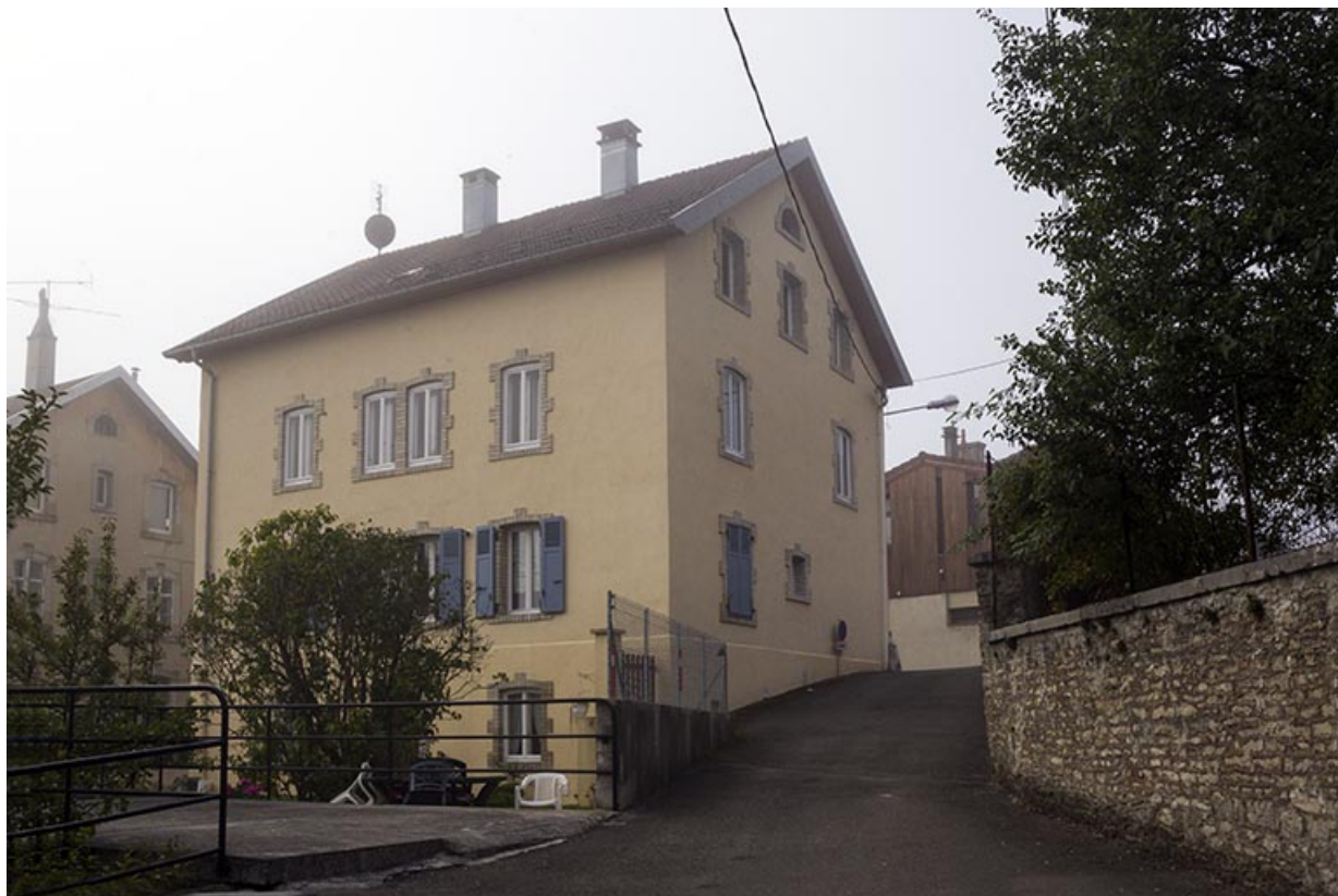
Façades postérieure et latérale gauche.
