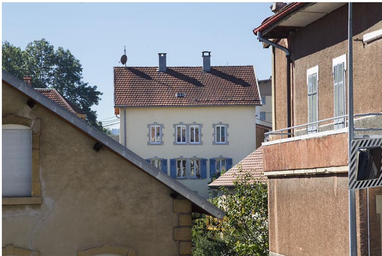
Façade postérieure (vue éloignée).
