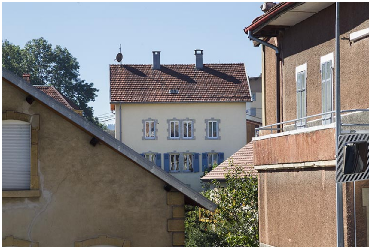
Façade postérieure (vue éloignée).
