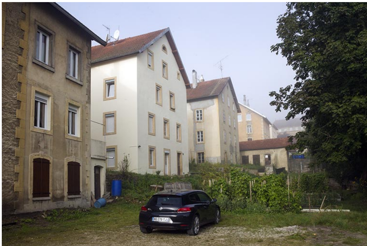
Vue d'ensemble, depuis le nord-est (façades postérieure et latérale droite). 25, Morteau, 12 rue Fauche
