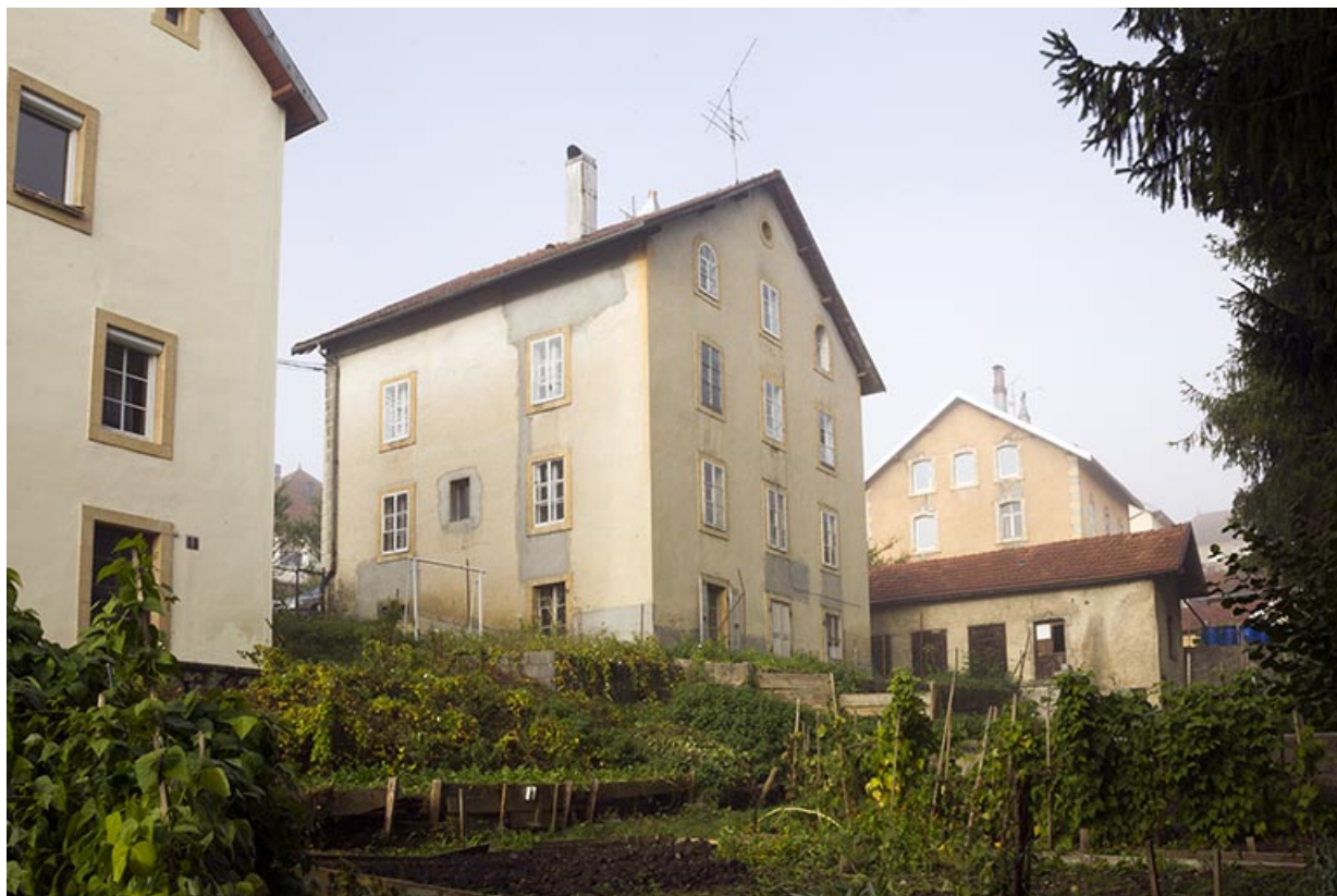
Façades postérieure et latérale droite.
