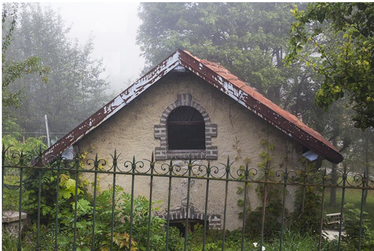
Bûcher : pignon sud.
