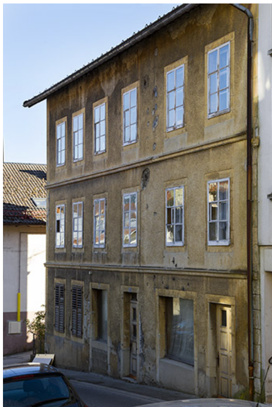
Maison : façade antérieure, de trois quarts droite. 25, Morteau, 5, 7 rue Fauche
