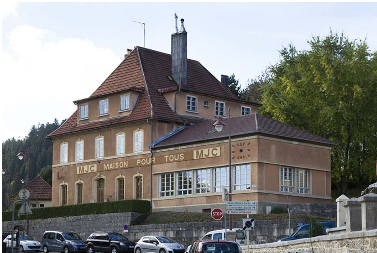
Presbytère puis bureau de la garantie puis école d'horlogerie, 2 place de l'Eglise. 25, Morteau
