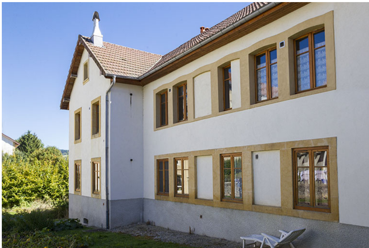
Ancien atelier : façade postérieure, vue de trois quarts droite.
