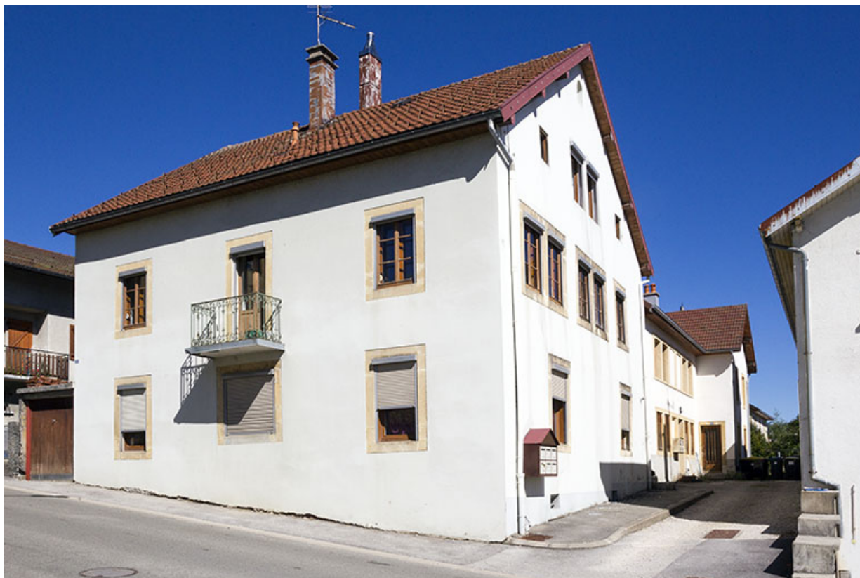
Maison, vue du sud-ouest. L'atelier se signale à l'étage par ses fenêtres horlogères.
