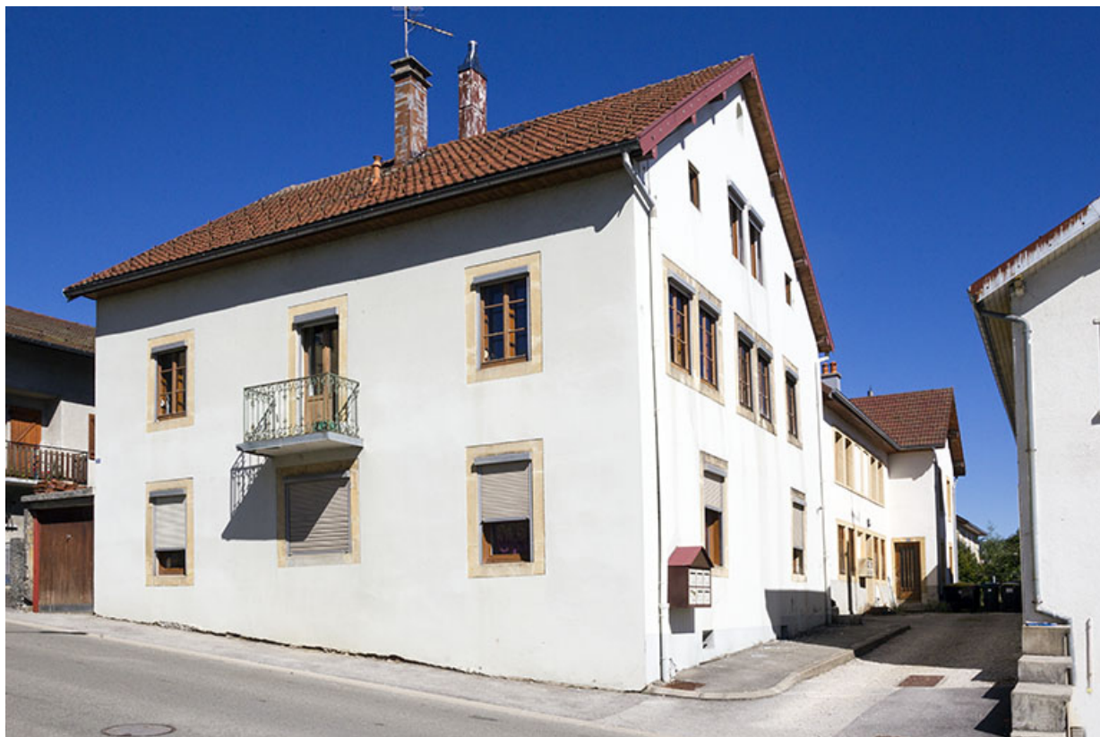
Maison, vue du sud-ouest. L'atelier se signale à l'étage par ses fenêtres horlogères.
