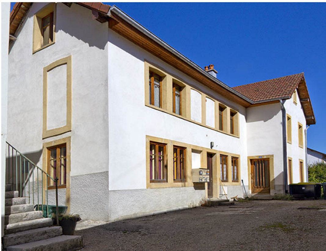
Ancien atelier : façade antérieure, vu de trois quarts gauche.
