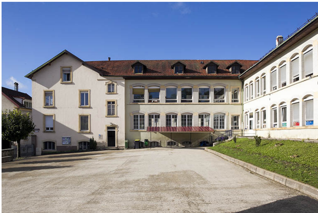
Aile ouest : façade orientale (sur cour). 25, Morteau, 30 rue de la Chaussée
