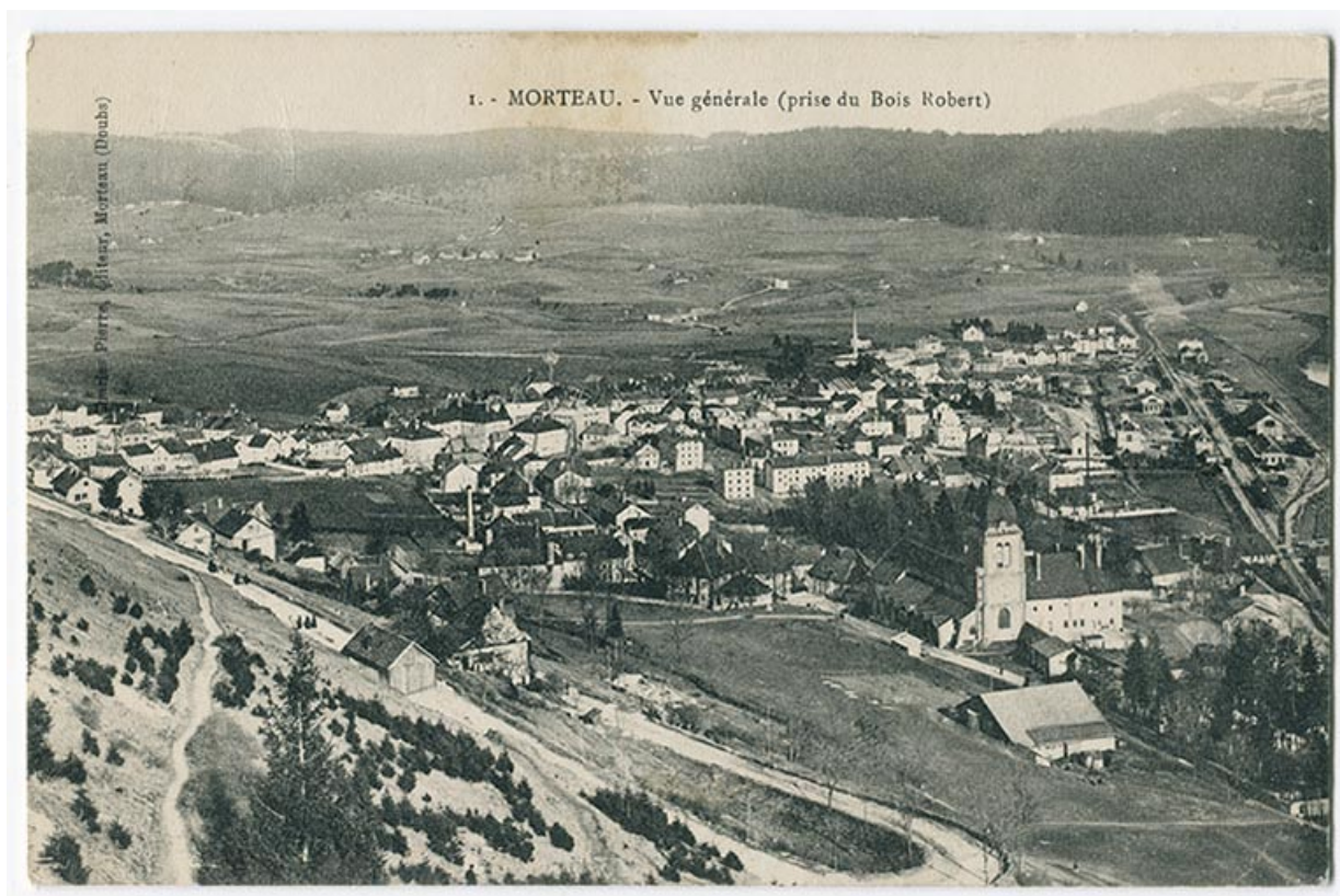
1. - Morteau. - Vue générale (prise du Bois Robert), 1er quart 20e siècle [avant 1911]. L'usine, au centre de l'image, se marque par sa cheminée.
