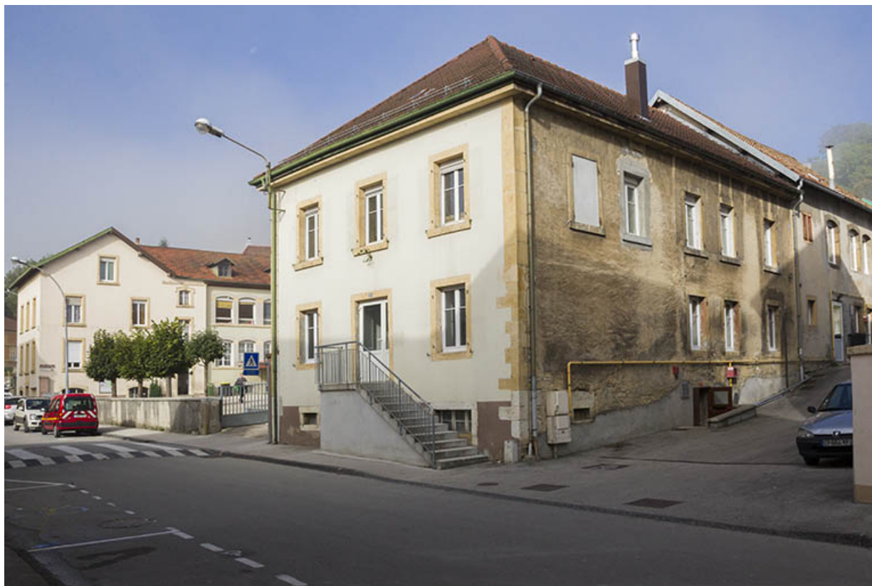
Vue d'ensemble depuis la rue, à l'est, avec au premier plan l'extrémité de l'aile orientale. 25, Morteau, 30 rue de la Chaussée
