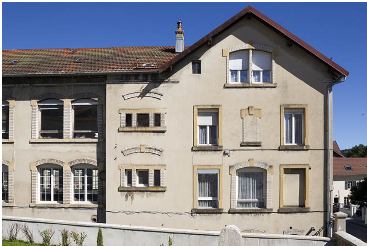
Aile ouest : façade occidentale du corps donnant sur la rue. 25, Morteau, 30 rue de la Chaussée
