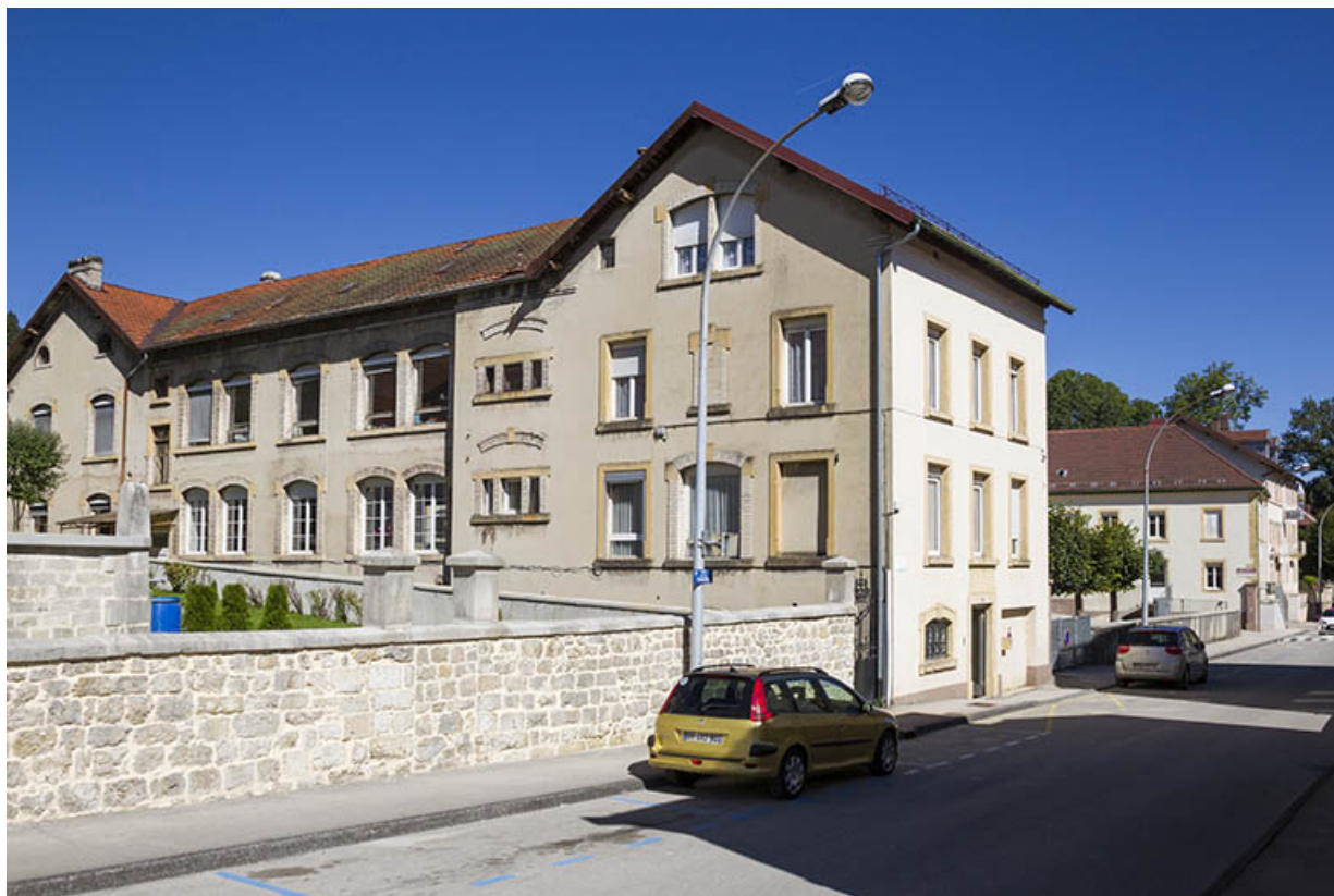
Aile ouest : façade occidentale, vue de trois quarts droite.
