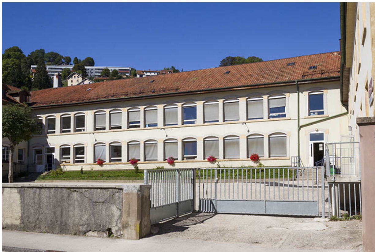
Aile nord : façade antérieure.
