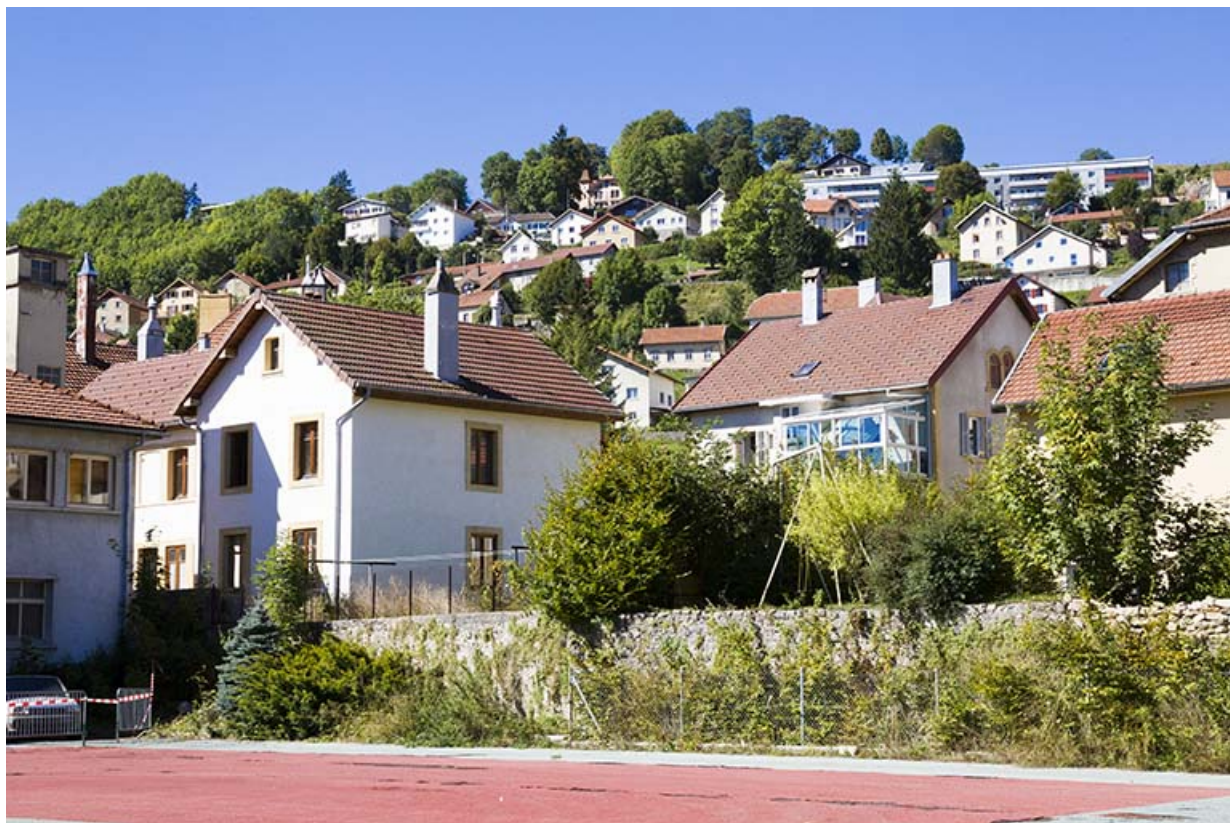
Façade postérieure. A gauche, ancien atelier du site de Camille Mauvais. 25, Morteau, 3, 5 rue de la Glapiney
