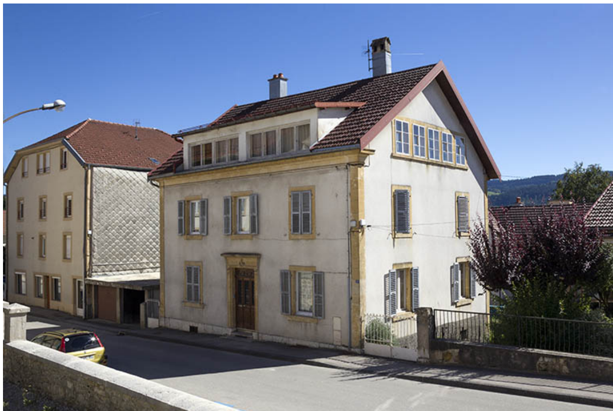
Façades antérieure et latérale droite. 25, Morteau
