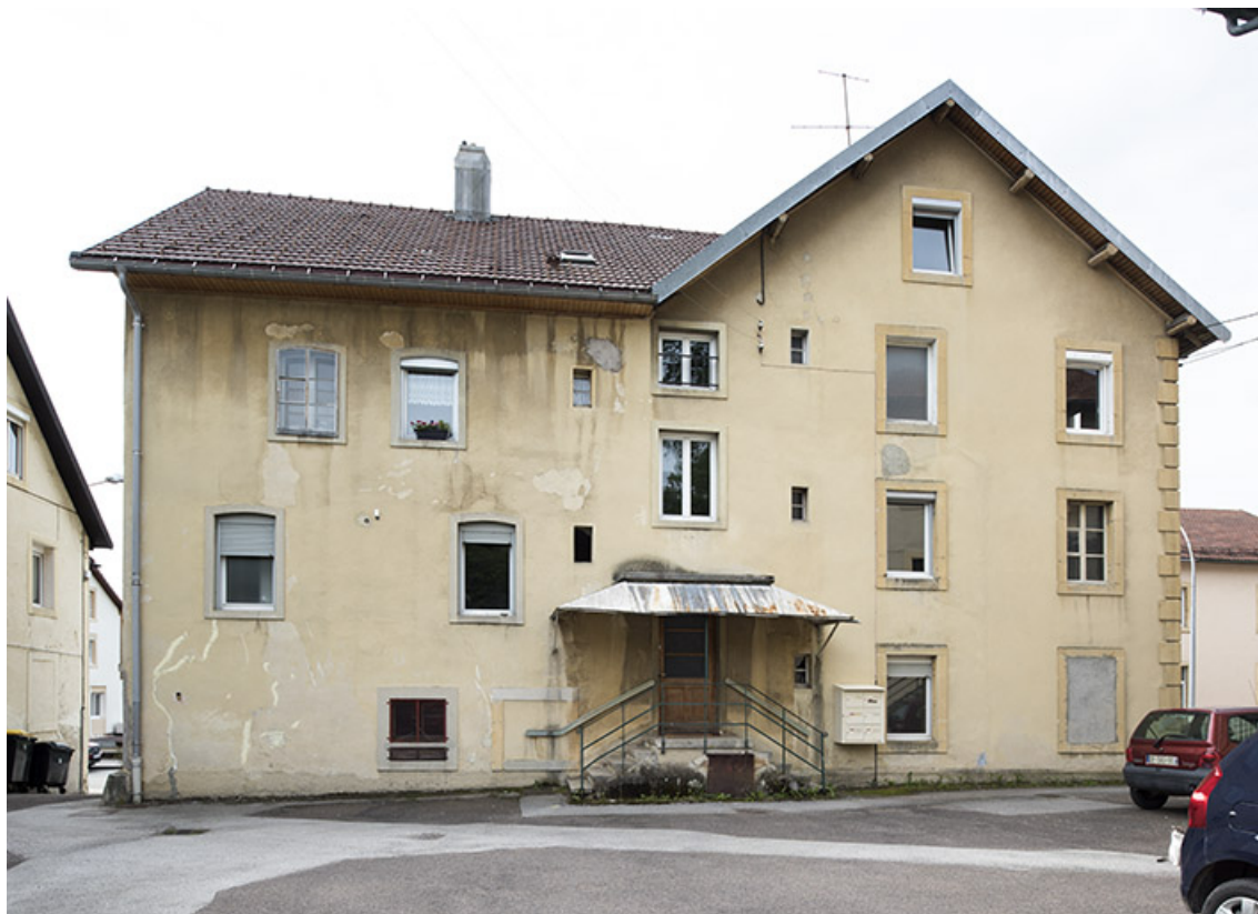
Bâtiment sur rue : façade postérieure.
