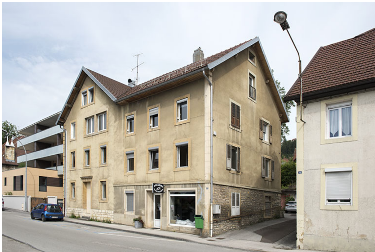
Bâtiment sur rue : façades antérieure et latérale droite.
