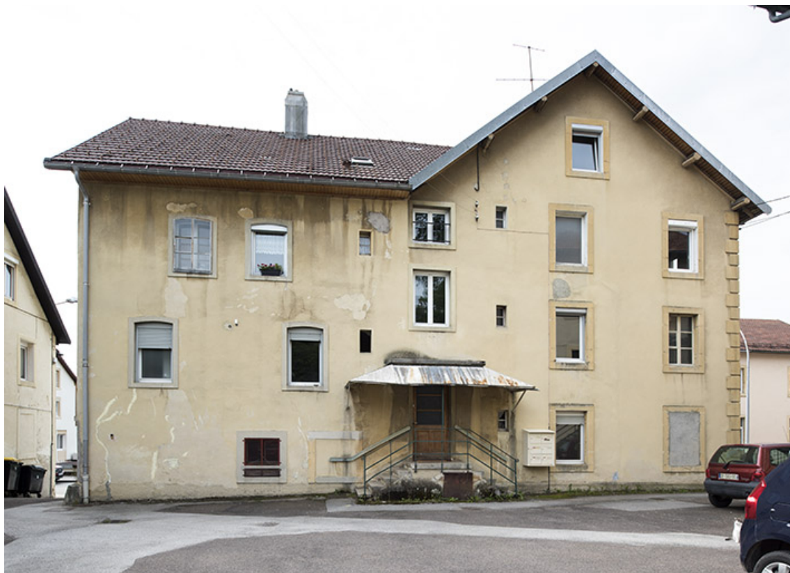
Bâtiment sur rue : façade postérieure.
