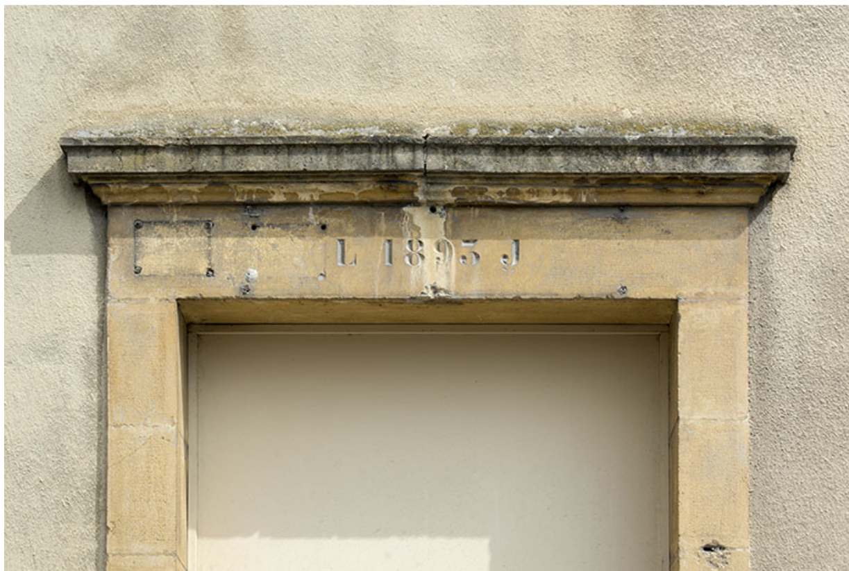
Bâtiment sur rue : linteau daté 1893.
