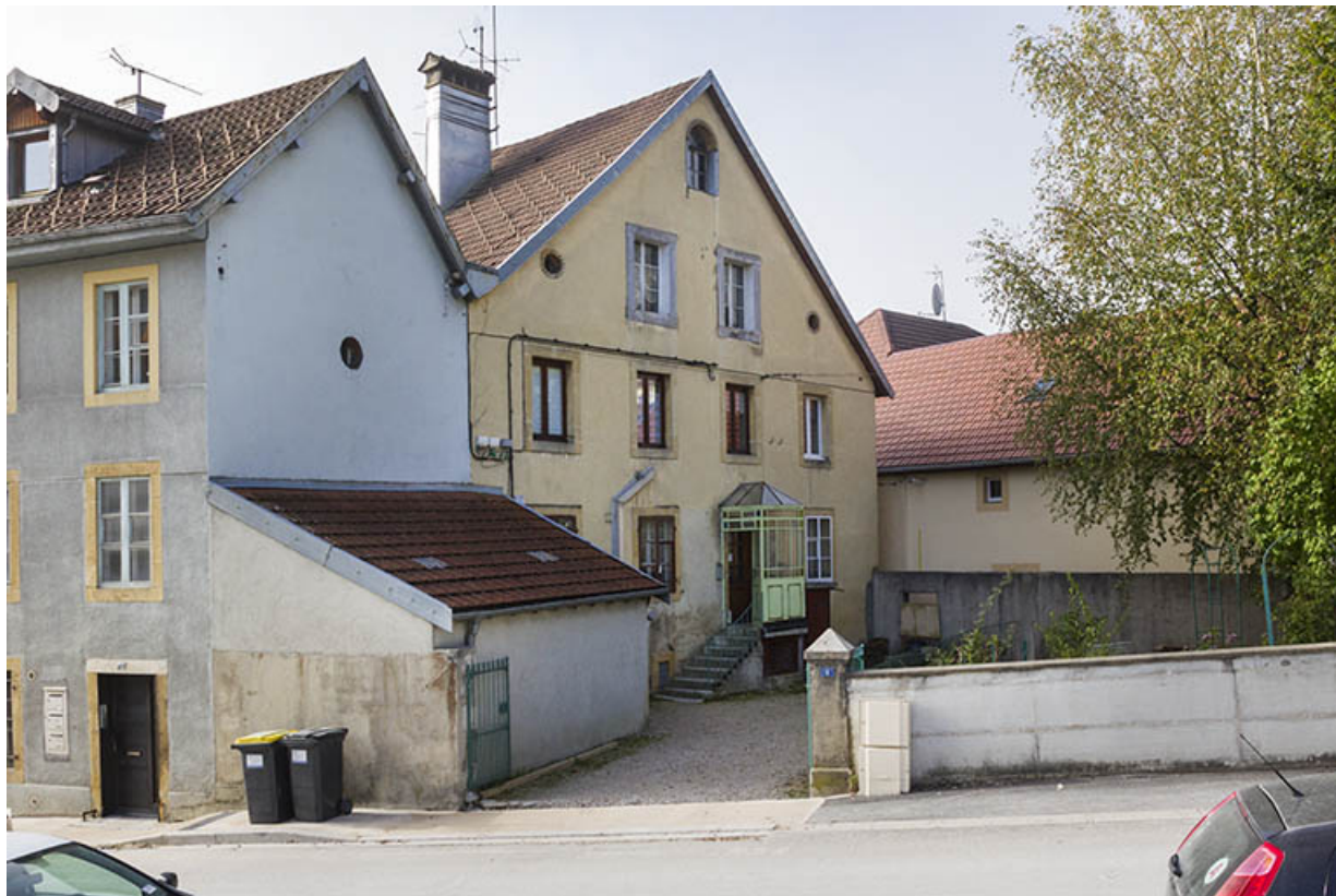
Façade postérieure, de trois quarts gauche. 25, Morteau, 4 rue de la Chaussée
