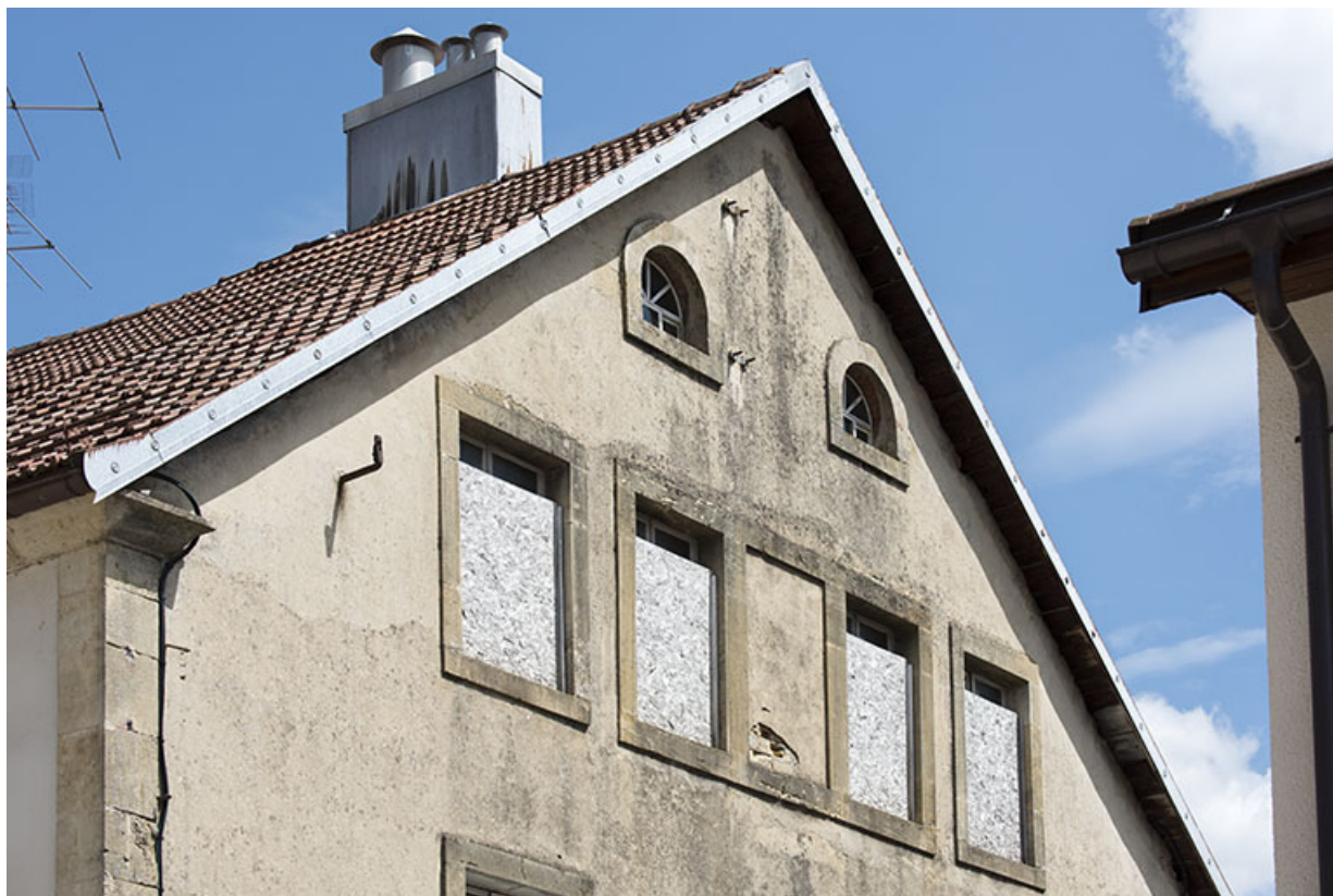
Façade latérale droite : fenêtres multiples dans le pignon.
