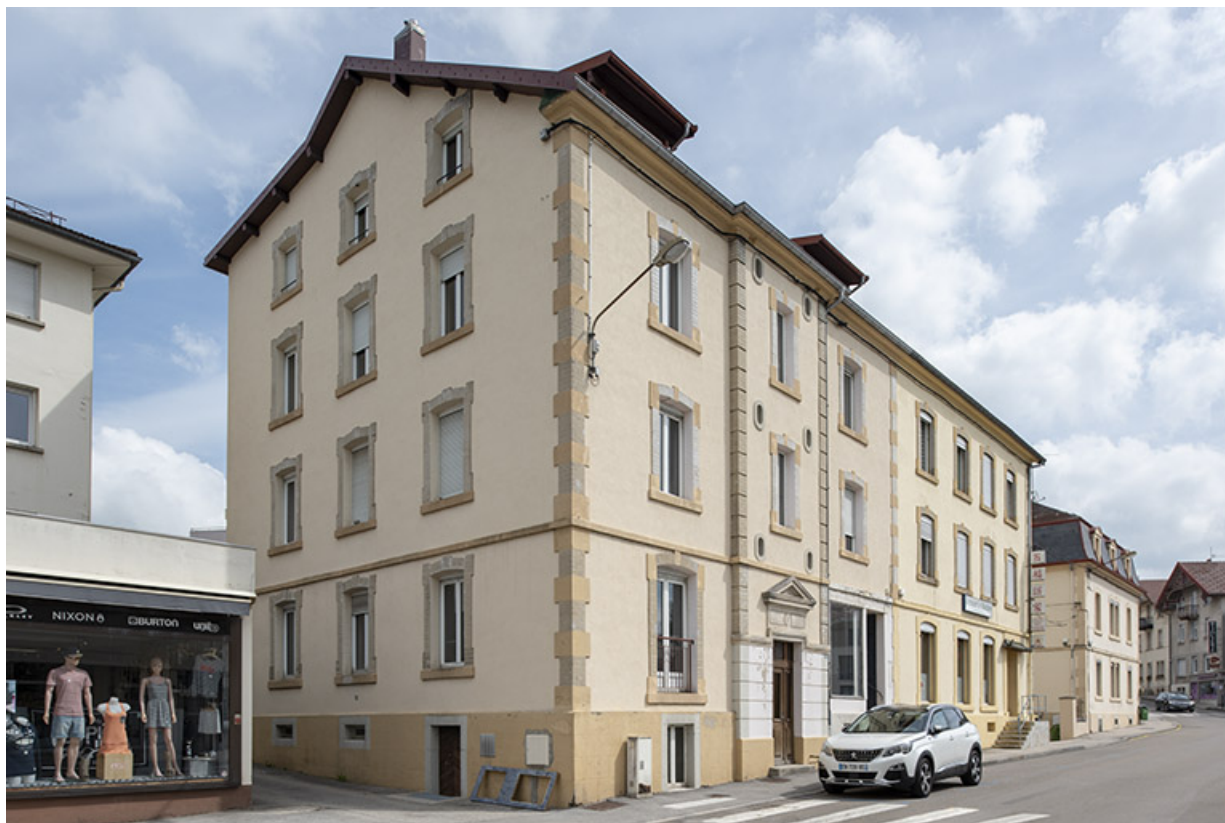
Bâtiment sur rue : façades antérieure et latérale gauche.
