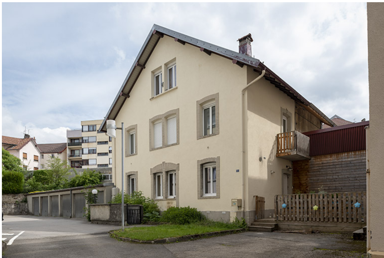
Bâtiment sur cour : façades antérieure et latérale droite.
