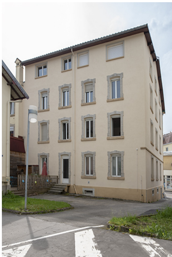
Bâtiment sur rue : façade postérieure, de trois quarts droite. 25, Morteau, 12 et 12 bis rue Pasteur
