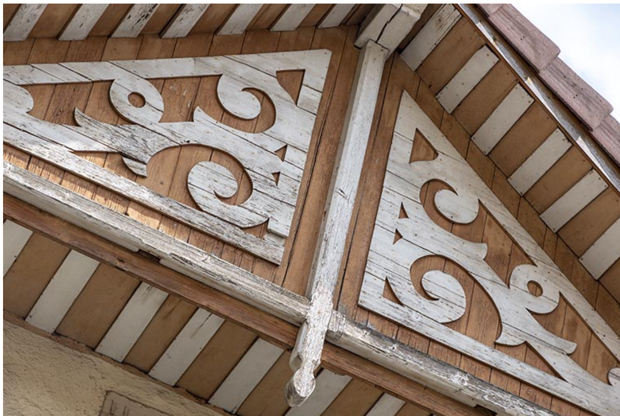
Maison au n° 1 rue Pasteur, façade antérieure : décor du pignon. 25, Morteau, 1-3 rue Pasteur
