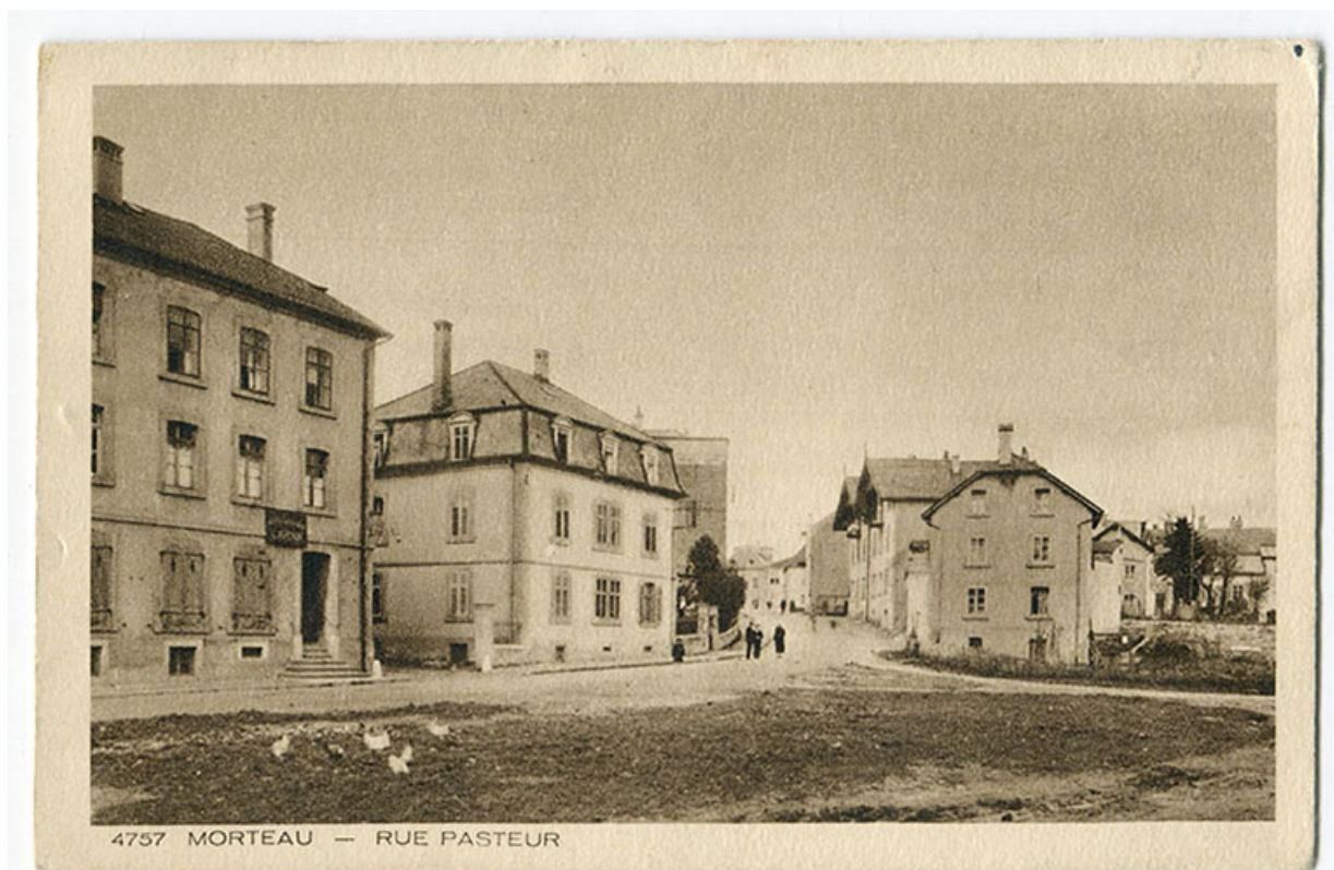
4757 Morteau - Rue Pasteur, 1ère moitié 20e siècle. Les maisons sont visibles au deuxième plan à droite. 25, Morteau
