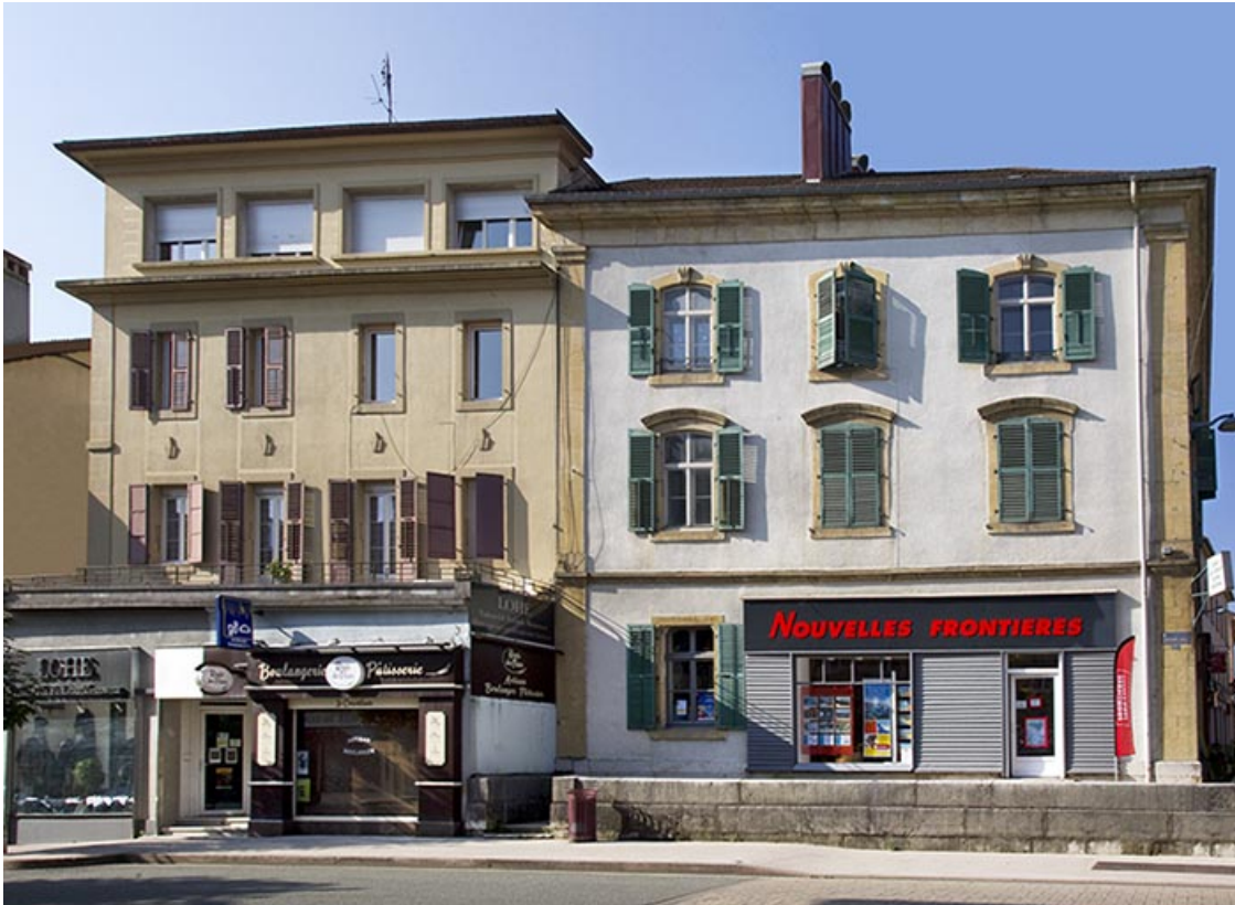
Vue d'ensemble de la façade latérale gauche (21 Grande Rue), avec le bâtiment au 19 Grande Rue. 25, Morteau
