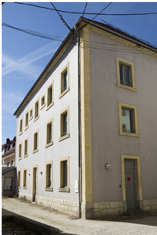
Façade postérieure, vue en enfilade. 25, Morteau, 3 place de l' Hôtel de Ville
