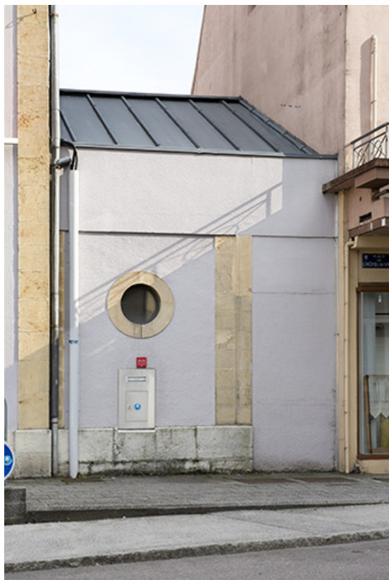
Façade antérieure : vestige de l'atelier de fabrication.
