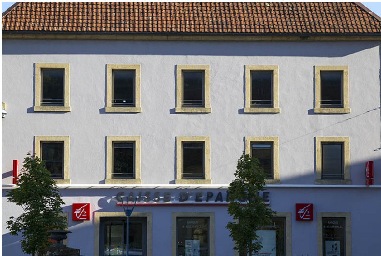
Façade antérieure : fenêtres des deux étages carrés.
