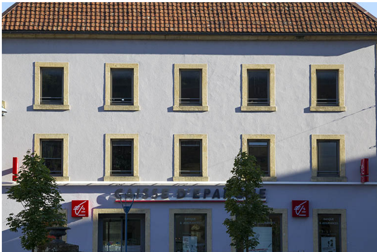
Façade antérieure : fenêtres des deux étages carrés.
