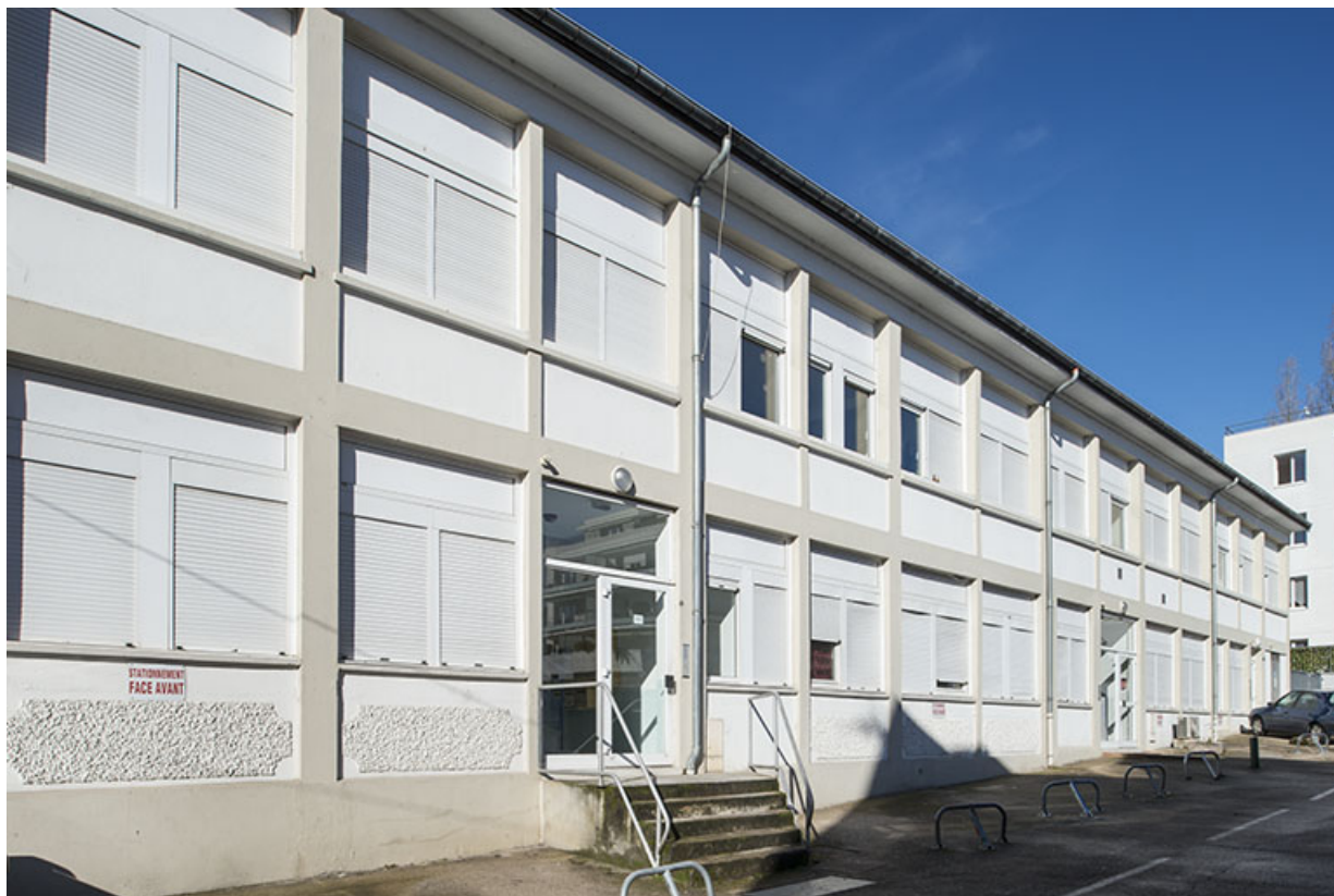
Façade est de l'atelier de fabrication. Vue de trois quarts gauche.
