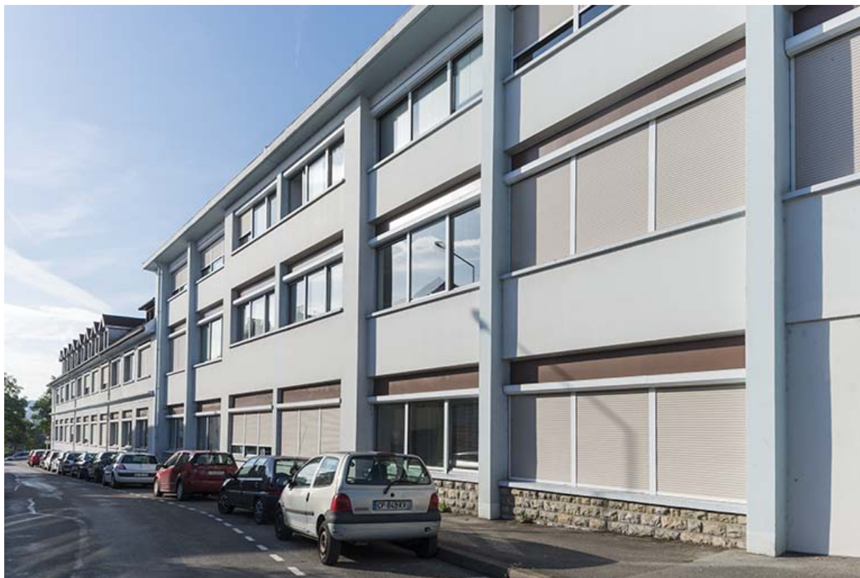
Façade ouest sur la rue Eugène Savoye. 25, Besançon, 11 bis rue Nicolas Bruand
