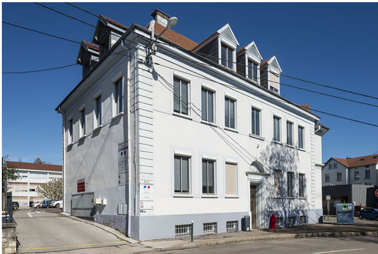
Bâtiment des bureaux, vu de trois quarts gauche.
