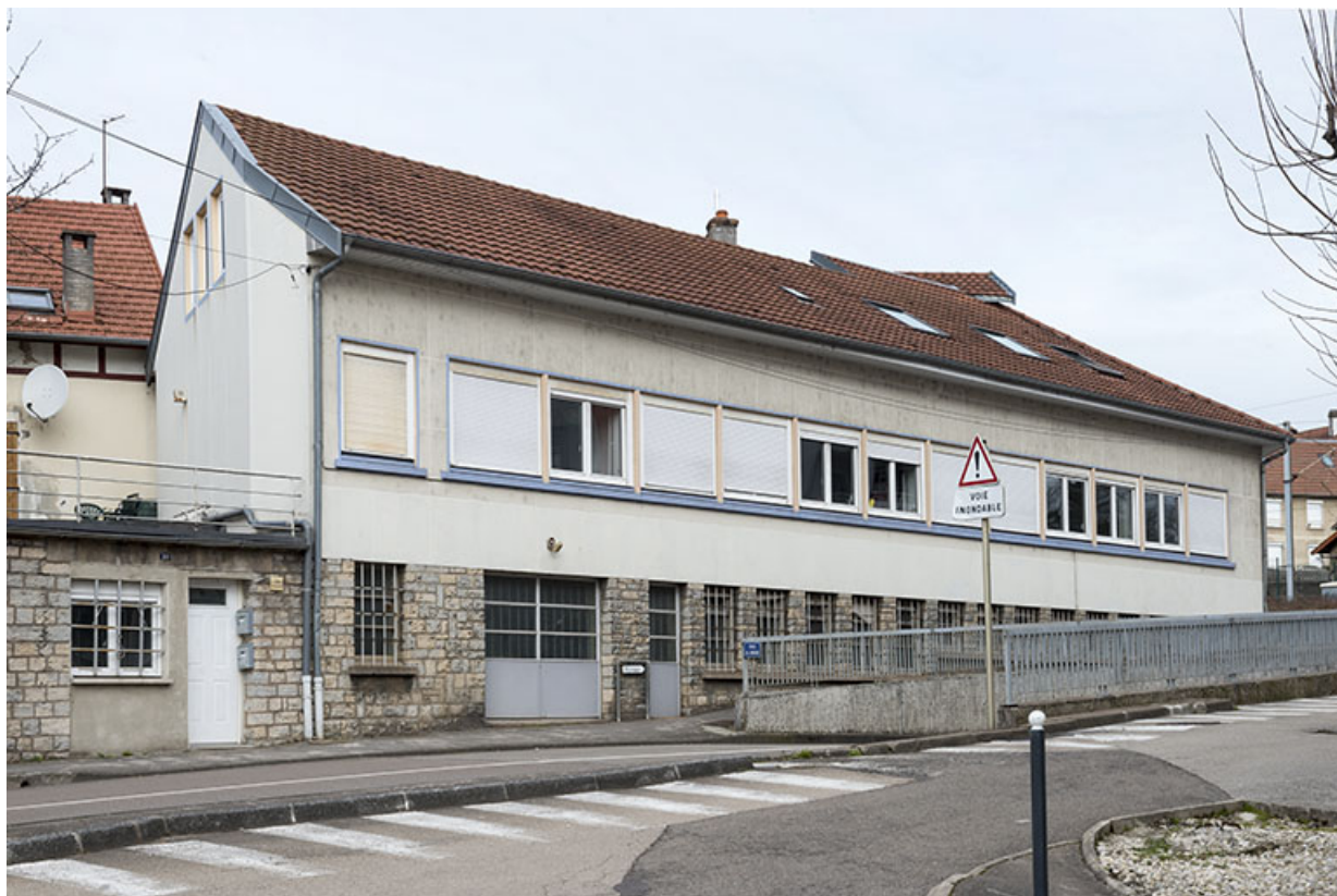
Vue d'ensemble depuis le sud. 25, Besançon, 26 rue de l' Église
