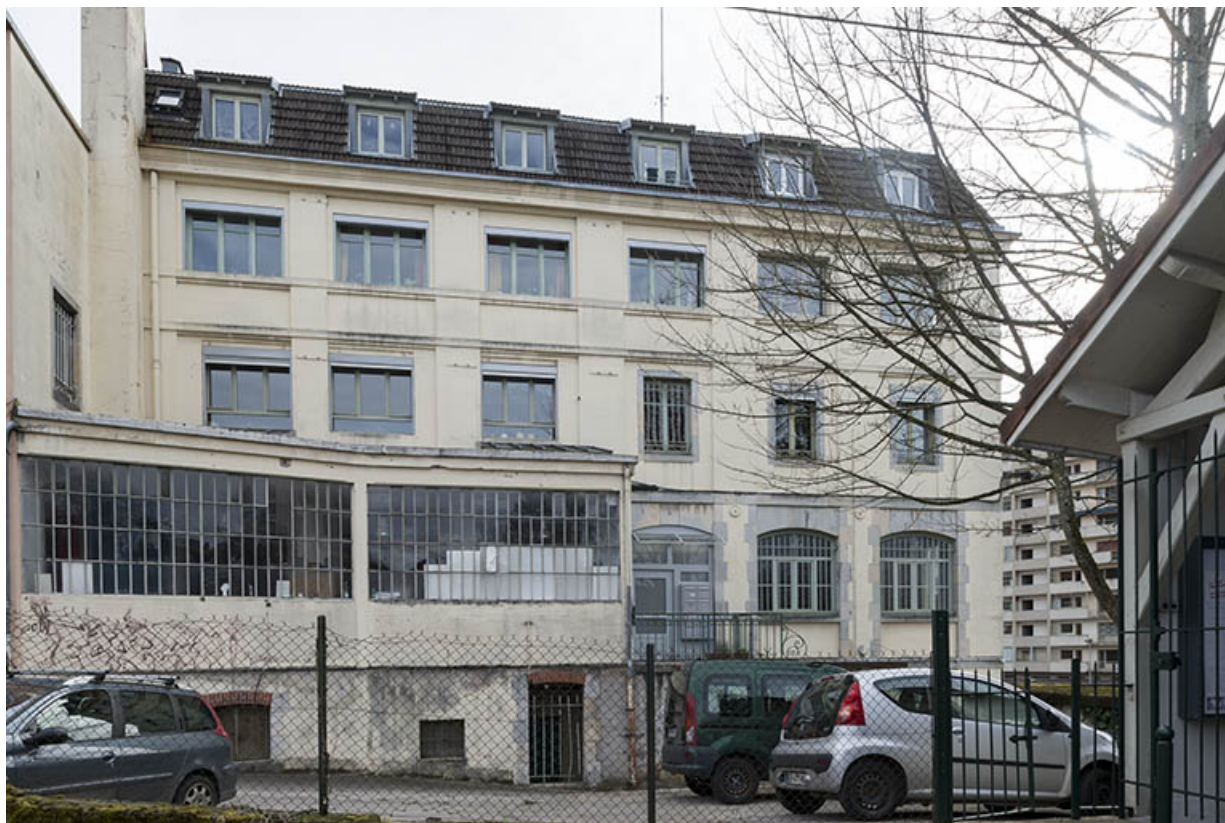
Façade nord de l'atelier principal.
