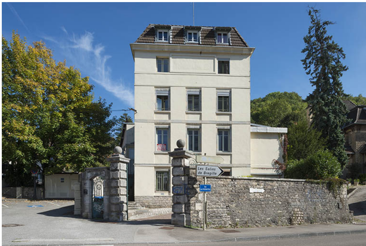
Façade ouest de l'atelier de fabrication.
