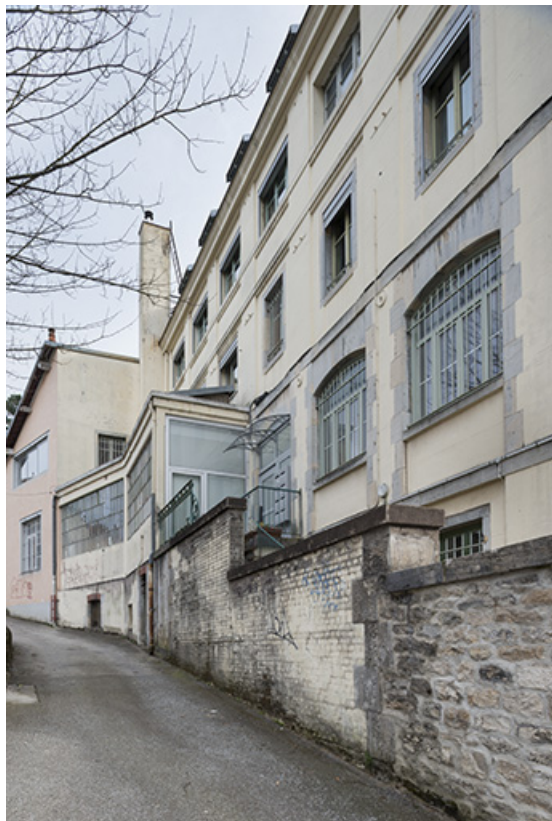
Élévation de la façade nord de l'atelier principal.
