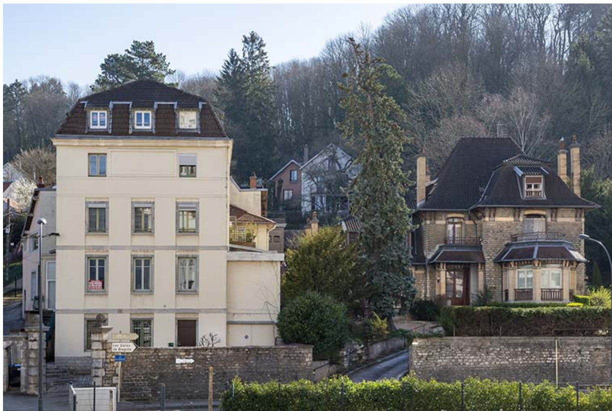
Façade ouest de l'atelier de fabrication et logement patronal.
