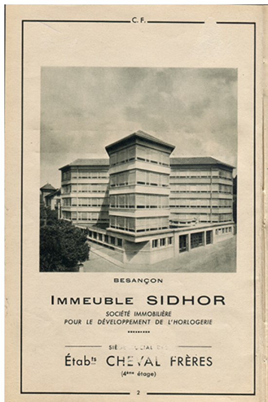
[Vue d'ensemble depuis le sud-ouest], 1950. 25, Besançon, 23 rue de la Mouillère
