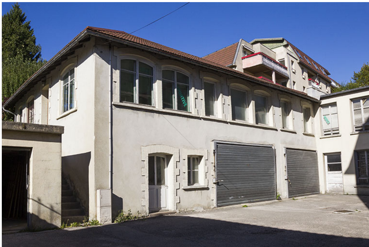
Immeuble et ateliers d'horlogerie Les Fils d'Edouard Wetzel (12 rue de la Gare) : atelier de bracelets de montre Schoepf et Cie, dans la cour.
