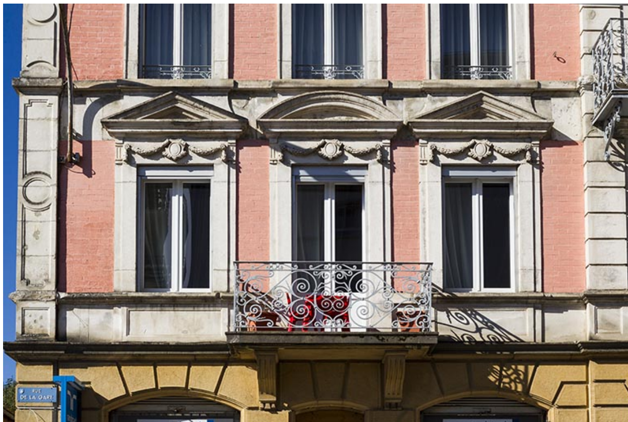
Façade antérieure : baies du premier étage (partie gauche). 25, Morteau, 12 rue de la Gare
