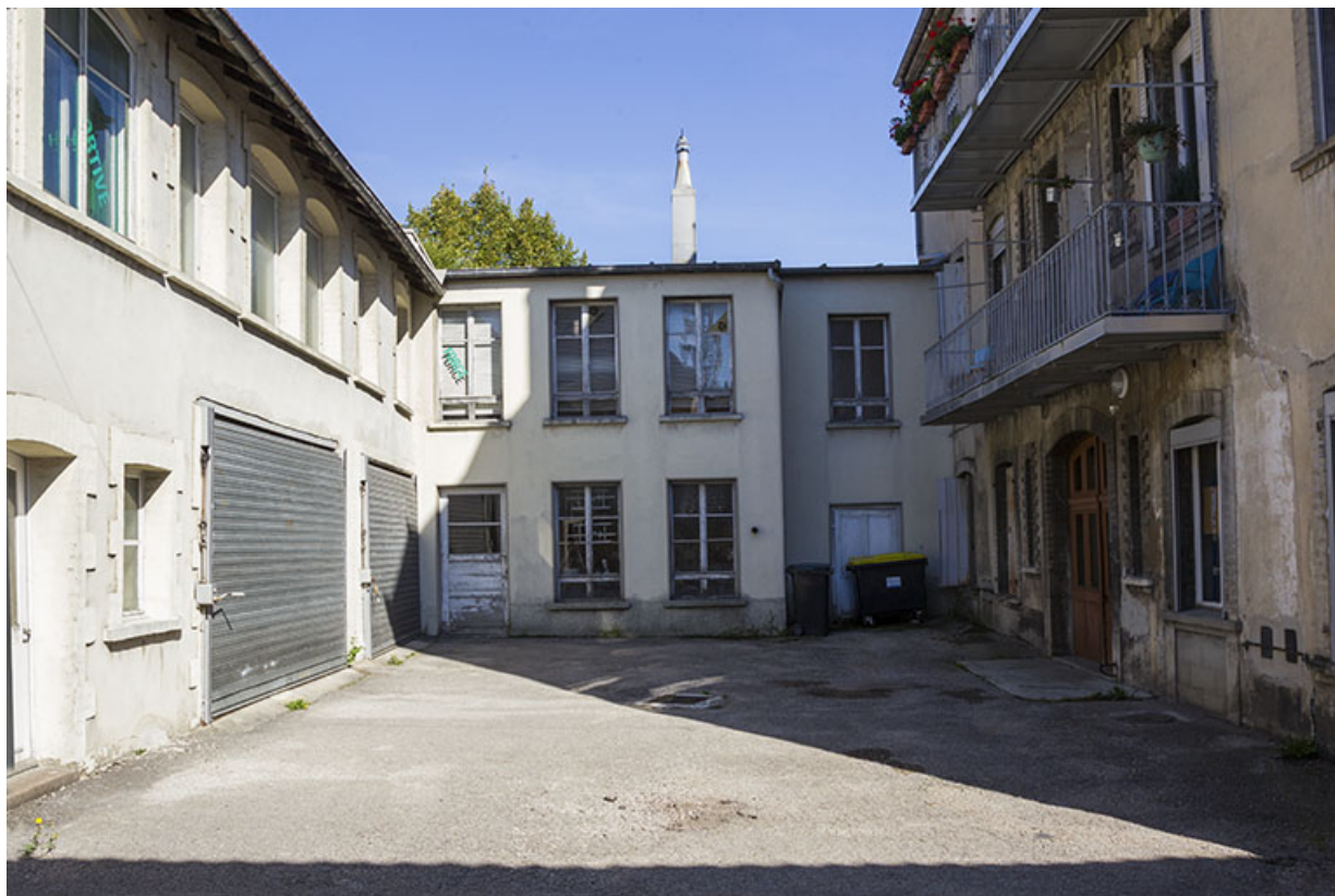
Cour et corps de bâtiment latéral.
