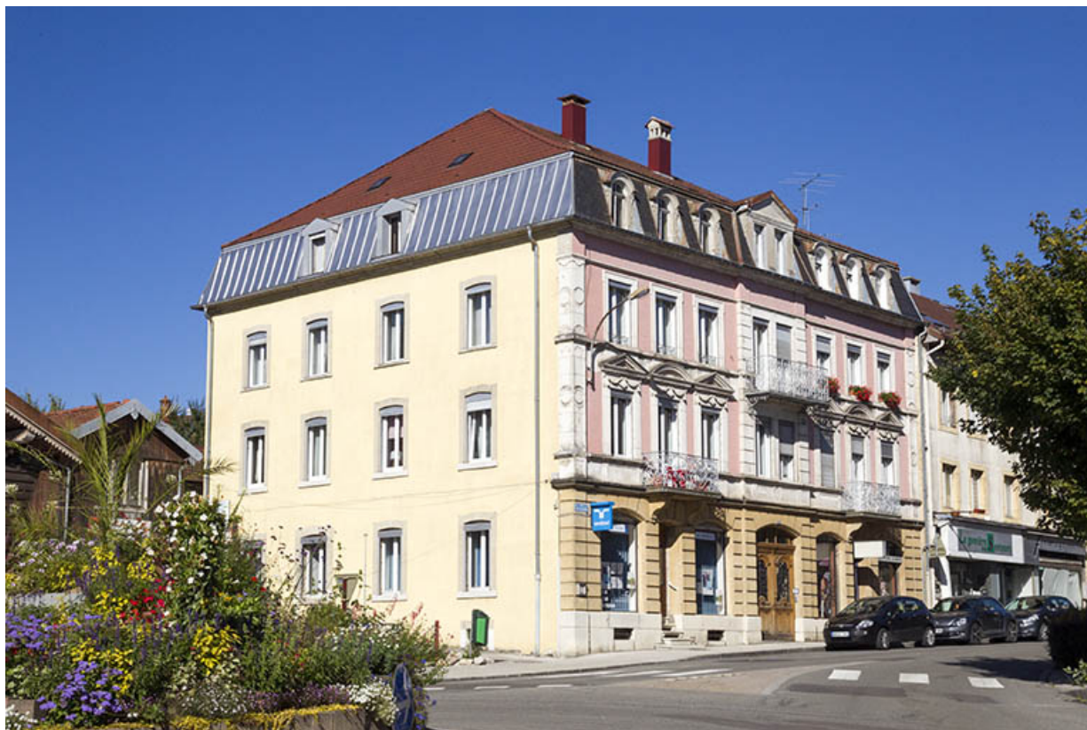
Immeuble et fabrique de montres Les Fils d'Edouard Wetzel puis Montres Thalès, à Morteau. 25, Morteau
